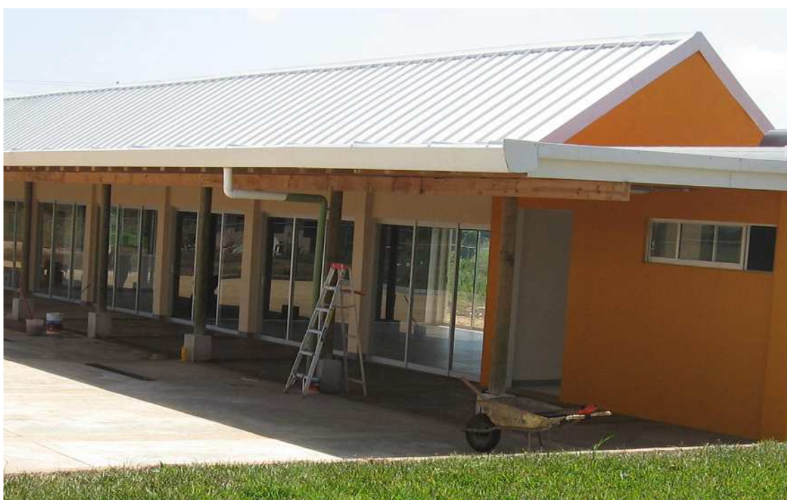
Aulas en proceso de construcción. Foto: Archivo InterSaberes
