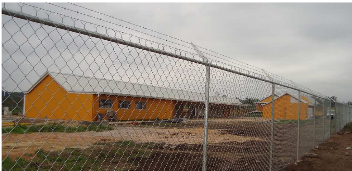
Fachada de la nueva sede. Foto: Archivo InterSaberes
