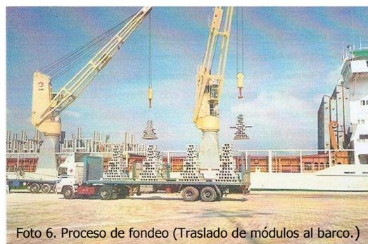
Foto 6. Proceso de fondeo (Traslado de módulos al barco.)
