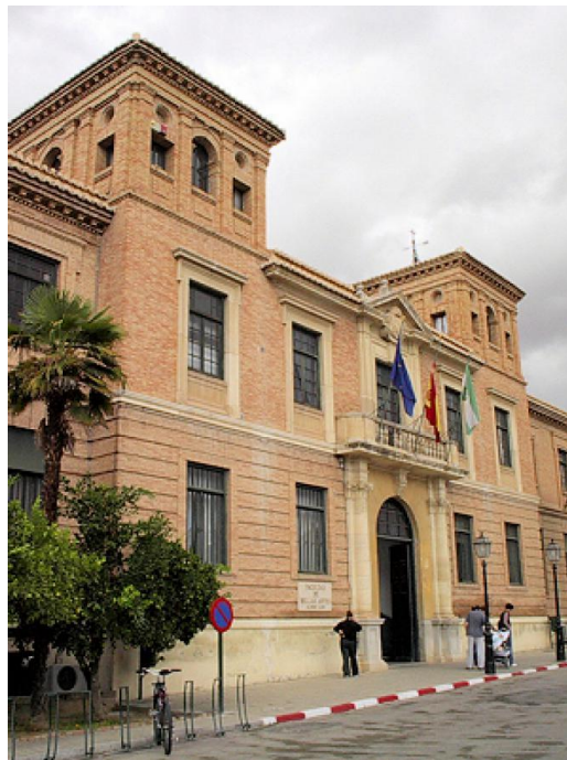
Figura 41. Fachada de la Facultad de Bellas Artes de Granada.
