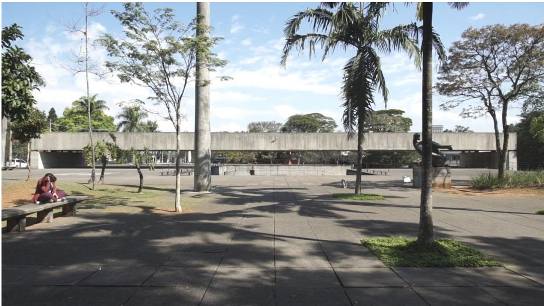
Figura 114. Vista exterior del MuBE.
