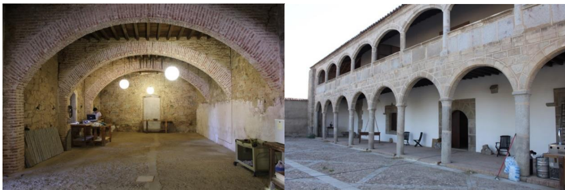
Figuras 51 y 52. Interior y exterior de los espacios de La Fragua.
