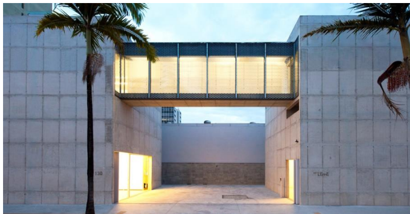
Figura 82. Instalaciones de la nueva Galería Leme.
