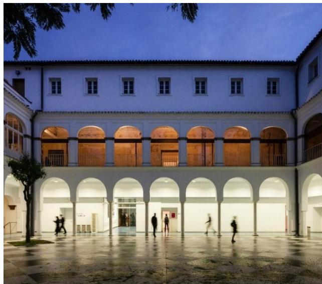
Figura 40. Patio interior del CICUS Sevilla.
