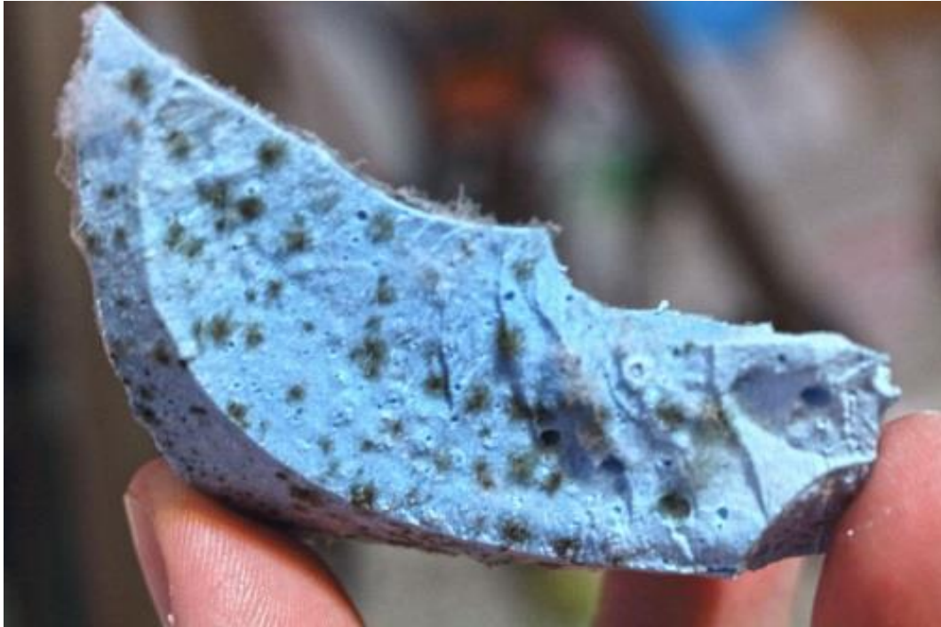
Figura 14: José Javier Ángeles Alejo. (2017) Deterioro por humedad . Fotografía digital. Aparición de moho cinco días después del proceso de fraguado.
