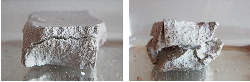
Figura 3: José Javier Ángeles Alejo. (2017) Izquierda: inicio del agrietamiento de la superficie provocado por una absorción masiva de agua. Fotografía digital. Derecha: rotura de la superficie por absorción masiva de agua. Eliminación de la adherencia y la compactación por aumento de tamaño de los microgránulos.
