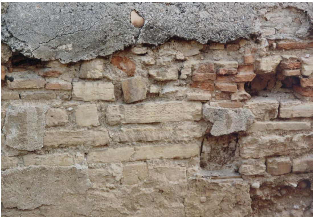
Detalles del muro suroeste del Monasterio de San Jerónimo.
