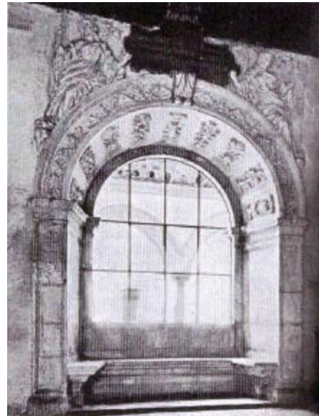
Arco interior de la Capilla.
