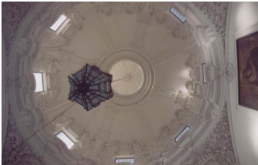
Bóveda de la escalera. Monasterio de San Jerónimo.
