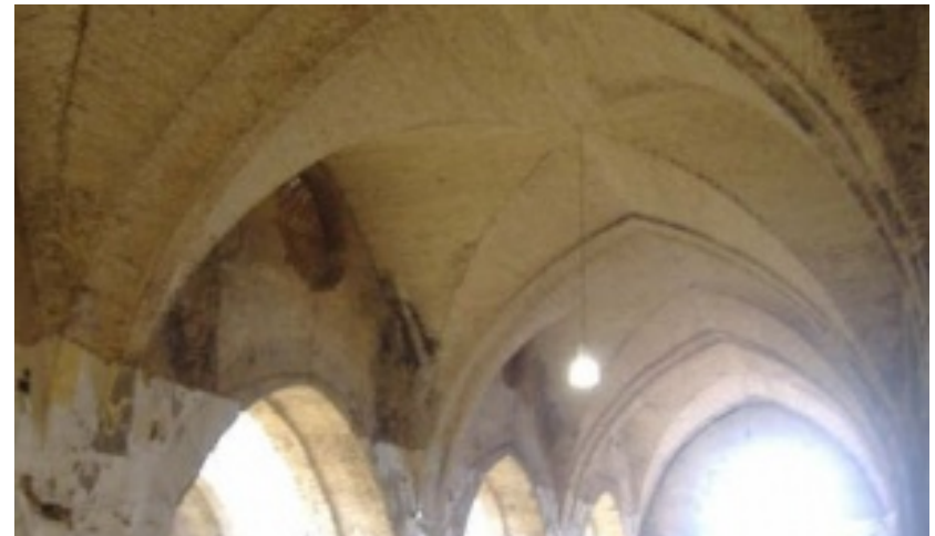
Bóvedas de arista en las Atarazanas reales-Sevilla
