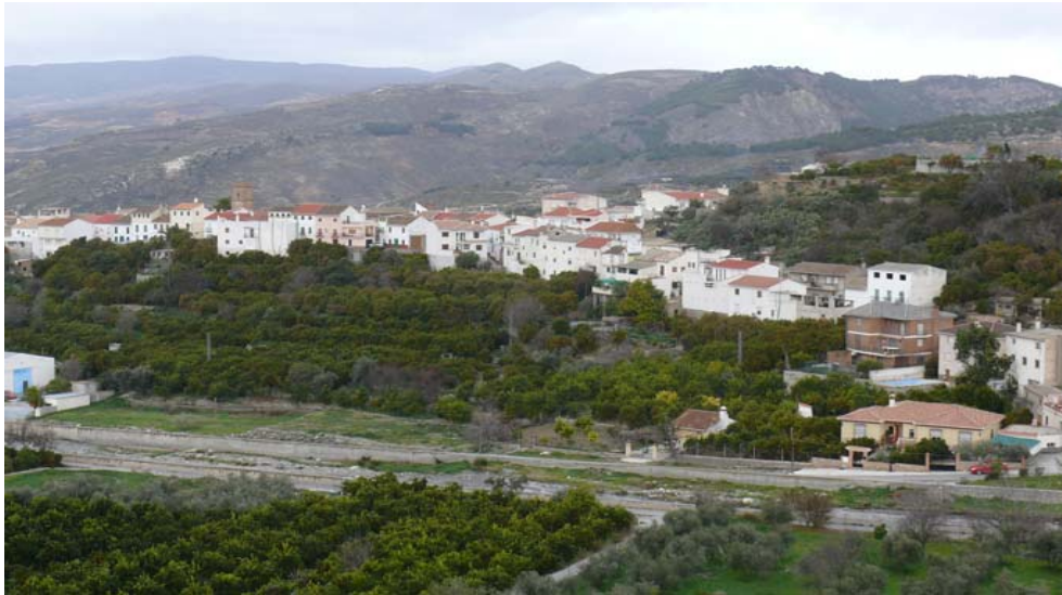
Vista del lugar de Murchas
