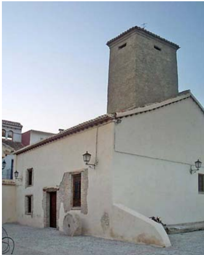
Fachada de entrada al molino
