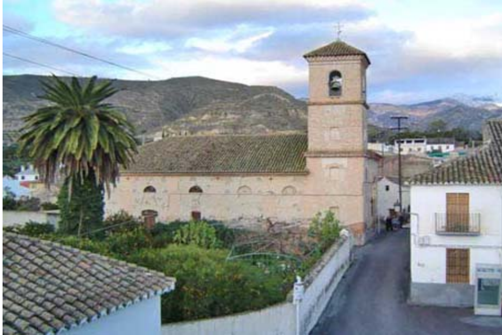
Vista exterior de la Iglesia de Murchas
