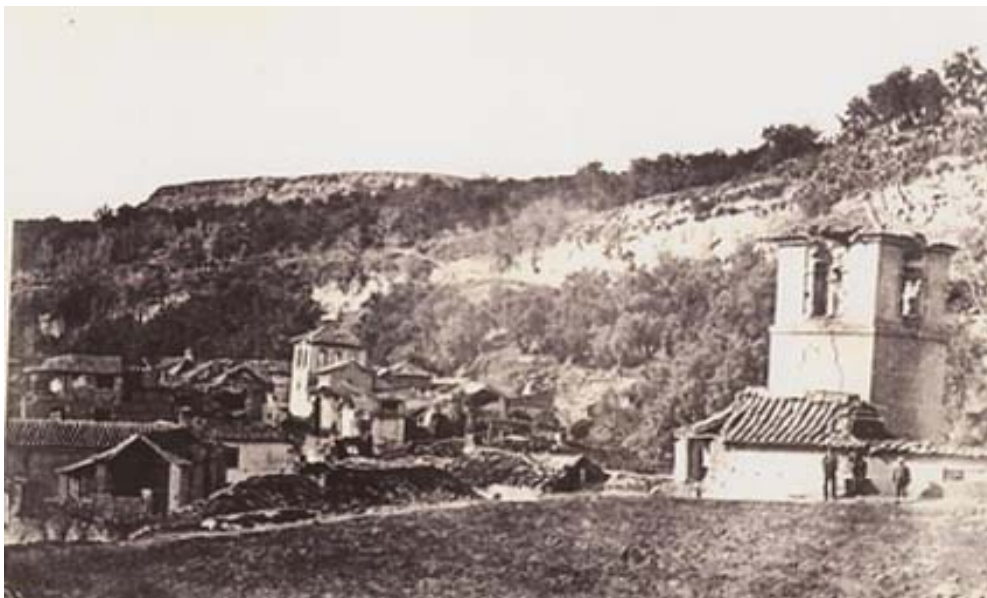
Imagen de la Iglesia después del terremoto
