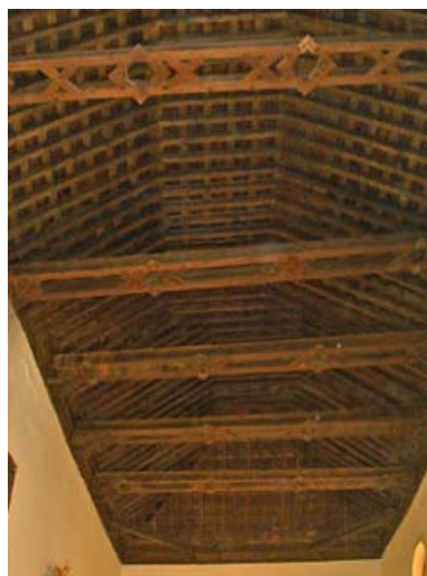
Cubierta de la nave interior
