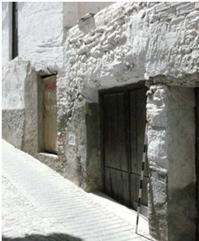
Aljibe en la Calle del Agua
