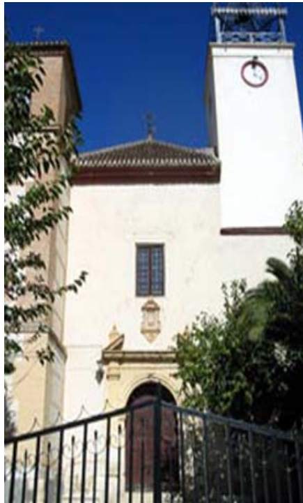
Fachada principal de la Iglesia
