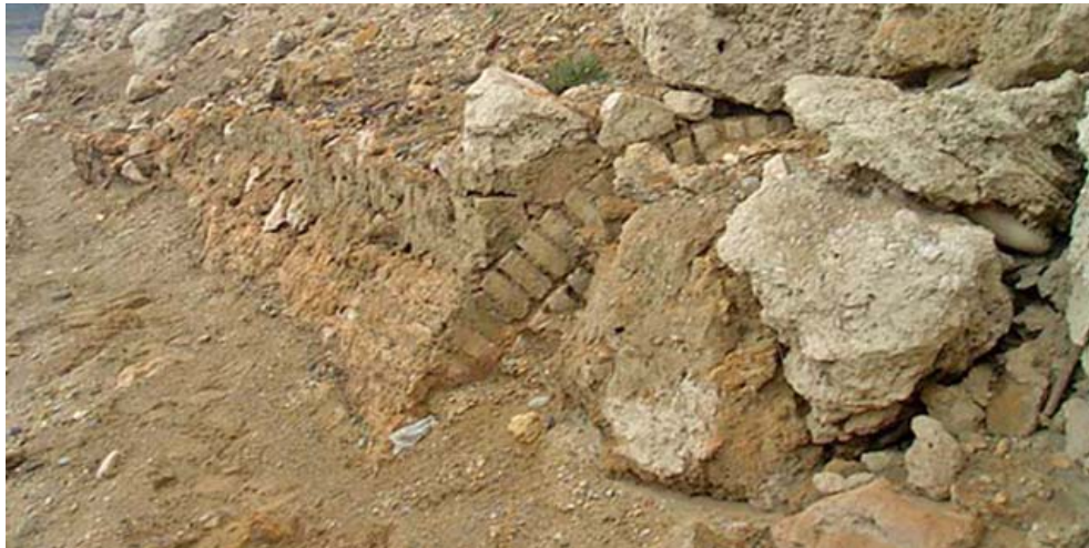
Bóveda de una acequia en Restábal
