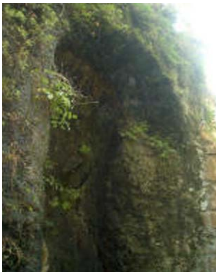
Uno de los arcos de la Acequia de los Arcos
