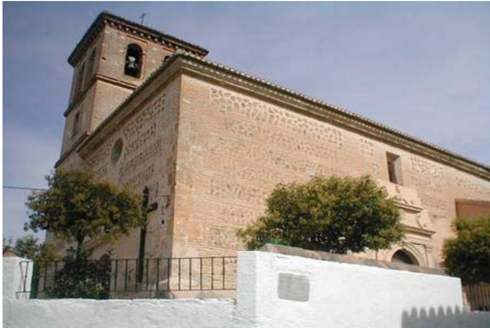
Fachada y torre de la Iglesia de Mondújar
