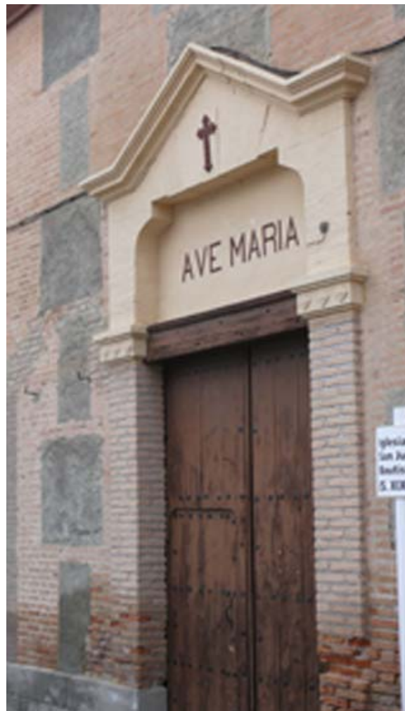
Puerta de la Iglesia de Murchas
