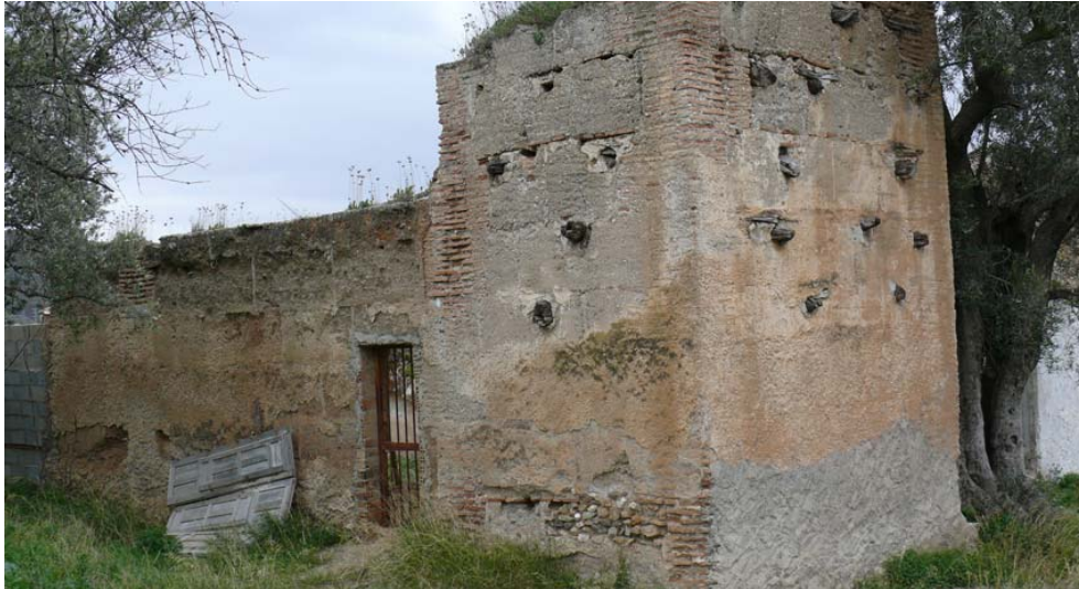
Torre Fortaleza de El Tablete
