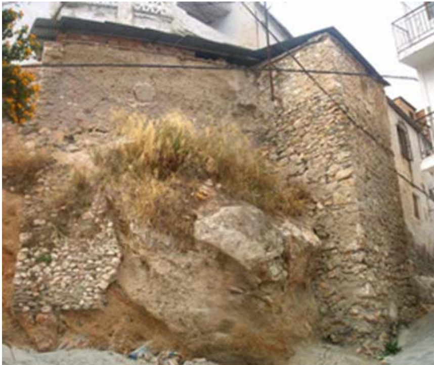
Restos de muralla y torre de alquería
