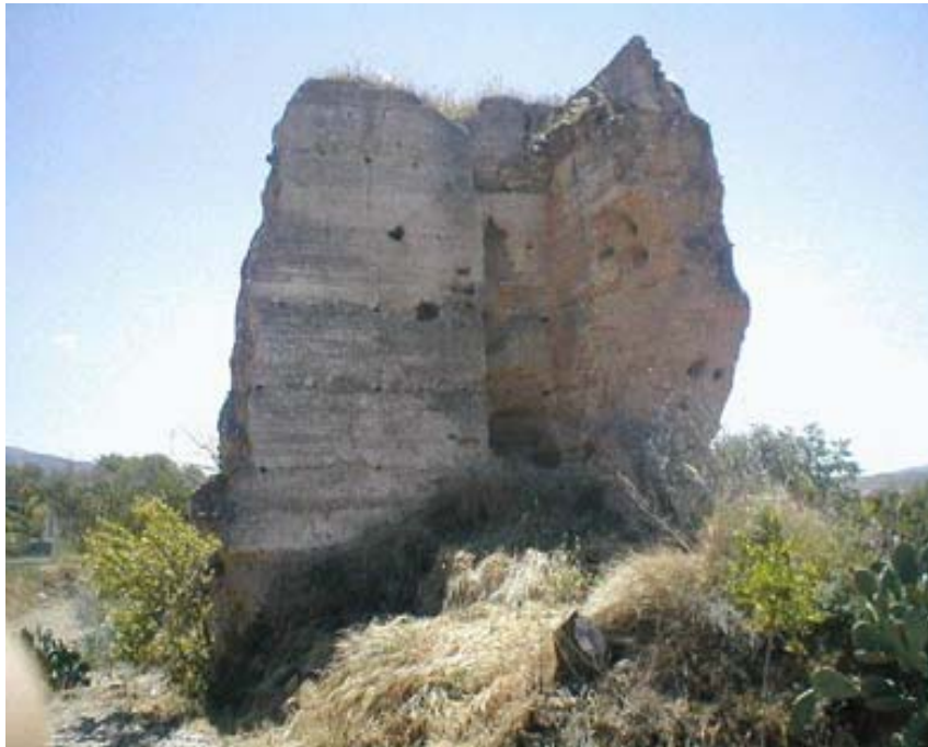
Restos esquina muralla Fuerte
