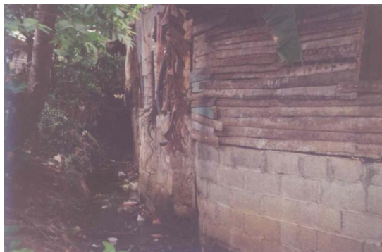
FOTOGRAFIA 8. Casa de láminas de madera y blocs. San Francisco
