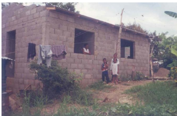
FOTOGRAFIA 9. Casa de blocs. San Francisco
