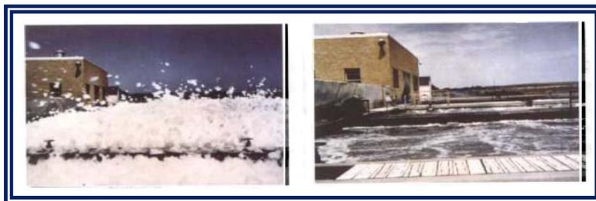
**Figura 1.25- Formación de espuma antes de la síntesis del LAS y después.**
