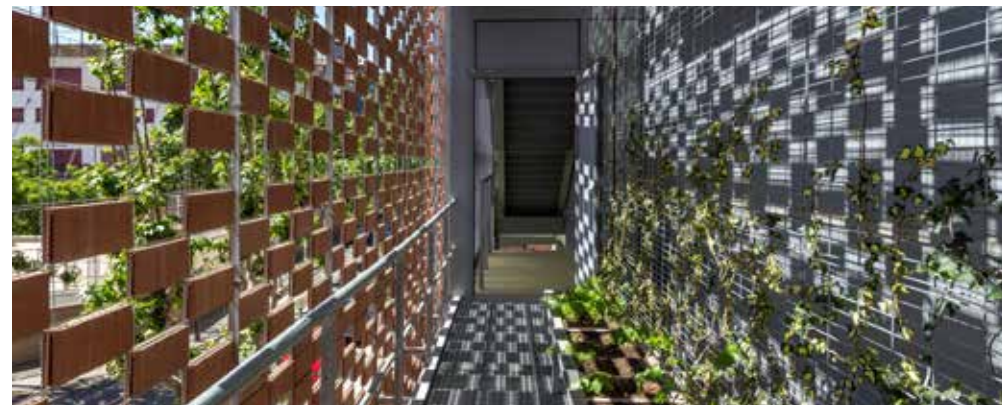
AMPLIACIÓN DEL COLEGIO TERESIANAS DE GAUDÍ (BARCELONA). ARQUITECTO: EQUIPO PICH-AGUILERA LÁMINA PREFABRICADA "FLEXBRICK" UTILIZADA COMO UNA CELOSÍA QUE REINTERPRETA LOS SISTEMAS TRADICIONALES DE USO DE LA CERÁMICA Y PROPORCIONA ESPACIOS DE SOMBRA.
