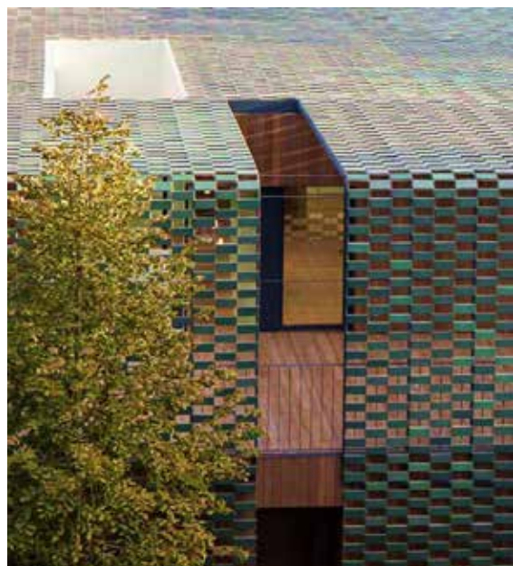
IMAGEN DERECHA: TR HOUSE (BARCELONA). ARQUITECTOS: MAXIMILIA TORRUELLA I CASTEL, PATRICIO MARTÍNEZ GONZALEZ. APLICACIÓN DEL TEJIDO "FLEXBRICK" ESMALTADO UTILIZADO EN CUBIERTA Y FACHADA COMO UNA CELOSÍA.
