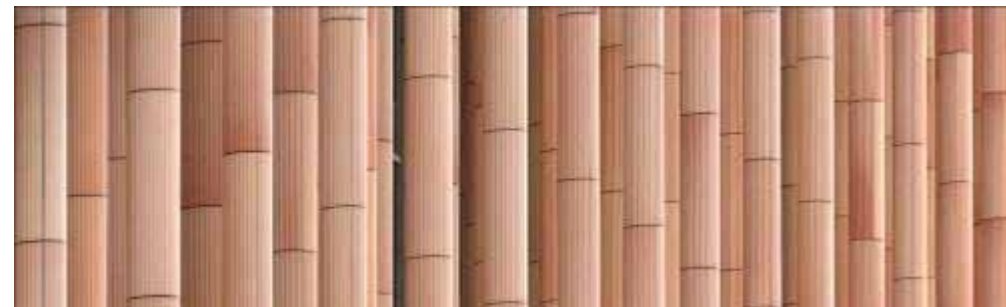
PABELLÓN DE ESPAÑA EN LA EXPO DE ZARAGOZA. ARQUITECTO: FRANCISCO MANGADO. ESTRUCTURA DE COLUMNAS CERÁMICAS DESARROLLADA POR CERÁMICA CUMELLA (PREMIO ASCER 2008)
