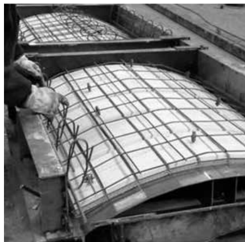
CASA FCK (BARCELONA). ARQUITECTO: JUAN TRIAS DE BES. DETALLE CONSTRUCTIVO DE LAS BÓVEDILLAS CERÁMICAS PREFABRICADAS REALIZADAS A PARTIR DEL TEJIDO "FLEXBRICK" E IMÁGENES DEL PROCESO DE FABRICACIÓN Y COLOCACIÓN EN LA CASA FCK.
