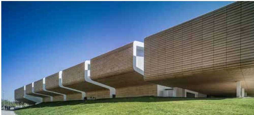
VISTAS DE LA FACHADA DE LA ESCUELA DE MAGISTERIO DE GRANADA REVESTIDA POR LAS PIEZAS CERÁMICAS.
