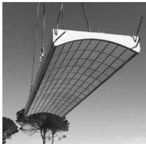
CASA FCK (BARCELONA). ARQUITECTO: JUAN TRIAS DE BES. DETALLE CONSTRUCTIVO DE LAS BÓVEDILLAS CERÁMICAS PREFABRICADAS REALIZADAS A PARTIR DEL TEJIDO "FLEXBRICK" E IMÁGENES DEL PROCESO DE FABRICACIÓN Y COLOCACIÓN EN LA CASA FCK.
