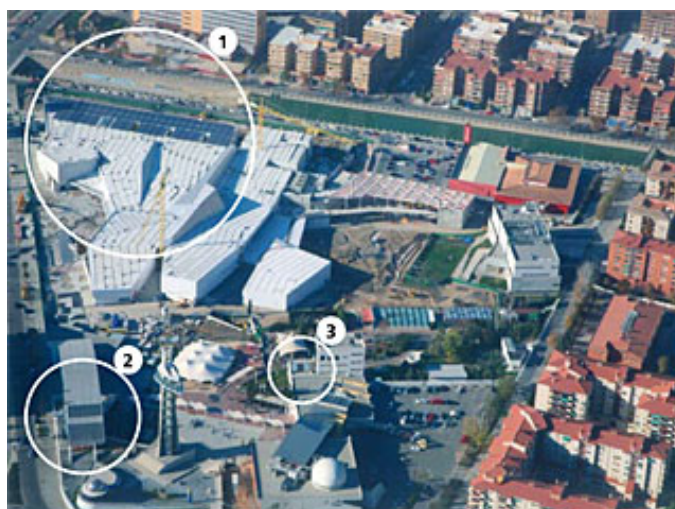
Instalaciones de energía solar.
