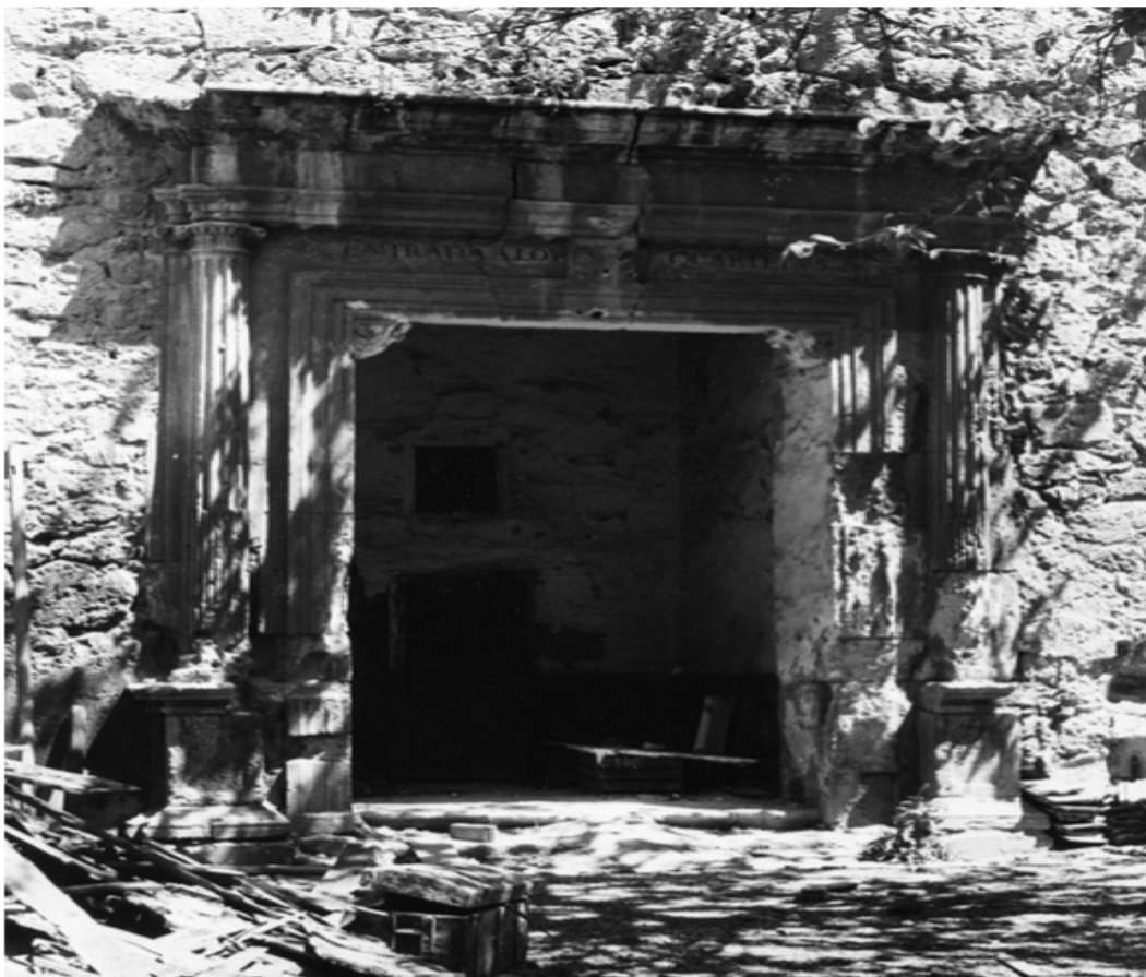
Portada del Patio del Archivo, actual acceso a la Biblioteca, antes de la intervención de 1966. Procedente de: ROMERO GALLARDO, A. «Restauración y reutilización de un edificio histórico tras la Autarquía: el Hospital Real de Granada». En: Cuadernos de Arte de la Universidad de Granada , 42 (2011).
