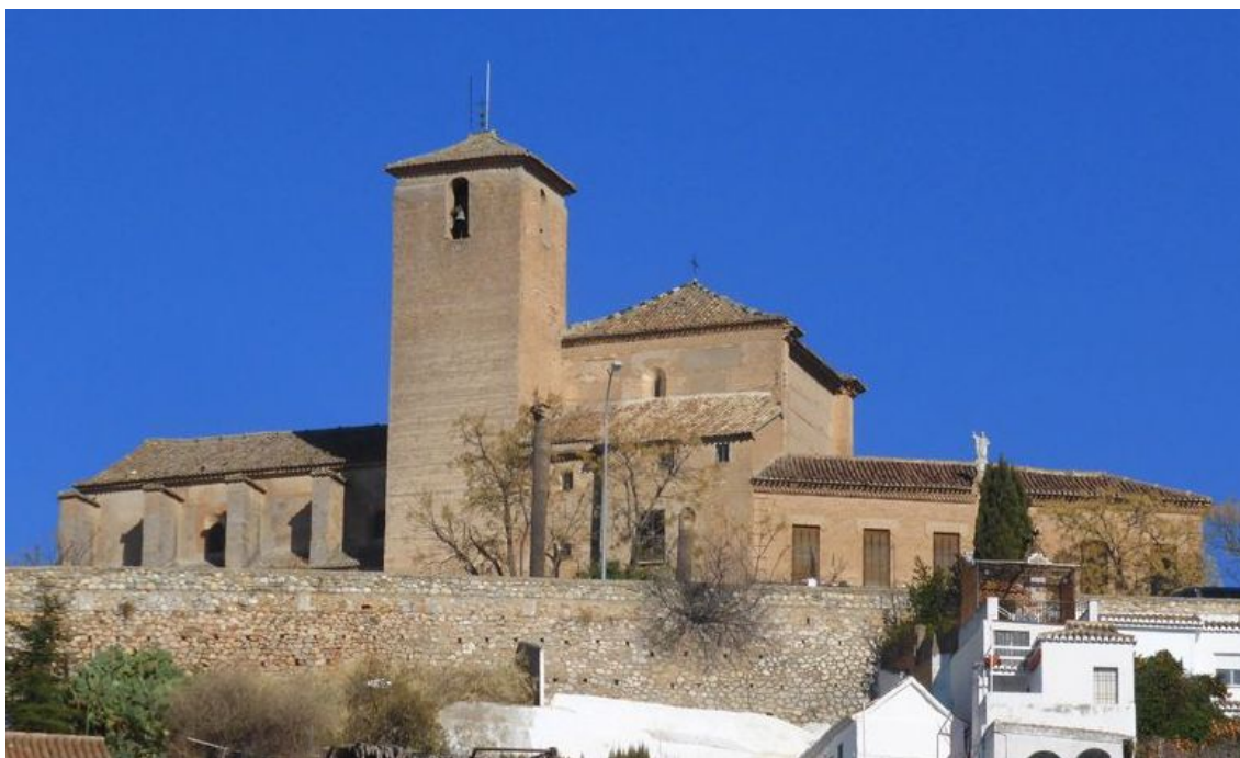
Iglesia de San Cristóbal en su estado actual.
