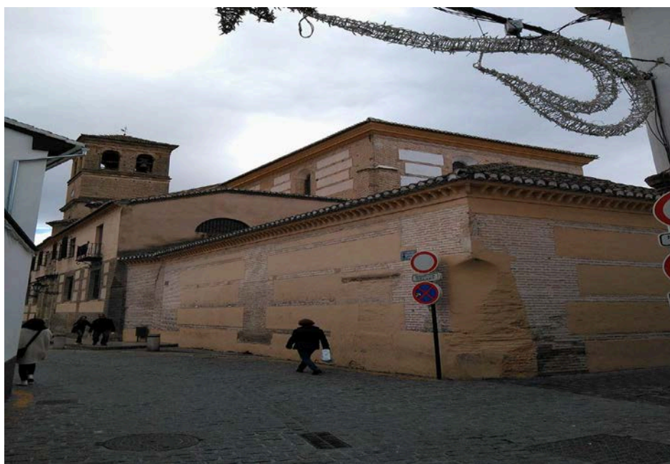
Cuerpo anexo a la iglesia que da paso a la conocida como Puerta de Siloe, reconstruido tras el incendio.
