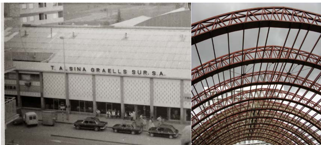
Antigua estación de Alsina Graells y estructura de su bóveda reutilizada como espacio comercial y de ocio.
