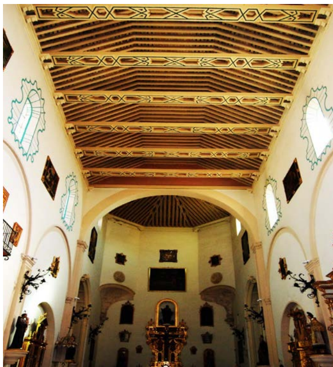
Detalle del interior del Salvador, con su artesanado de hormigón a imitación de los modelos tradicionales.
