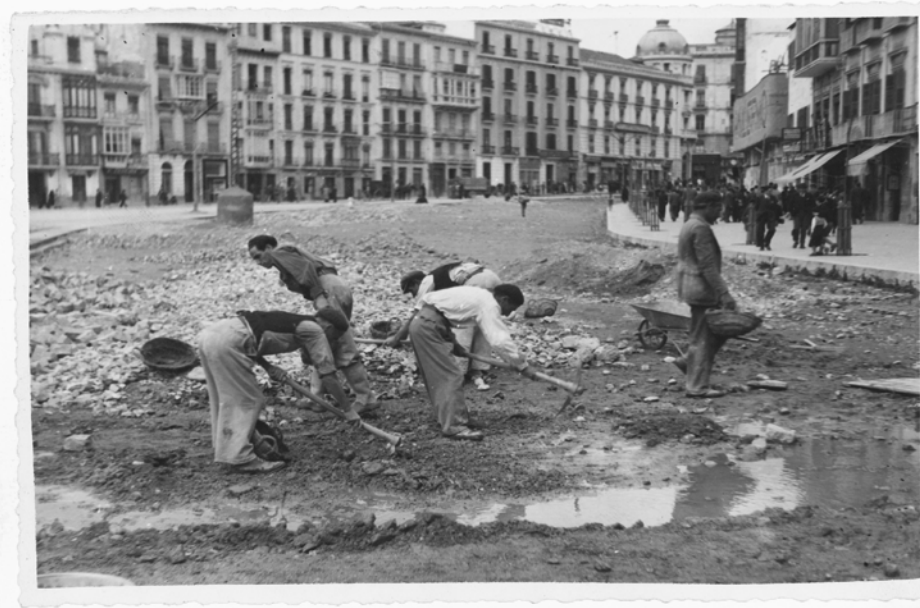
Obras sobre el embovedado a la altura de Acera del Casino.
