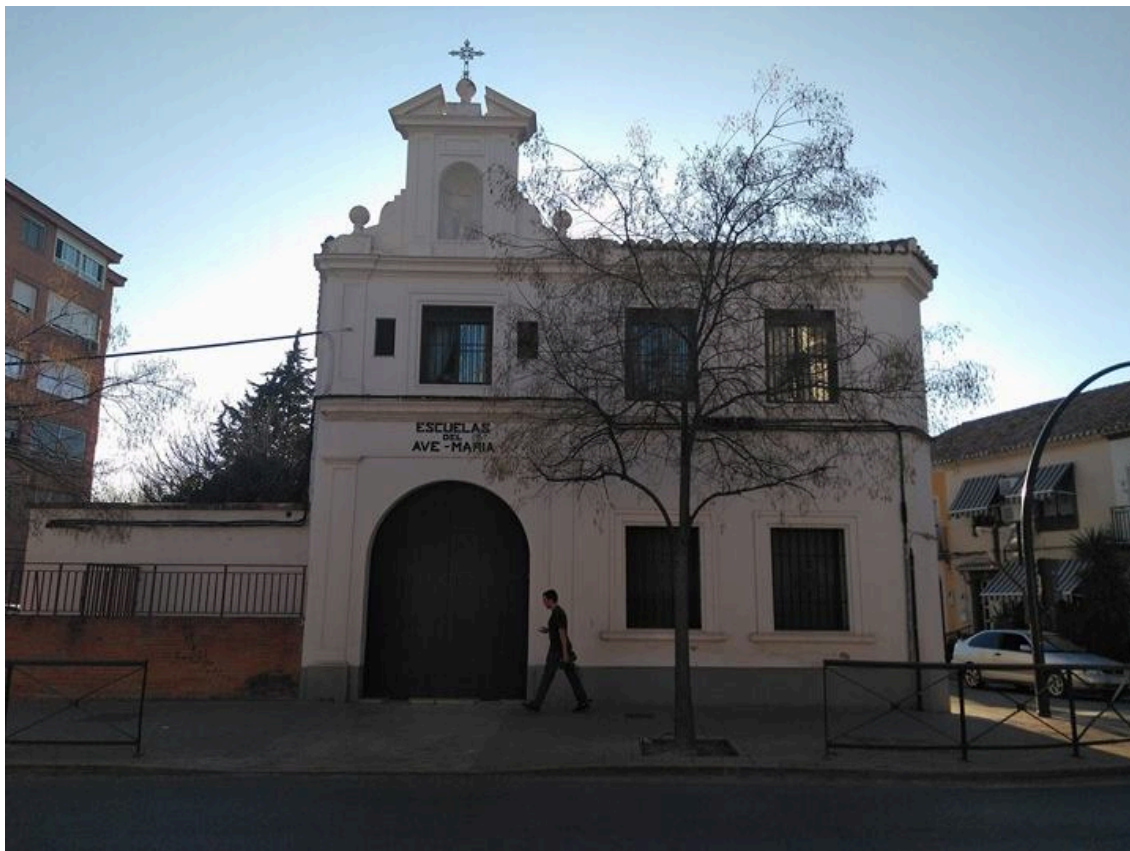
Colegio San Isidro del Ave María, detalle de la capilla.
