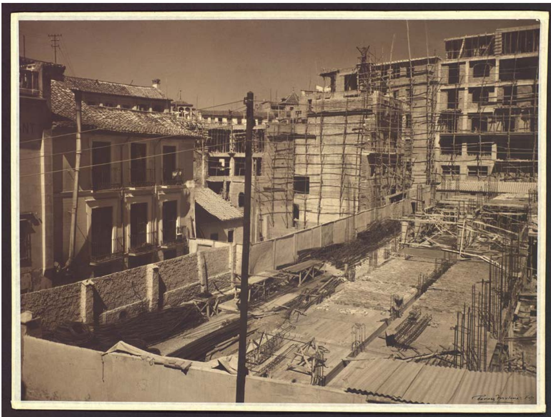
Solares traseros al Edificio de Correos. Vista de su esqueleto en hormigón armado.
