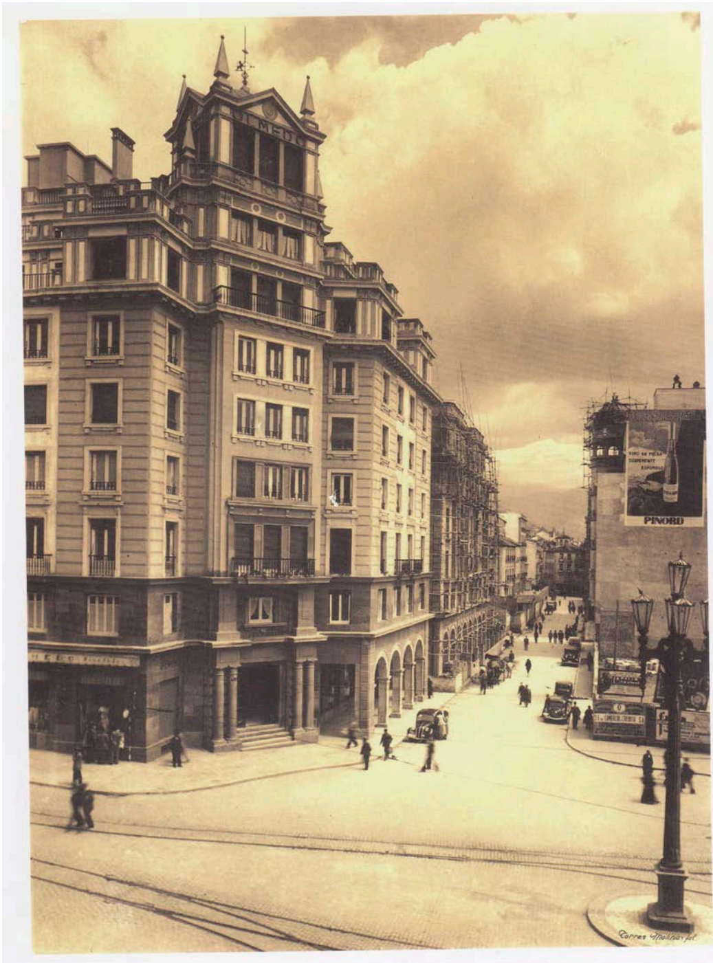
Puerta Real, Edificio Olmedo ya terminado con la sobras del Hotel Meliá al fondo.
