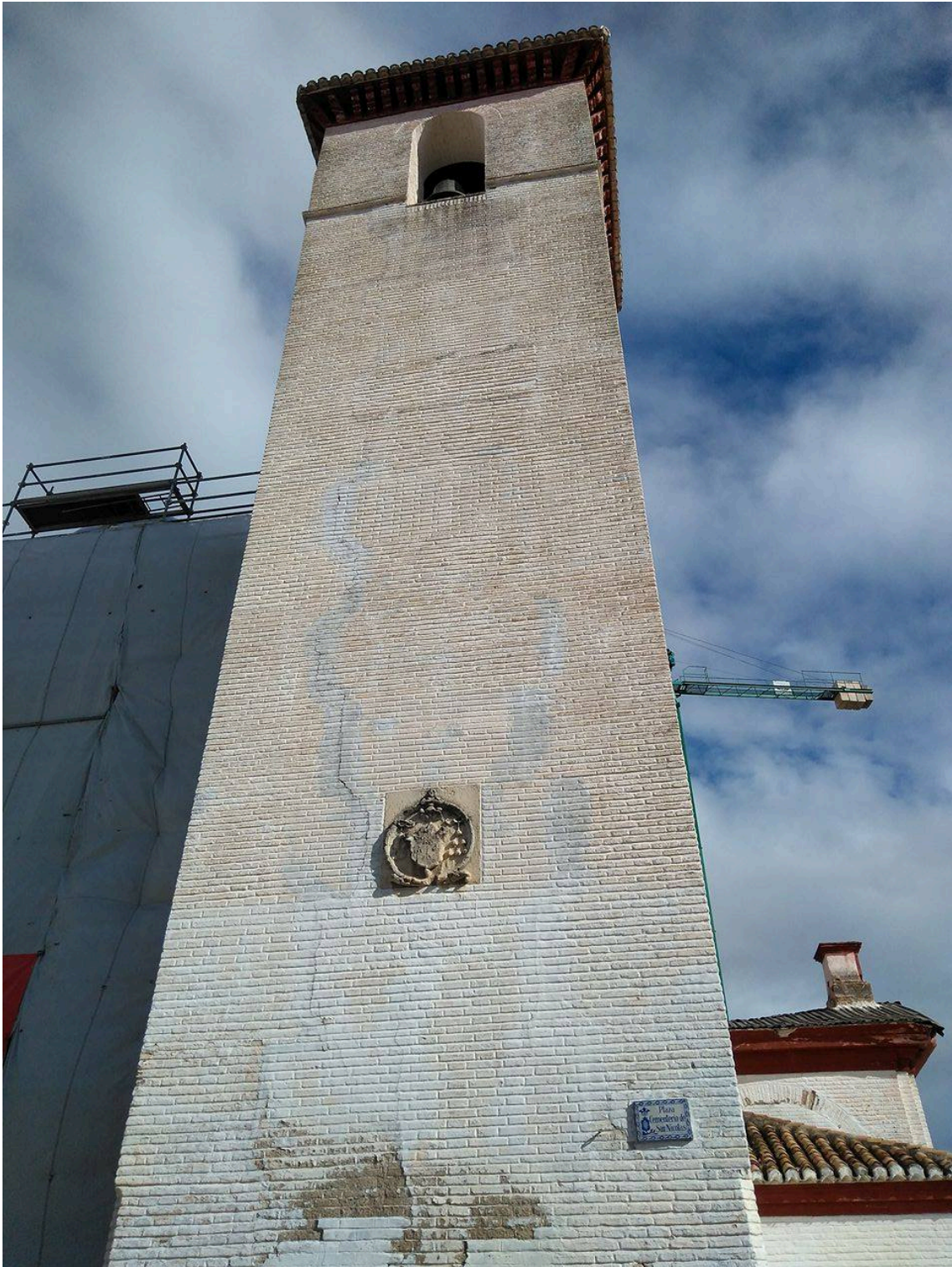
Torre de San Nicolás en 2017, durante las obras de restauración.
