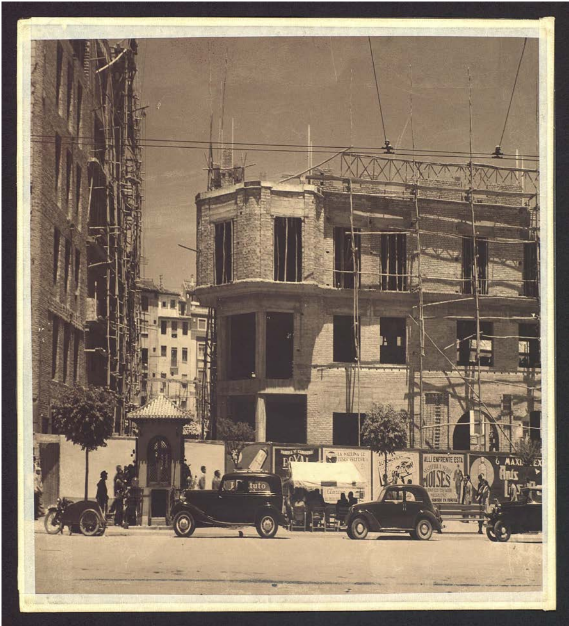
Acera del Casino, obras del teatro Isabel la Católica.
