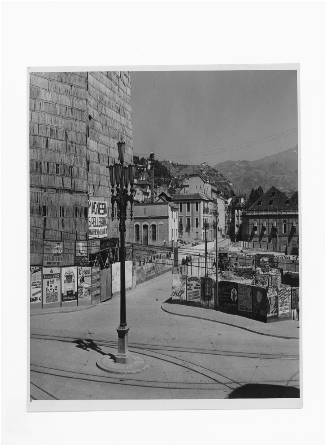
Puerta Real, con el andamiaje del Edificio Olmedo.
