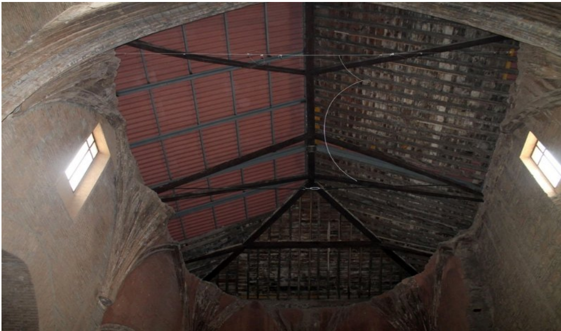
Cubierta de San Nicolás desde el interior durante la intervención de 2017.
