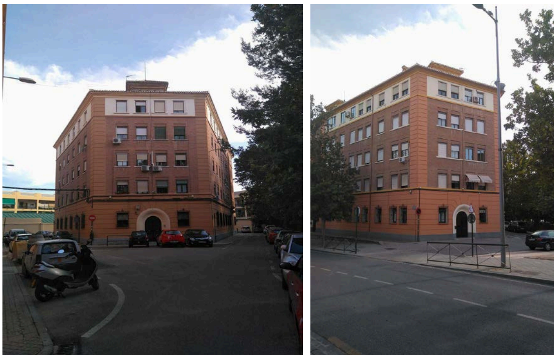
Florencio Susino González. Viviendas para personal del Ejército en Carretera de Pulianas. Vistas de los dos edificios.
