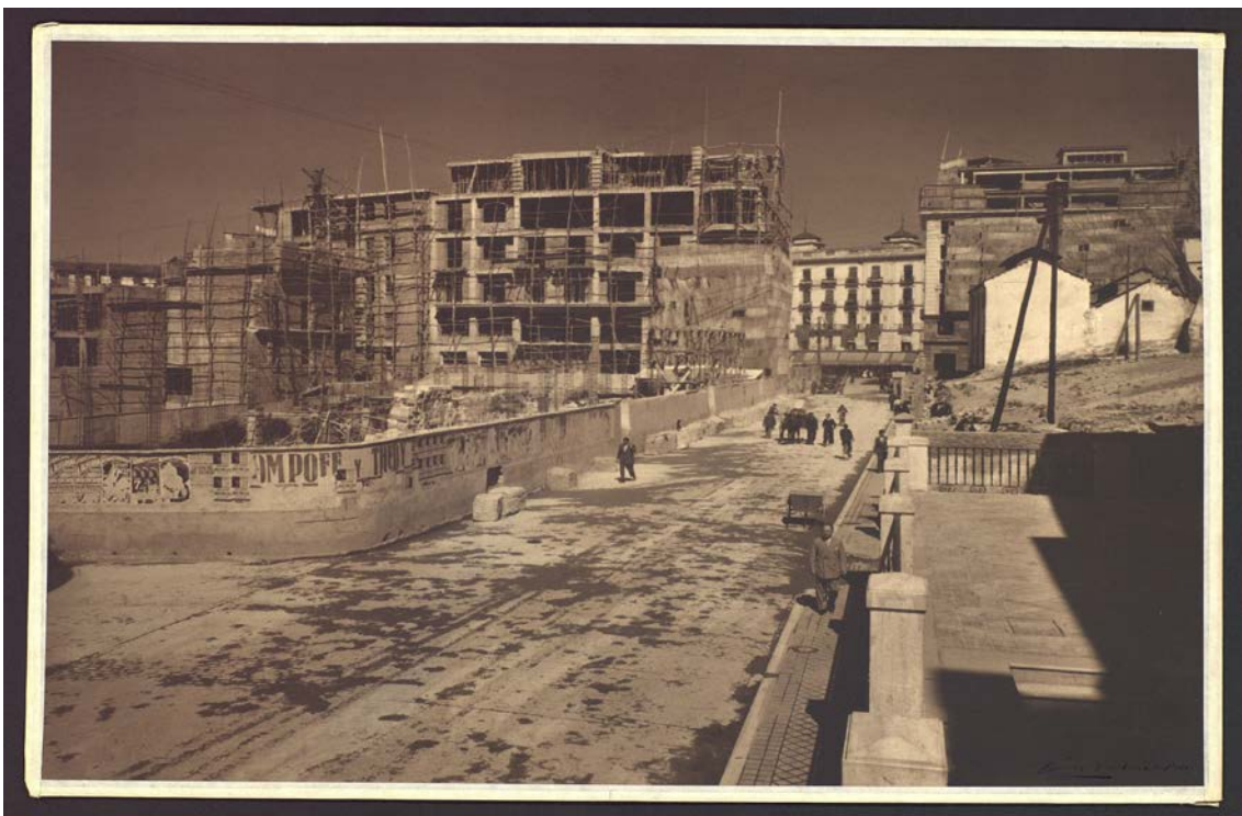
Apertura de Ganivet, al fondo el Edificio de Correos en obras, su estructura de hormigón armado.
