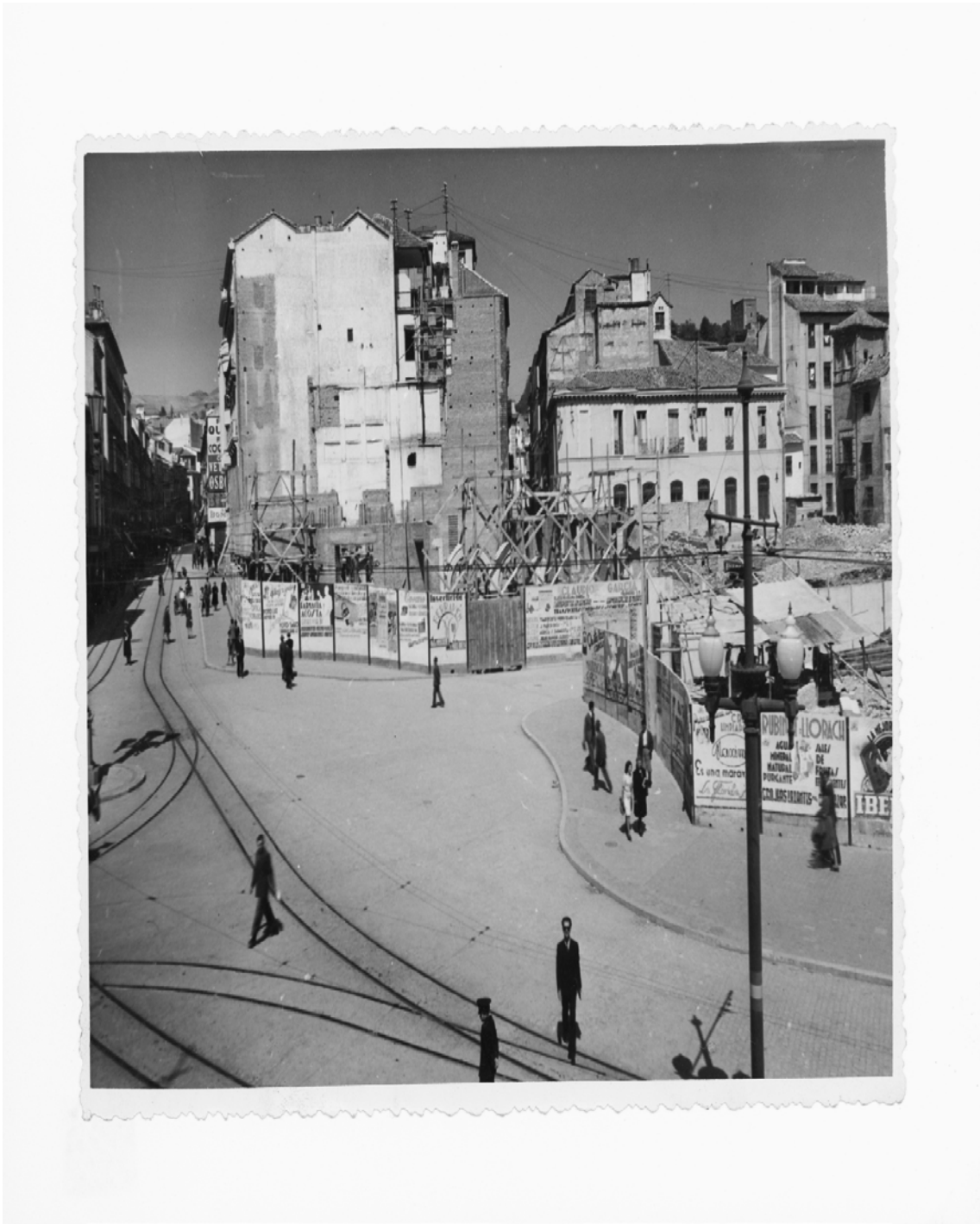
Puerta Real, inicios de la sobras del Edificio Olmedo, y el nuevo edificio de Correos.
