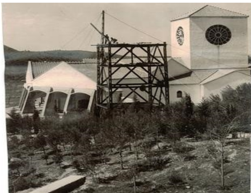
Francisco Prieto-Moreno. Detalle de la construcción de la torre. Fotografía de Ideal .
