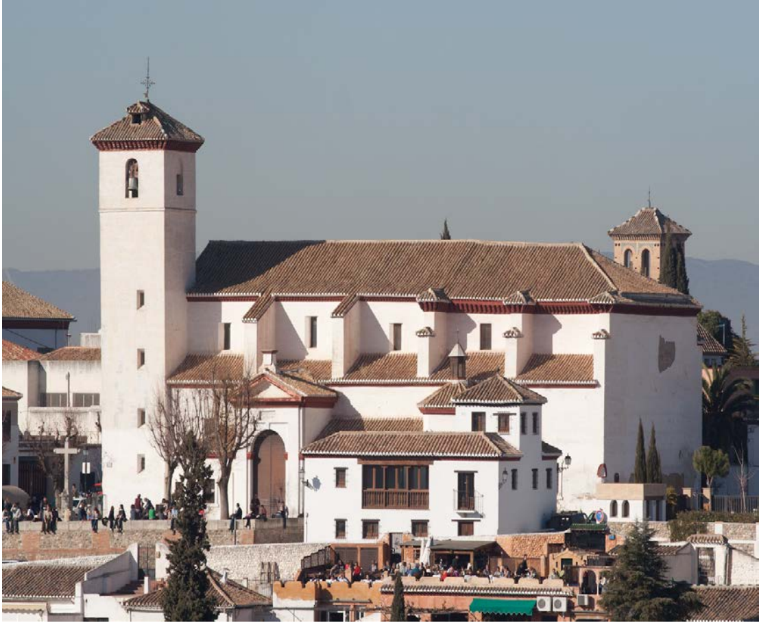
Estado general de San Nicolás antes del inicio de las obras de restauración del año 2017.
