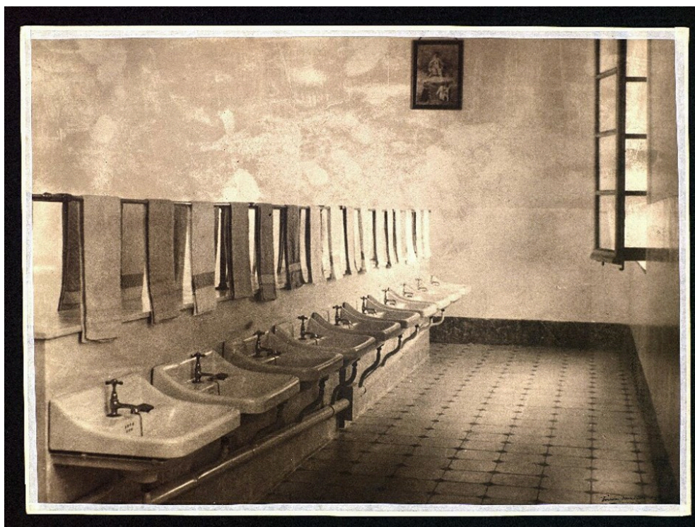
Miguel Castillo Moreno. Hogar Infantil Capitán Bermúdez de Castro. Detalle de los lavabos. AMGR, catálogo fotográfico.
