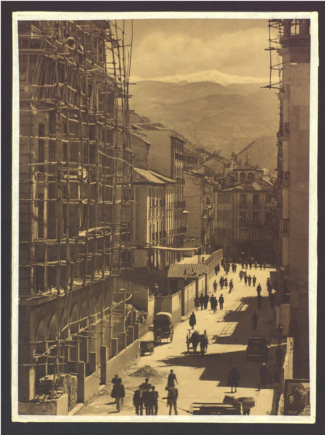
Calle Ángel Ganivet en funcionamiento, obras del Edificio Olmedo con su galería porticada, todavía con andamios.
