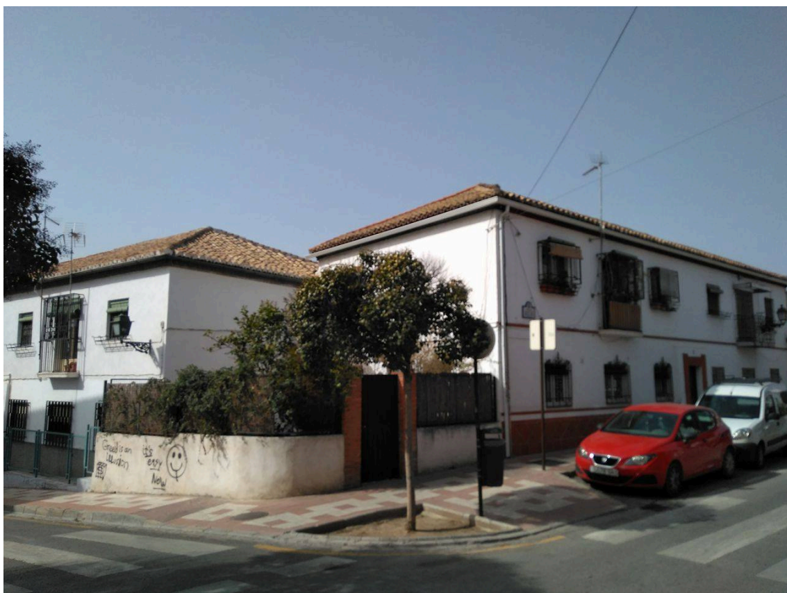
Estado actual de las viviendas en la misma calle.
