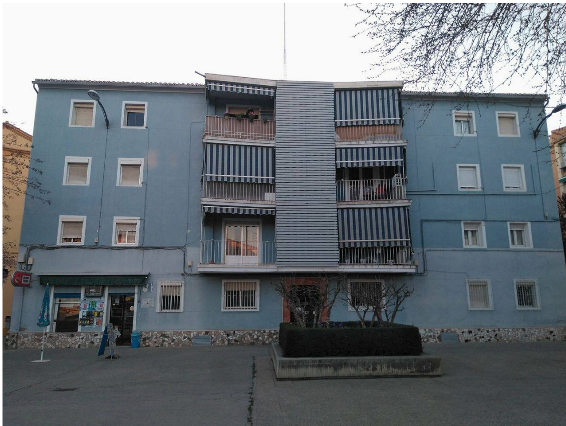
Fotografía de uno de los bloques de viviendas del grupo Comandante Valdés desde el Camino de la Zubia, del tipo C2 b.
