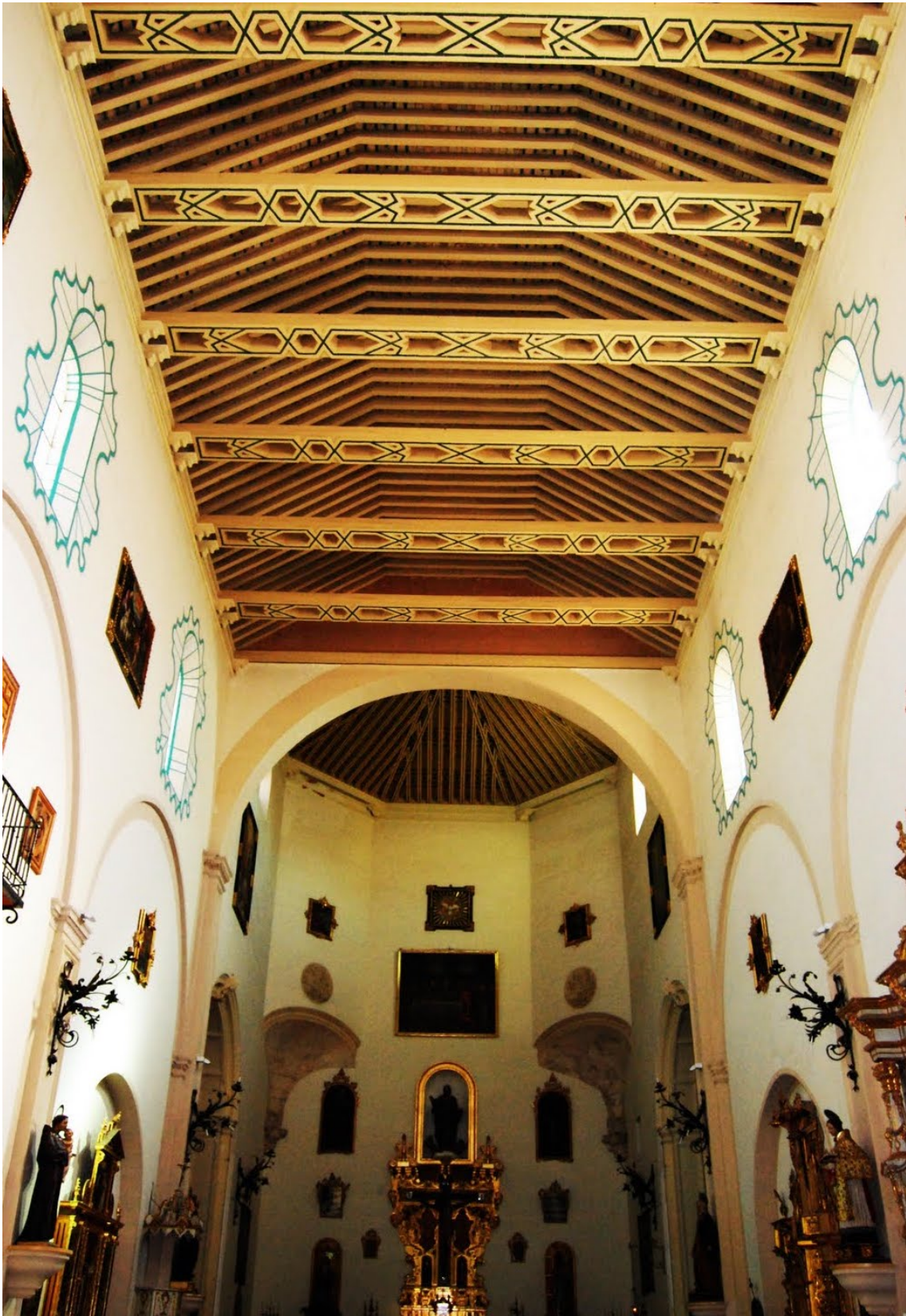
Artesonado interior del Salvador, realizado en hormigón, imita los trabajos de época Mudéjar.
