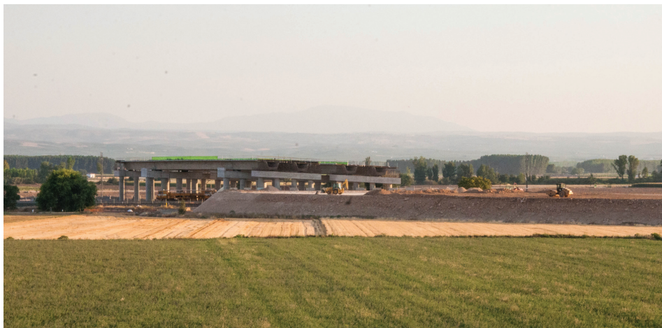
Construcción del talud de tierra para desarrollo de la autovía. Autor: Francisco Pérez Molina (2016)
