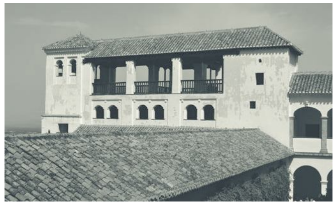
Vista actual de las plantas altas construidas en tiempos de los Reyes Católicos sobre la obra islámica y el torreón que hoy alberga la escalera de acceso a las mismas. Un segundo cuerpo de escaleras, situado al Noreste, se edificaría en 1572.
