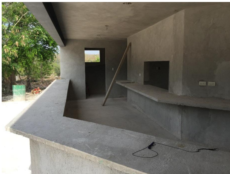
Figura 17: Aspecto interior de la cafetería escolar
