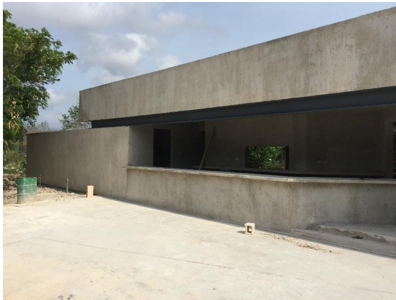
Figura 16: Construcción de la cafetería escolar
