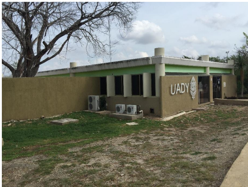
Figura 12: Fachada de la biblioteca escolar
