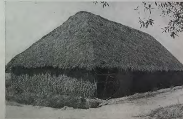
Secadero rústico de madera y paja. Peligroso, caro y de corta duración.
