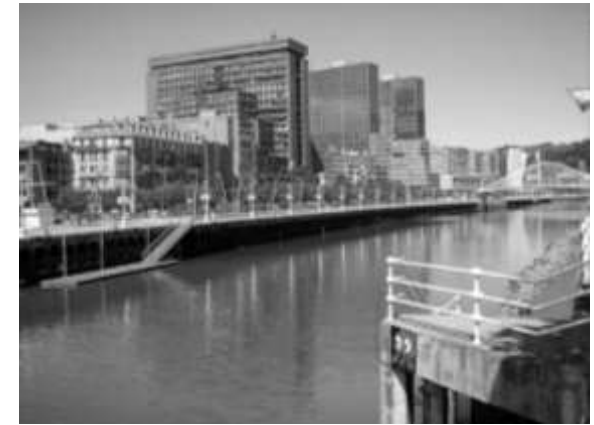
Fig. 7.47 Puente del Ayuntamiento, Bilbao.
