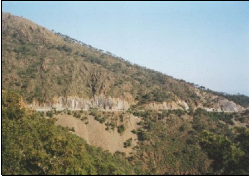
Figura 10.88. Efectos de la carretera de Ronda a San Pedro de Alcántara (A-473) a su paso por Sierra Bermeja.
