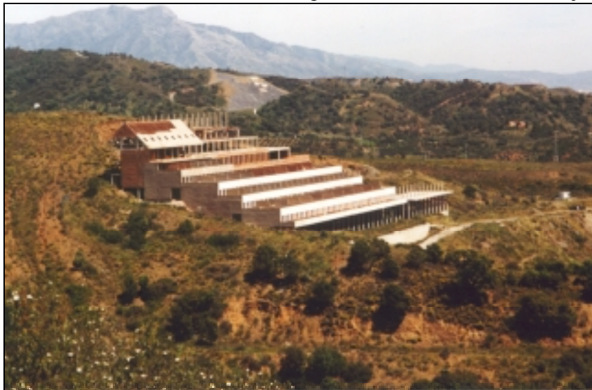
Figura 10.91. Construcción abandonada en el pie de monte de Sierra Bermeja (Estepona).
