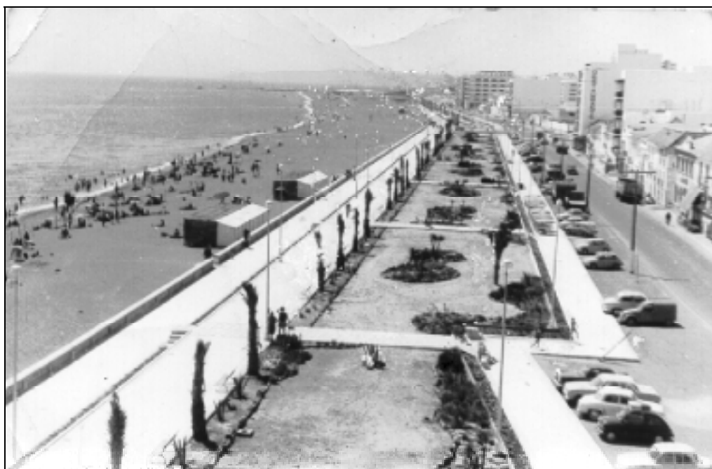
Foto B: Tras la construcción del paseo marítimo en 1965 se produjo una merma importante de la playa. Foto: Ayuntamiento de Estepona.
