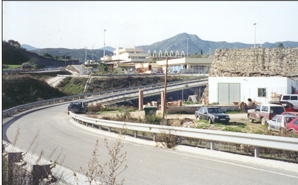
Foto B: En esta fotografía tomada recientemente se muestra la transformación del paisaje agrícola y de las infraestructuras vinculadas al mismo. Las infraestructuras obsoletas han sido sustituidas por otras nuevas que se superponen a las antiguas y se instalan sobre el agro. En la foto podemos observar las instalaciones de peaje de la nueva Autopista del Sol y como el nudo de la misma aprovecha la apertura del pantano. Foto: autor.
