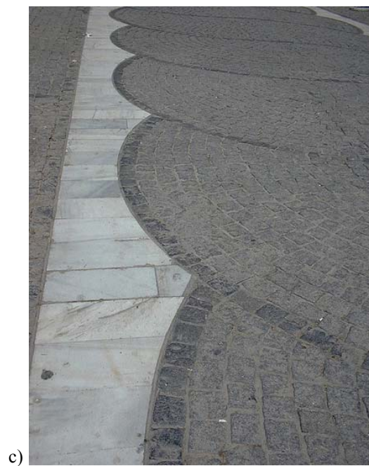
6.24. Implicaciones funcionales del tratamiento textural de un pavimento.
