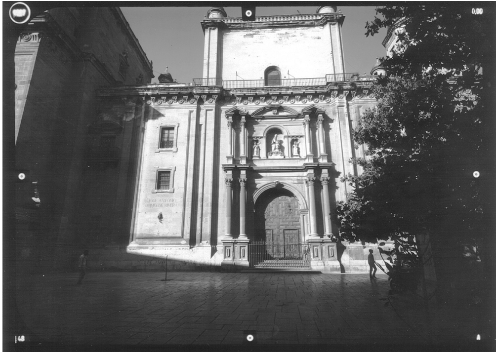
7.27. Fotografía métrica de una de las fachadas del Conjunto.
