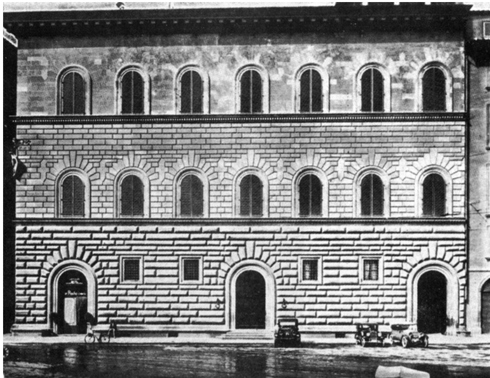
3.3. Palacio Gondi, Florencia. Ciertos tipos de almohadillado enfatizan la individualidad de los sillares.
