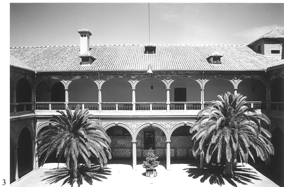
6.12. La evolución de las sombras y su implicación en las posibilidades plásticas de una fachada.
