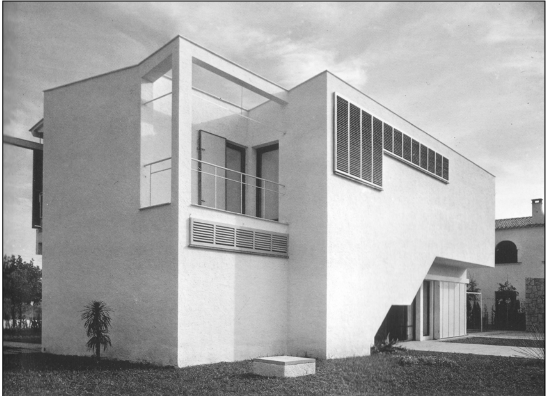
2.7. Ley de la Pregnancia . La rotundidad formal de los volúmenes generales del edificio les hace prevalecer sobre el resto de los volúmenes -reales o implícitos- del mismo.
