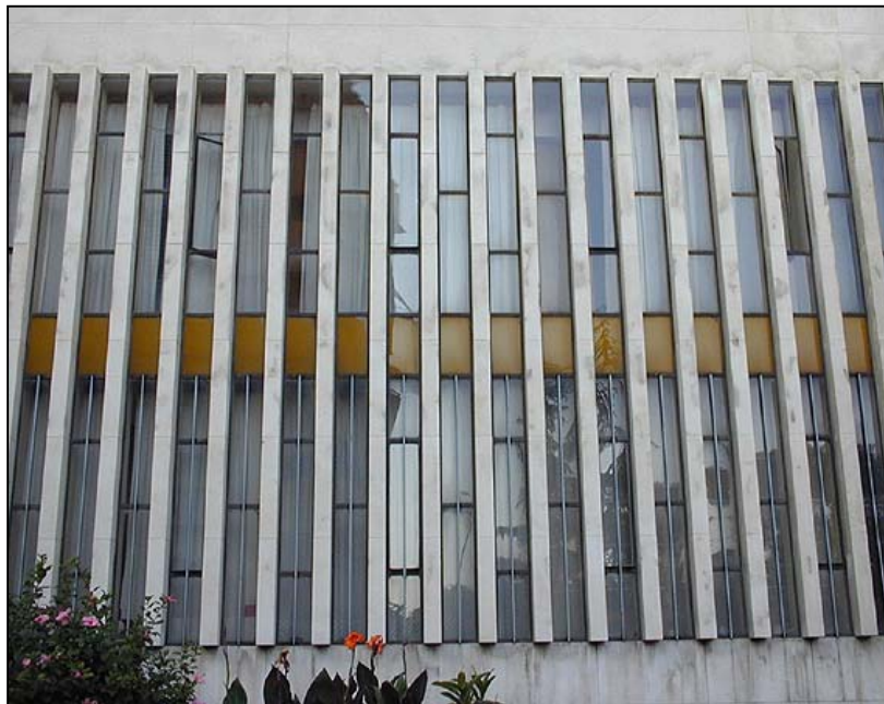
6.91. Fachada con escasos paradigmas de escala que permitan determinar las verdaderas dimensiones de sus elementos.
