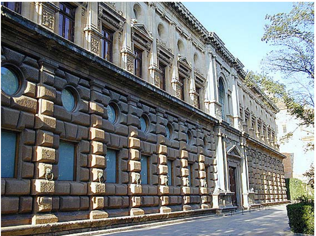
6.22. Implicaciones estéticas del tratamiento textural de una fachada.
