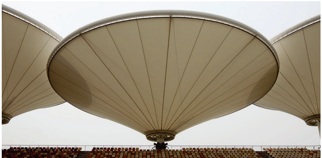
Figura 1.19: Estructuras tensadas con forma simple: Conoide asimétrico invertido. Circuito internacional de F1 de Shanghai.
