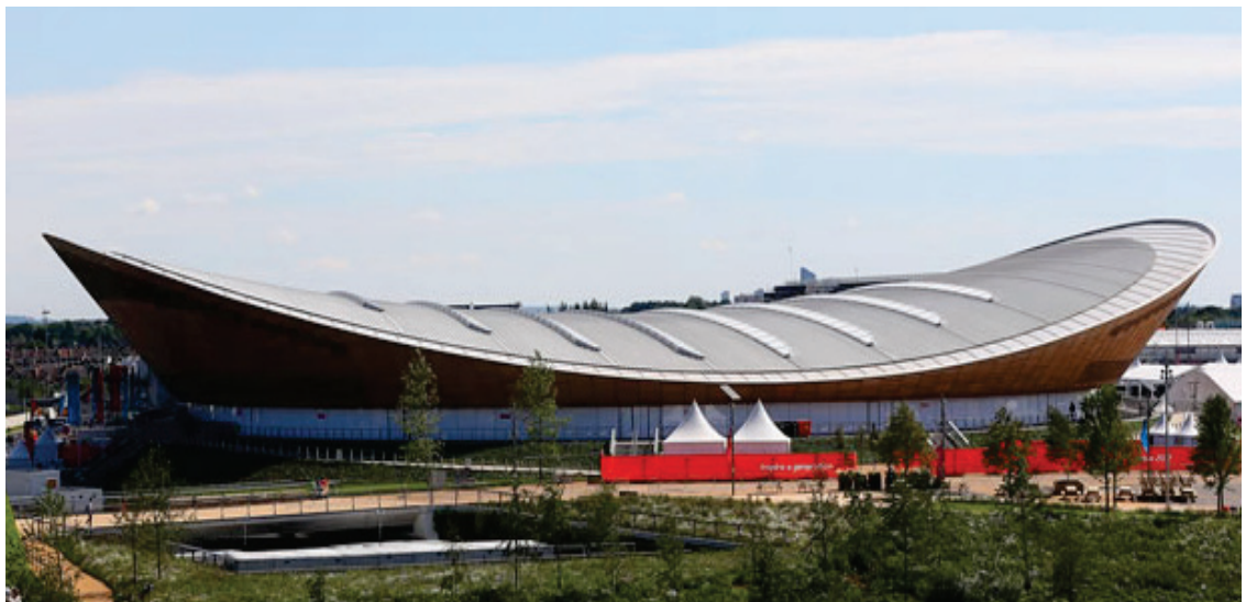
Figura 1.32: Velódromo de Londres para las olimpiadas de 2012. Hopkins architects. Londres (Reino Unido) Malla de cables cerrada (elíptica) con doble curvatura que sustenta los paneles.
