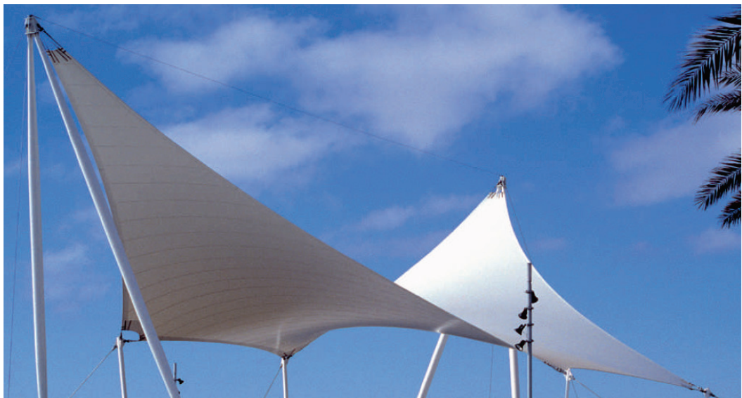
Figura 1.15: Cubierta del Intercambiador Modal de Las Palmas (España).
