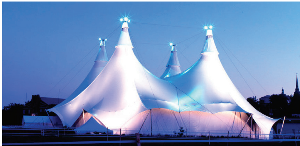
Figura 1.25: Disposición en cerramiento y cubierta. Gran Carpa Blanca de Cavalía.
