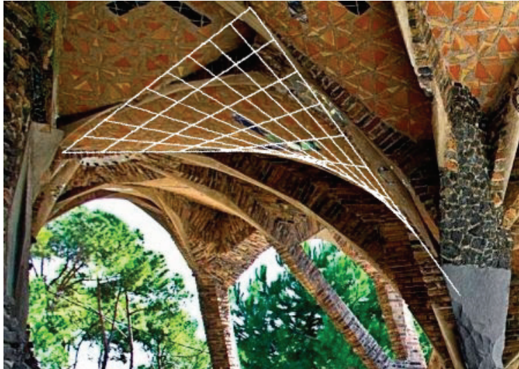
Figura 1.49: Forma de paraboloides hiperbólicos de la Cripta de la Colonia Güell. Gaudí. Barcelona (España)
