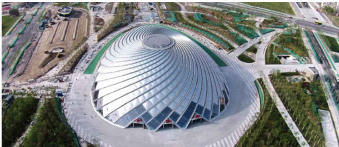
Figura 1.30: Estación de tren de Yujiaju (China), formada por elementos hinchados de ETFE.
