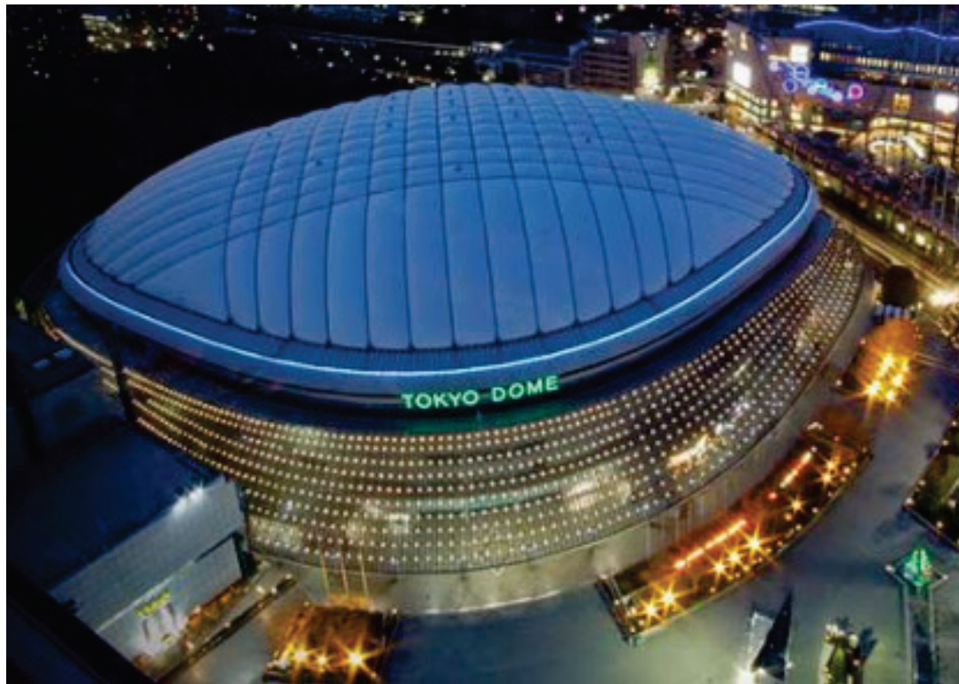
Figura 1.29: Estructura soportada por aire: Cubierta del Tokio Dome. Bunkyô - Tokio (Japón)
