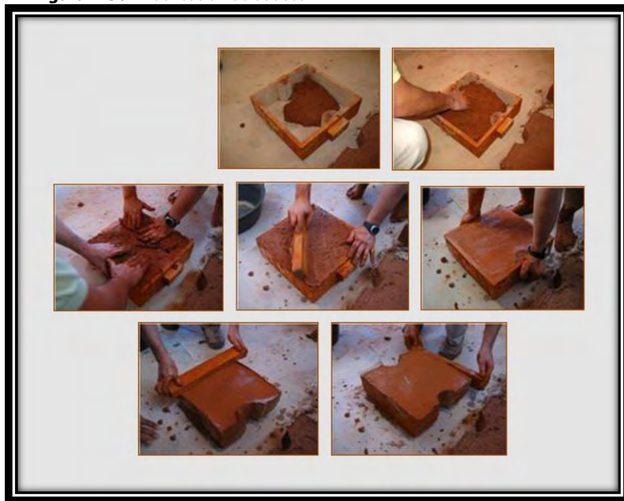
Figura 2.30 - Fabricación de adobes
