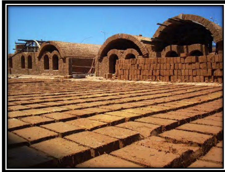
Figura 2.25 - Fabrica de adobes en Sheikh Zayed – Gaza
