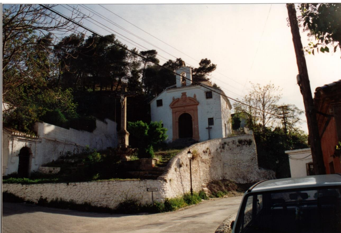
Ilustración 59 Ermita del Santo Sepulcro a la entrada de las cuevas que conducen a la abadía. Se construye como fin del Vía Crucis que se iniciaba en la iglesia de Santa Ana y conducía hacia las santas cuevas.
