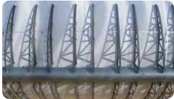
Diversos tipos de estructuras de canales parabólicos.
