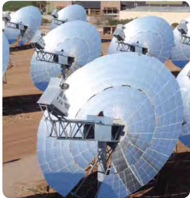
Centrales de disco parabólico funcionando.
