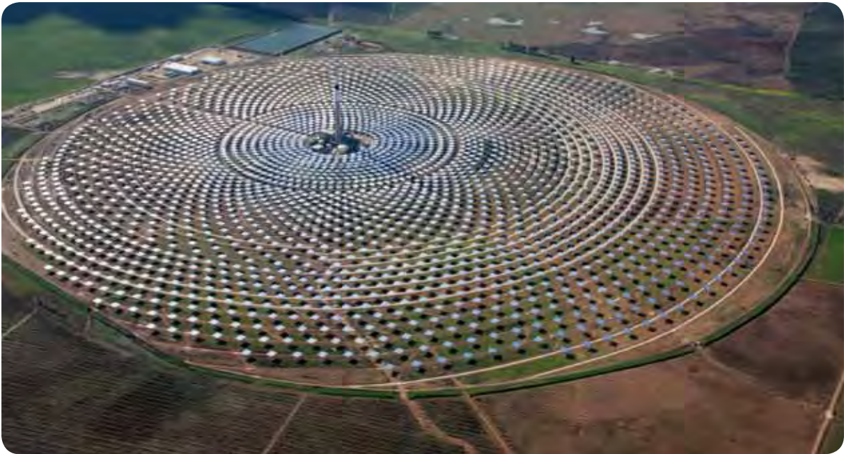
Planta Gema Solar en Fuentes de Andalucía (Sevilla).
