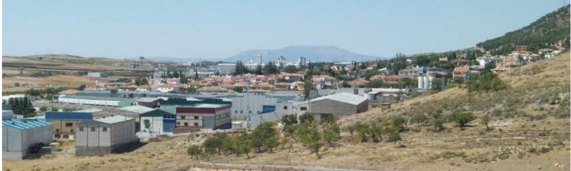
Fig. 109. Polígono industrial La Paloma, junto a urbanización El Puntal (Padul)
