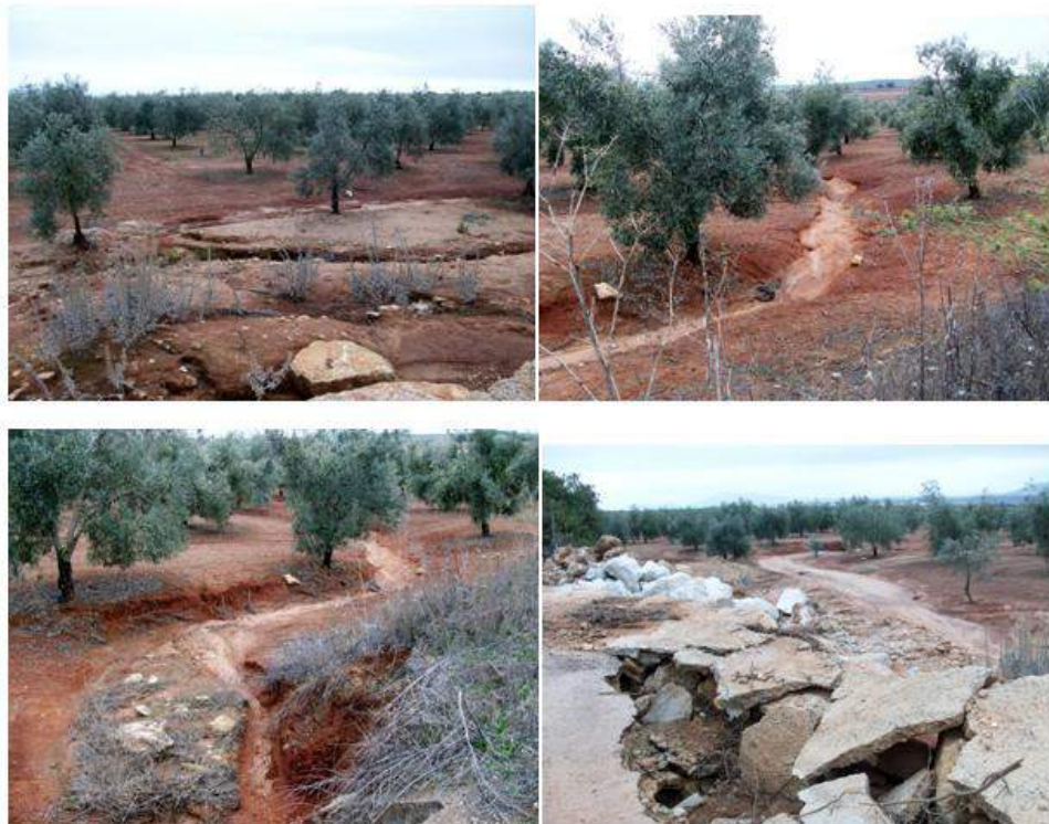
Fig. 259. Daños ocasionados por el arroyo Vaguada de Campos a su paso por la Carretera de La Herriza (noviembre de 2014)
