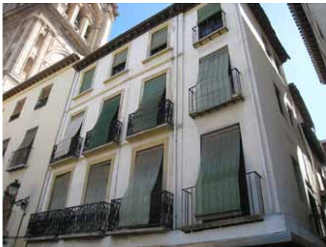
11. Calle Capuchinas, nº 22. Granada. Fachadas. (SGA)
