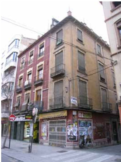
7. San Juan de Dios, nº 35 y 37. Granada. Fachadas. (SGA)
