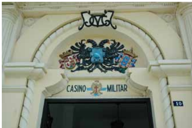
115. Casino Militar. Melilla. Fachada. Detalle. (SGA)
