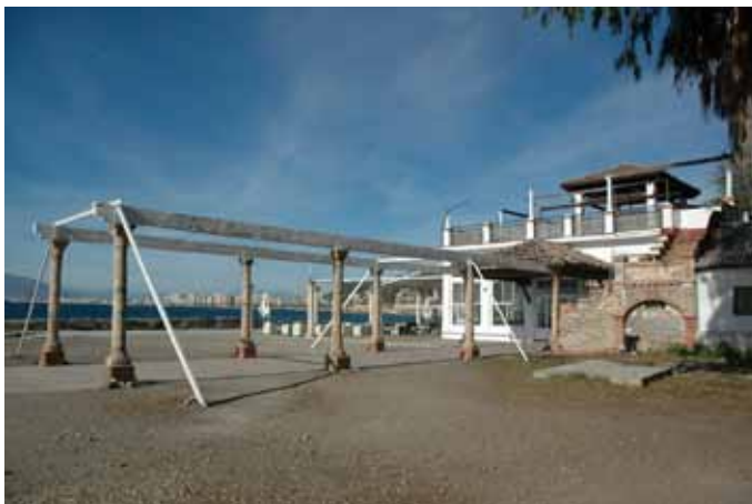
88. Baños del Carmen. Málaga. Pérgola. (SGA)
