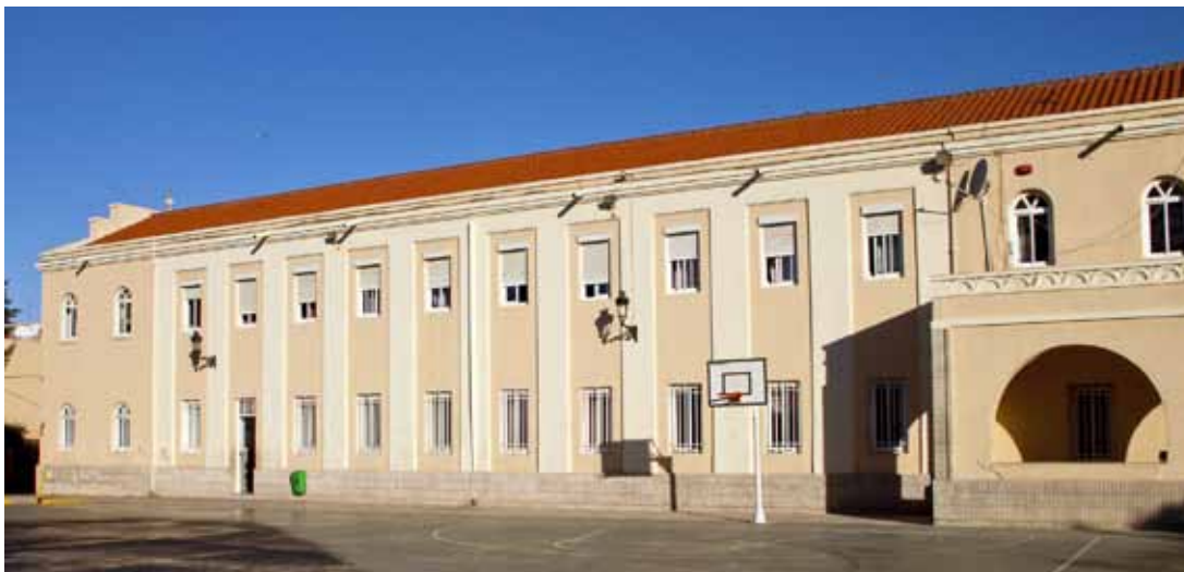
144. Antigua Casa Cuna (AGC). Melilla. Fachada. (MFB)
