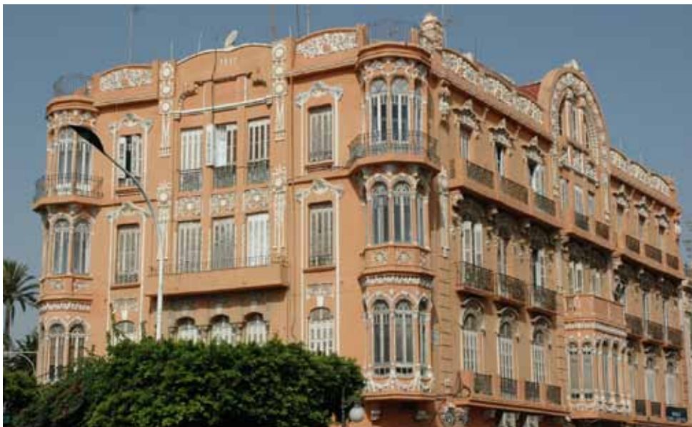
121. Avenida, nº 1 (“Casa de David J. Melul”). Melilla. Fachadas. (SGA)
