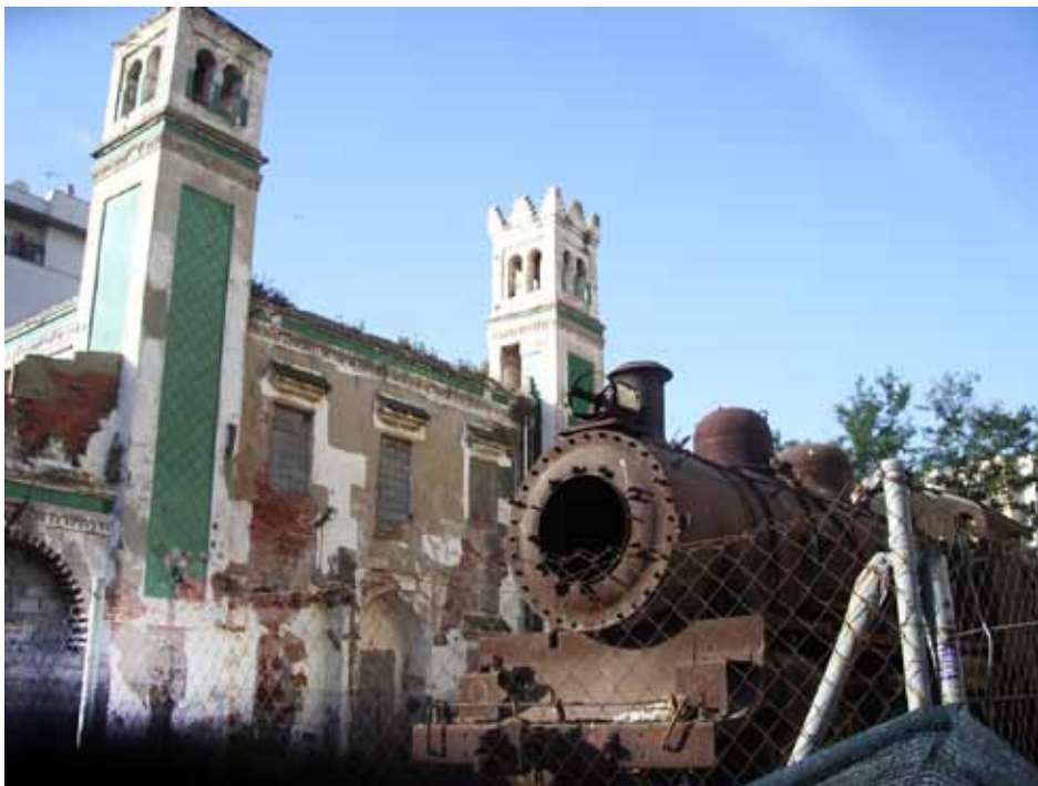
66. Estación de ferrocarril. Tetuán. Fachada. Geolocation.ws
