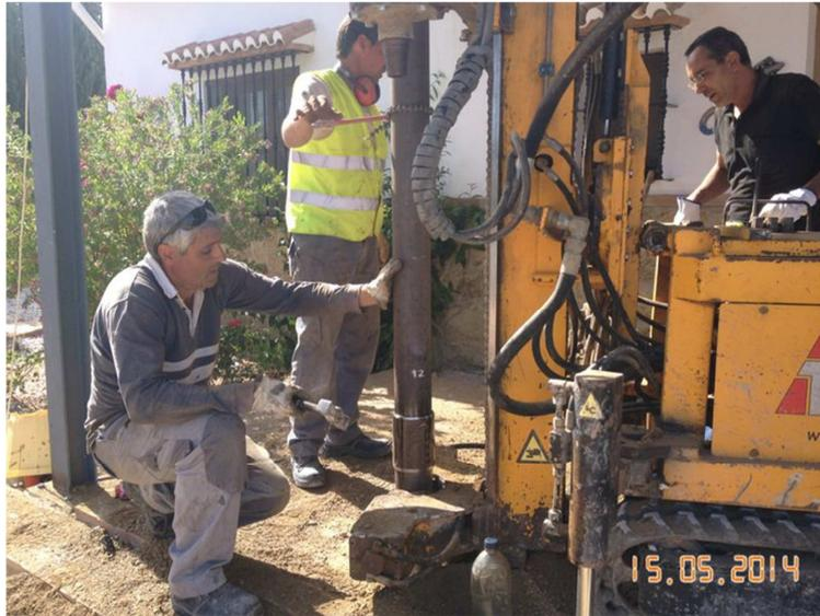
*Ilustración 6.2 Imagen de una obra de estabilización de edificación, mediante micropilotaje. Fuente: fotos del autor.*
