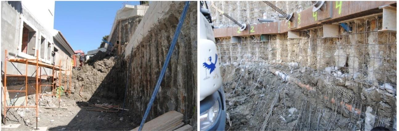
**Ilustración 6.10** Medidas de estabilización de deslizamiento en parte posterior de una edificación mediante pantalla de micropilotes e instalación de drenes californianos, Fuente: fotos de autor.
