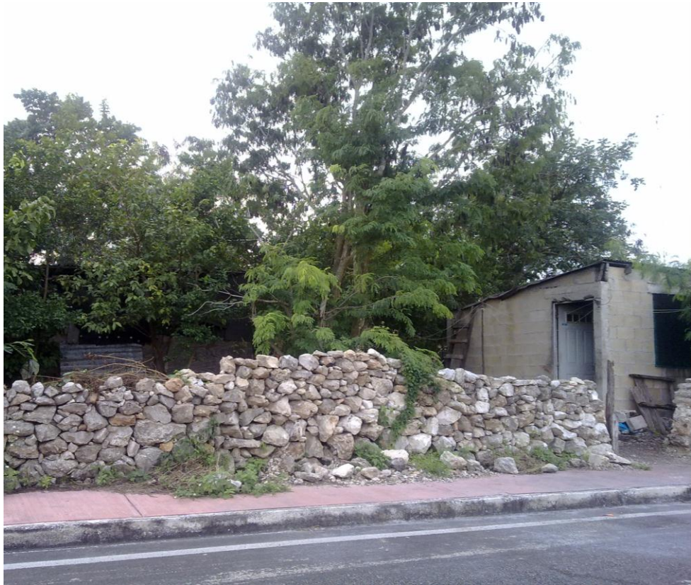
Figura 12. Características de algunas viviendas ubicadas en calles vecinas al Centro Nicodemo.
