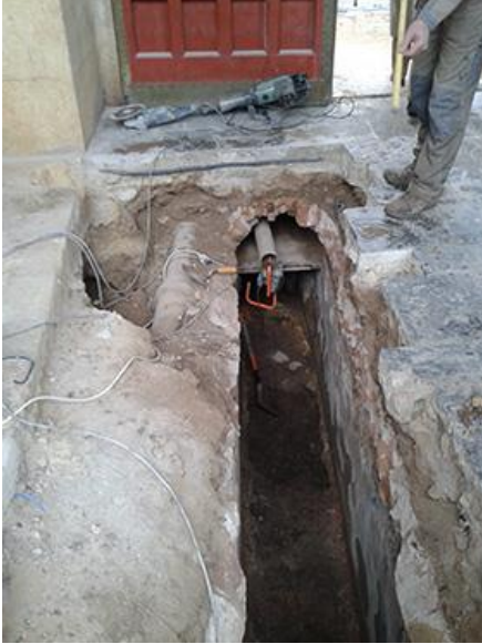
Ilustración 08. Vista de la excavación arqueológica en la Puerta de los Deanes. Rodríguez Cano construyó una cámara en la parte superior de la atarjea de Velázquez Bosco con el fin de alojar la tubería de la instalación contraincendios y no realizar una nueva afección a la cimentación de la Puerta. Elaboración propia.
