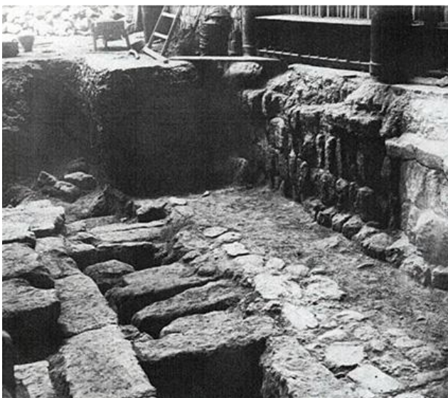
Ilustración 06. Cimentación del muro de cerramiento oriental de la mezquita de Abd al-Rahman I, 1932. Museo Arqueológico de Córdoba, Archivo Félix Hernández, PO-47.
