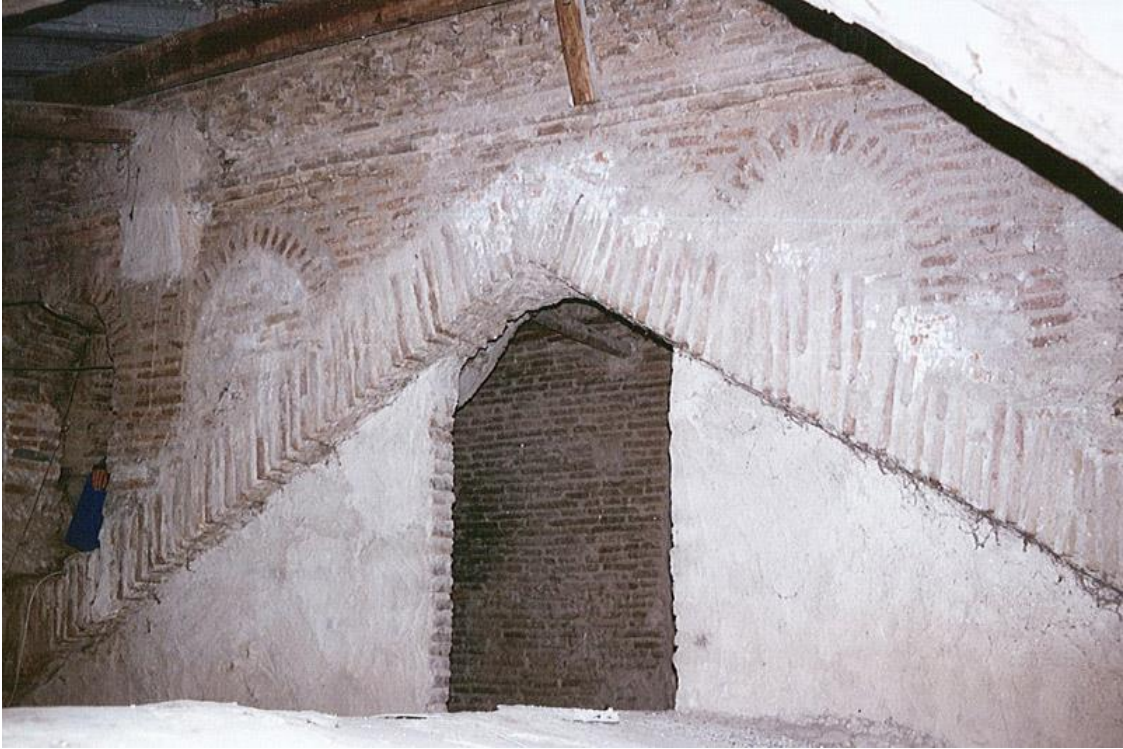
Link 31. La galería mudéjar, antes de la restauración. Fuente: Elaboración propia.
