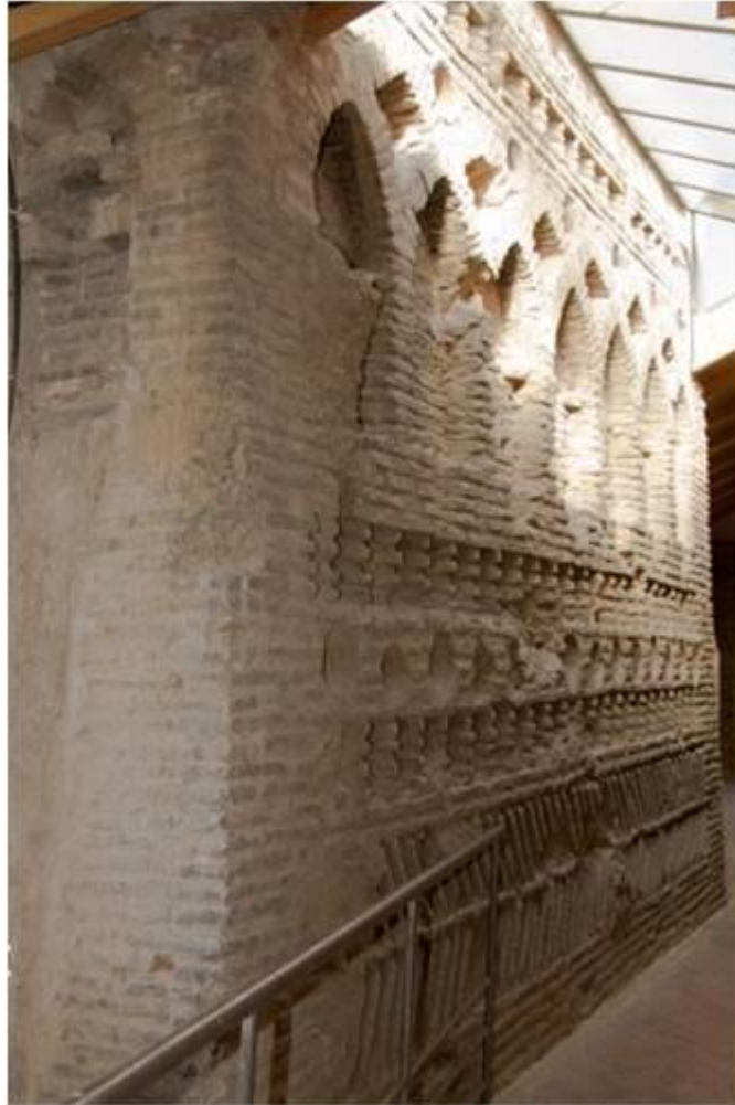
Ilustración 08. La zona oculta de la torre antes de la restauración y tras la apertura del lucernario. Fuente: Elaboración propia.
