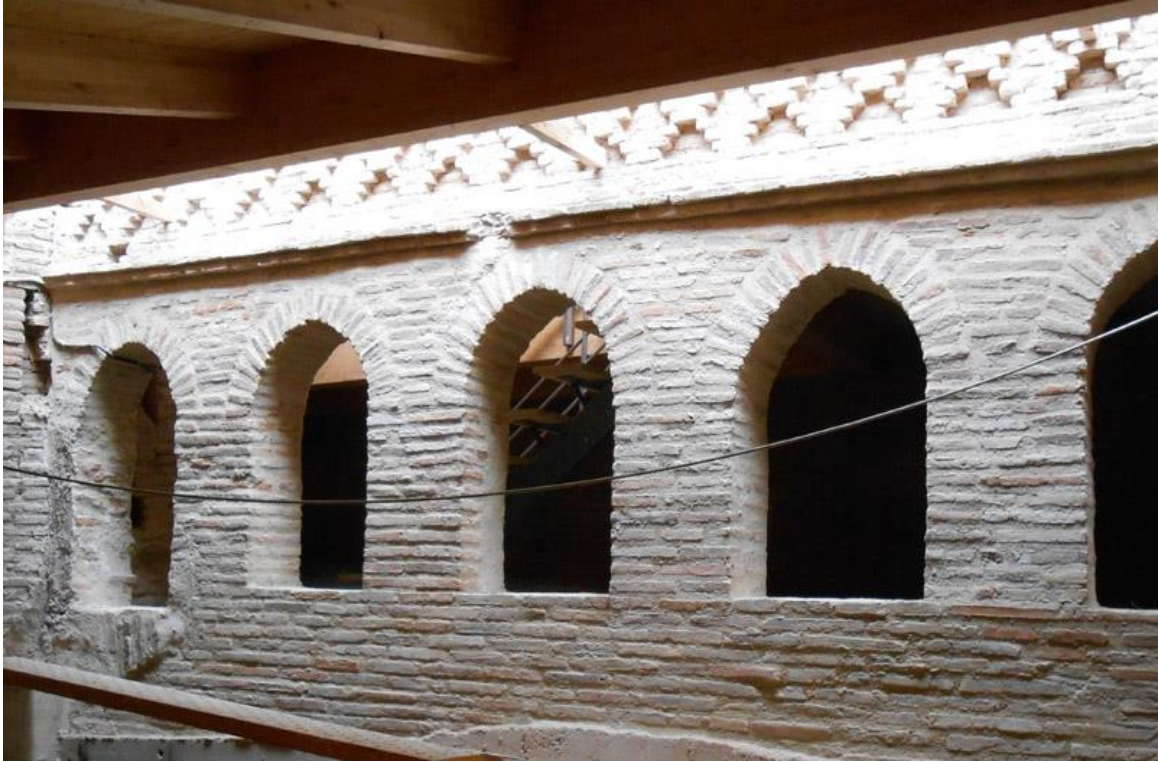
Link 33. La galería mudéjar, después de la restauración. El lucernario ha permitido recuperar la continuidad entre las dos galerías superpuestas. Fuente: Elaboración propia.
