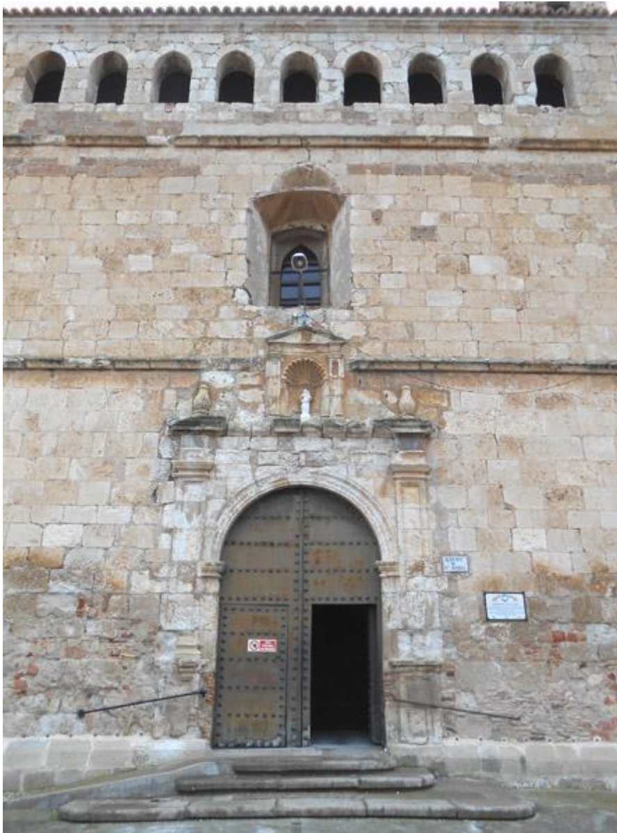
Link 46. Fachada actual, con portada neoclásica abierta en la ampliación del s. XVI. Fuente: Elaboración propia.
