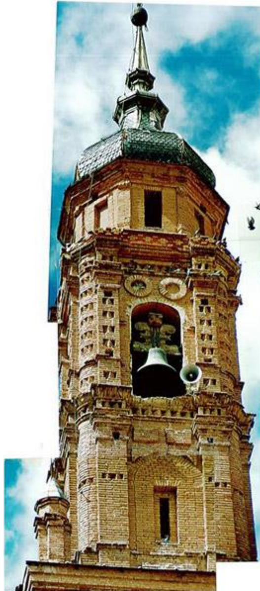
Link 13. Campanario barroco, antes de la intervención de Rafael Mélida. Fuente: Elaboración propia.
