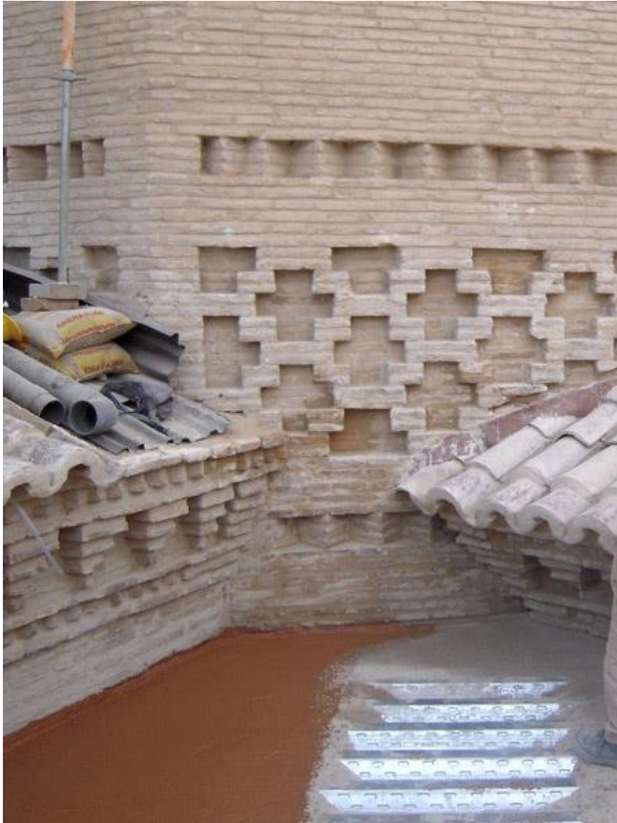
Link 29. Transformación de una pequeña cubierta en azotea para dejar a la vista un fragmento de la decoración del ábside. Fuente: Elaboración propia.
