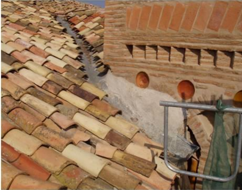
Link 26. Desvío del agua del faldón central de cubierta hacia los laterales de la torre. Fuente: Elaboración propia.
