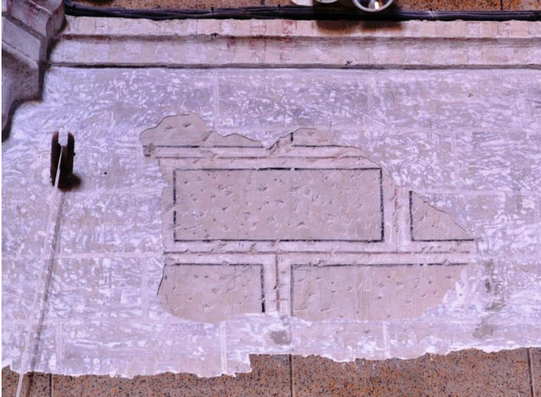
Link 37. Revestimiento mudéjar con despiece isódomo esgrafiado y policromado. Fuente: Elaboración propia.
