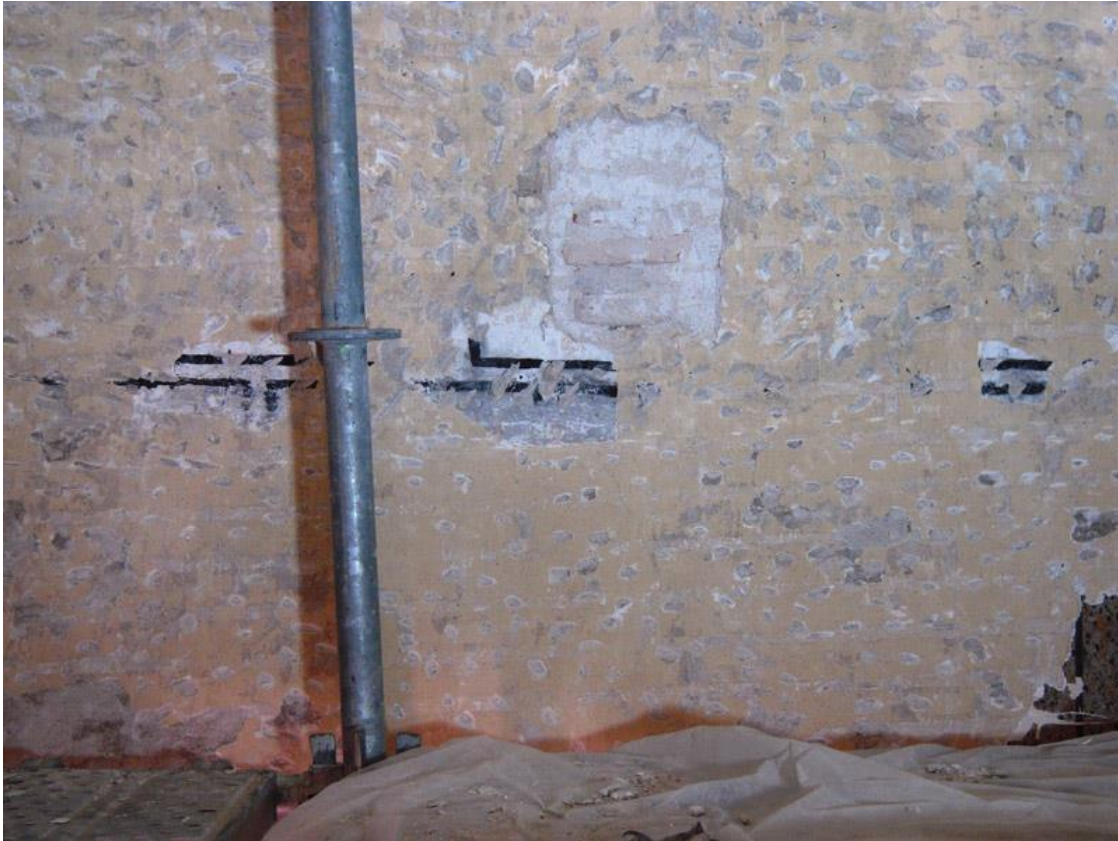
Link 40. Restos de un arrepentimiento en la decoración del revoco, oculto en el solape de la primera andamiada. Fuente: Elaboración propia.
