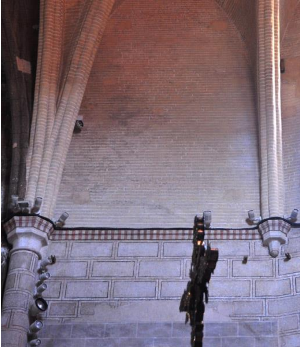
Link 43. Decoración del revestimiento interior mudéjar, imitando los materiales constructivos de la arquitectura. Fuente: Elaboración propia.
