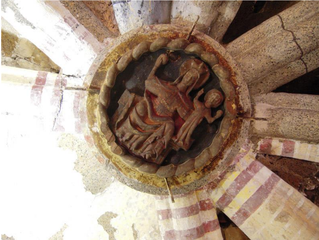
Link 39. Clave de la bóveda del presbiterio, tal como apareció tras retirar la clave de madera dorada sobrepuesta. Fuente: Elaboración propia.
