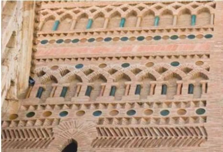
Link 22. Fachada Oeste del cuerpo medieval de la torre. Fuente: Elaboración propia.
