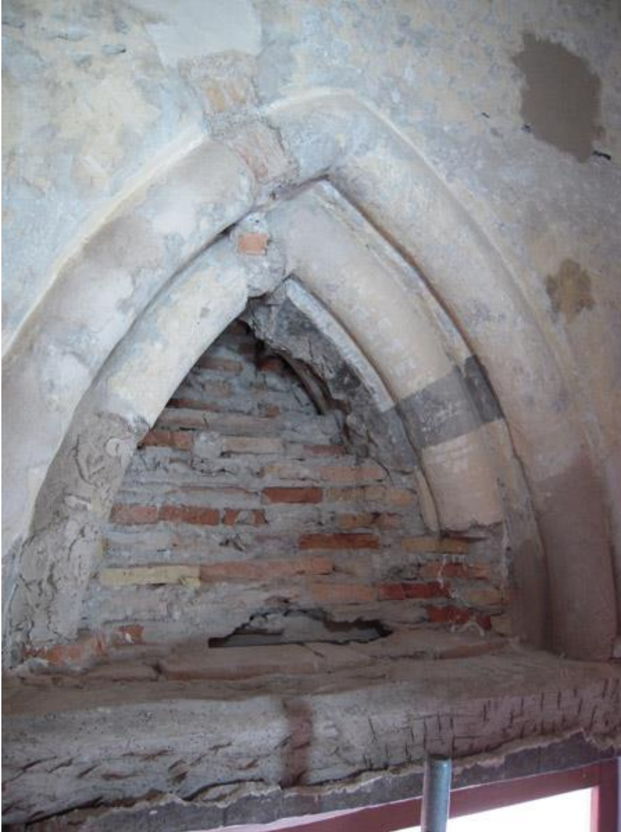
Link 41. Arquivoltas del ventanal lateral del ábside ocultas tras el macizado que se hizo sobre el dintel del ventanal barroco. Fuente: Elaboración propia.
