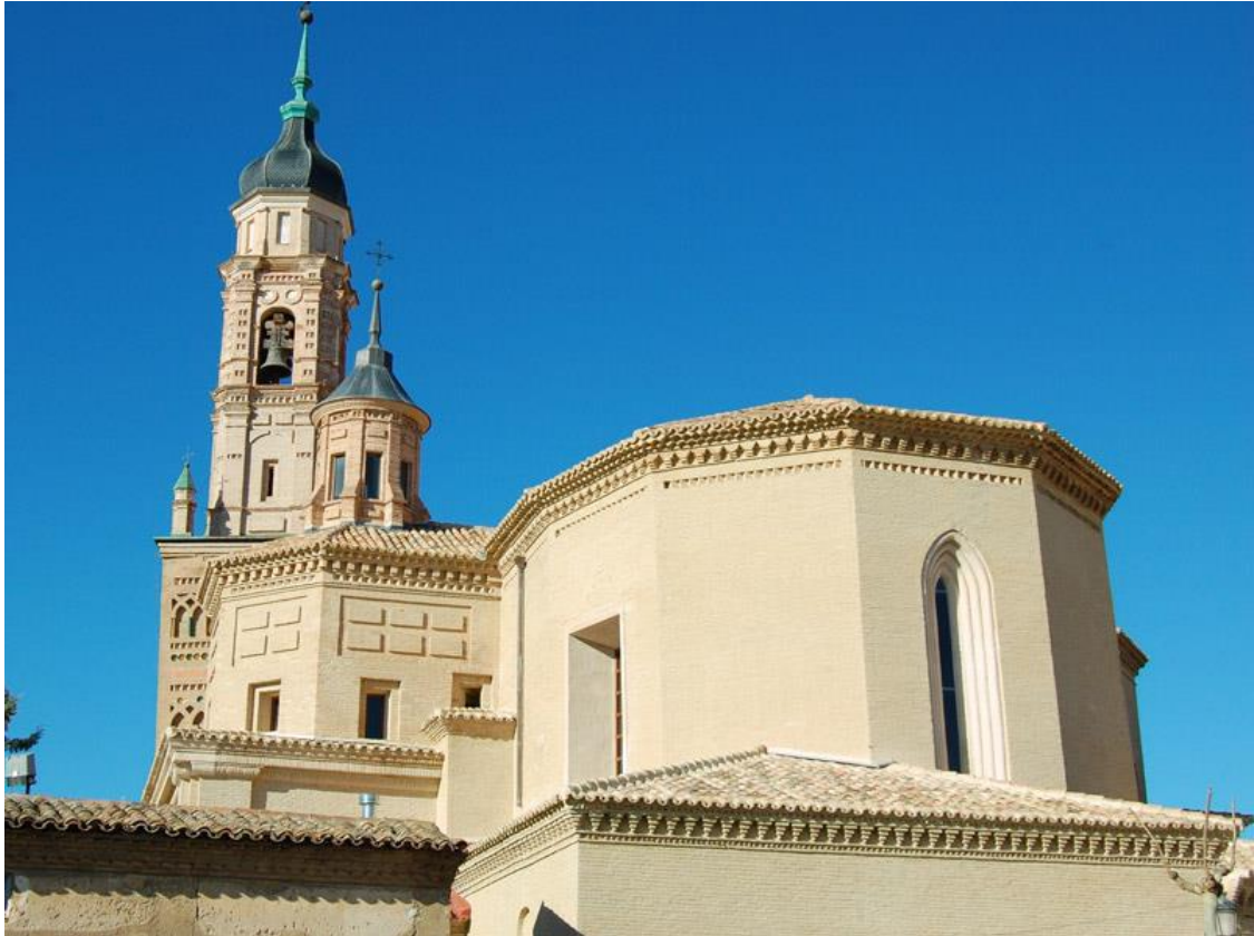
Link 36. Restauración de lienzos de ladrillo, con los ventanales barrocos y el mudéjar. Fuente: Elaboración propia.
