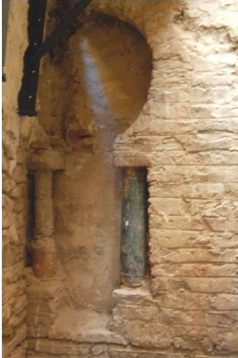
Ilustración 06. Revestimiento de yeso agramilado con despiece de ladrillo. Fuente: Elaboración propia.
