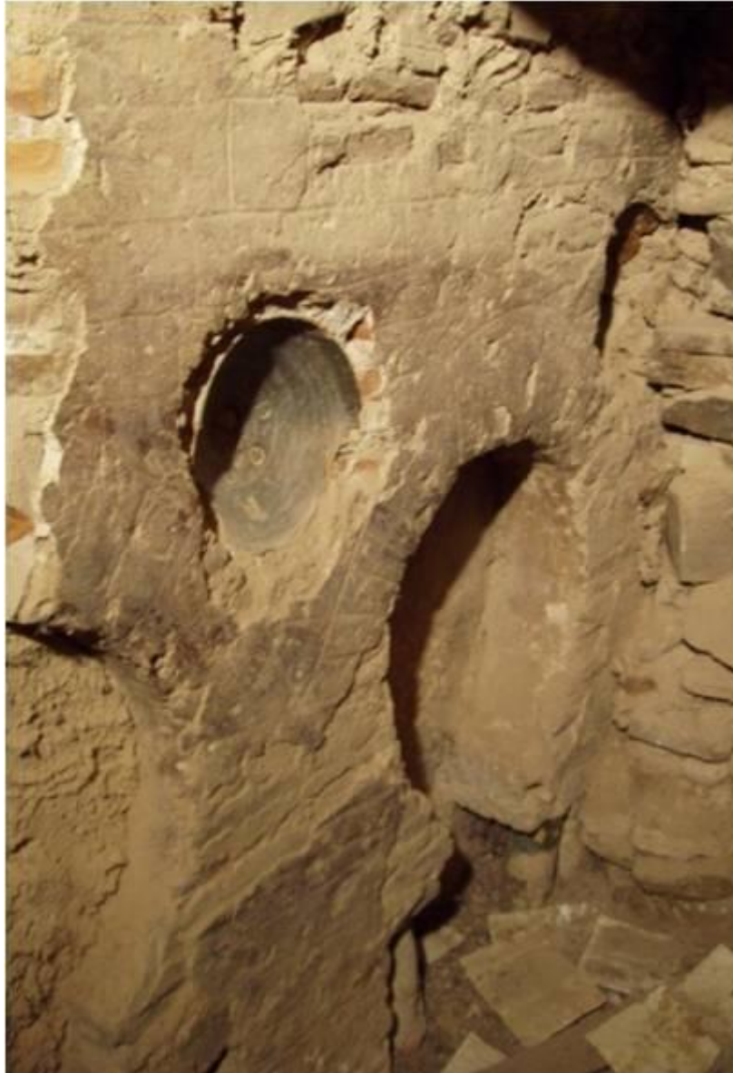
Link 20. Revestimiento de yeso agramilado con despiece de sillarejo y dovelado de ladrillo. Fuente: Elaboración propia.
