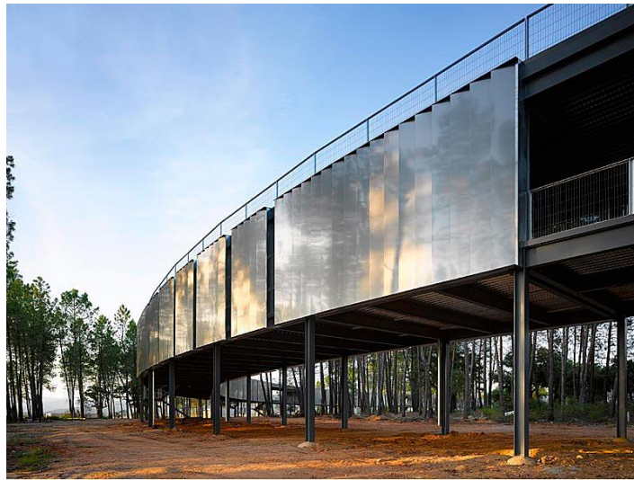
Link 19. Exterior del “Anillo”. Foto Roland Halbe.
