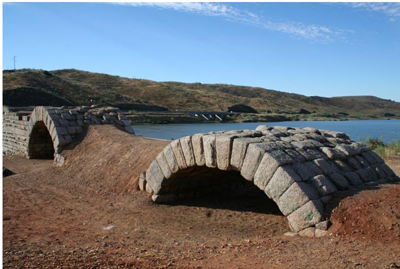
Link 09. Puente romano de Alconétar.
