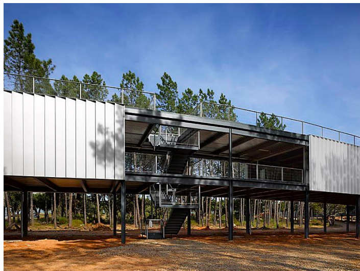
Link 14. Uno de los accesos al “Anillo”. Foto Roland Halbe.
