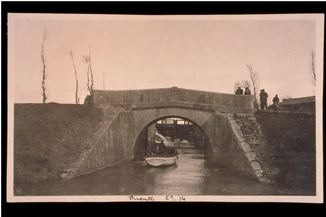
Ilustración 02. Puente de la esclusa 14 en San Llorente de la Vega (Burgos), 1920. Fte.: AGCHD, CC, CDF, RN-089.
