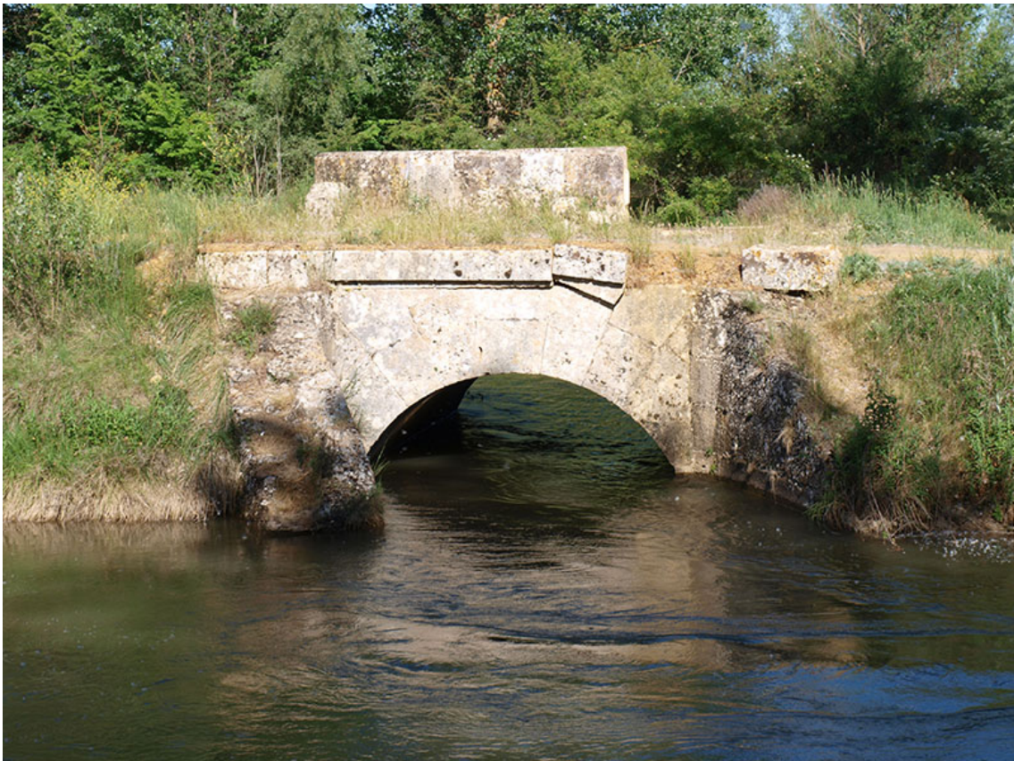
Link 11. Puente de derivación en la esclusa 14. Fte.: El autor.
