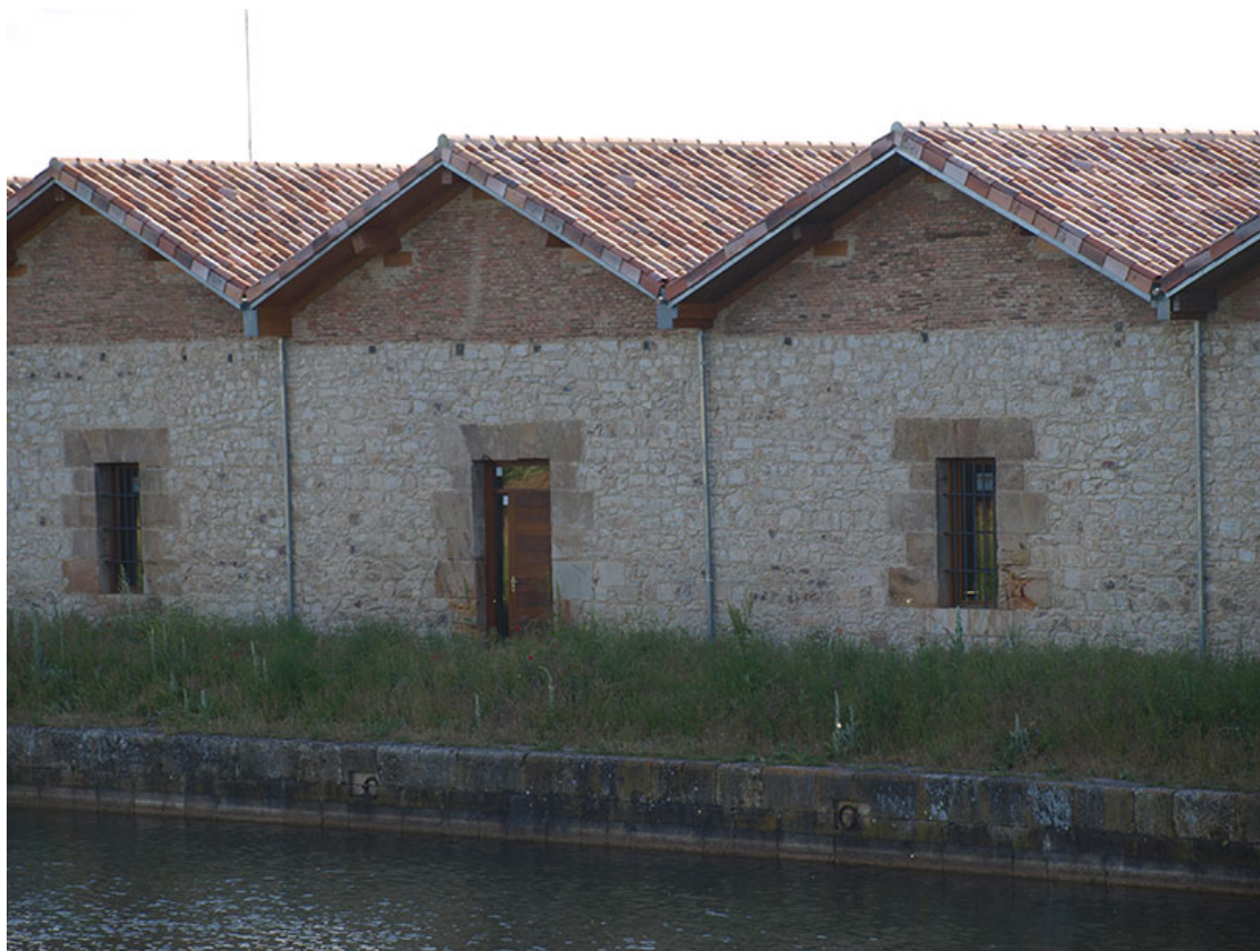
Link 28. Almacén Grande de Alar del Rey. Fte.: El autor.
