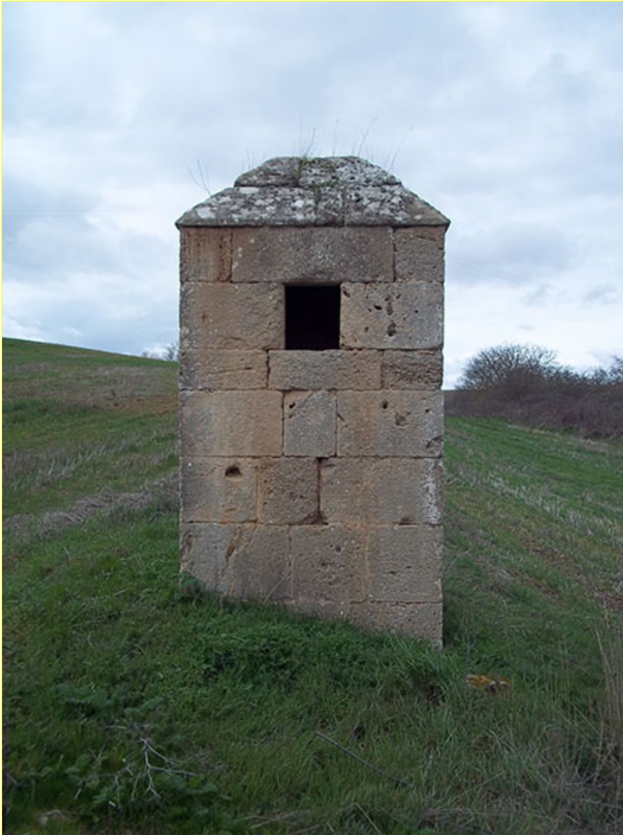
Link 23. Almenara de riego en Olmos de Pisuerga (Palencia). Fte.: El autor.
