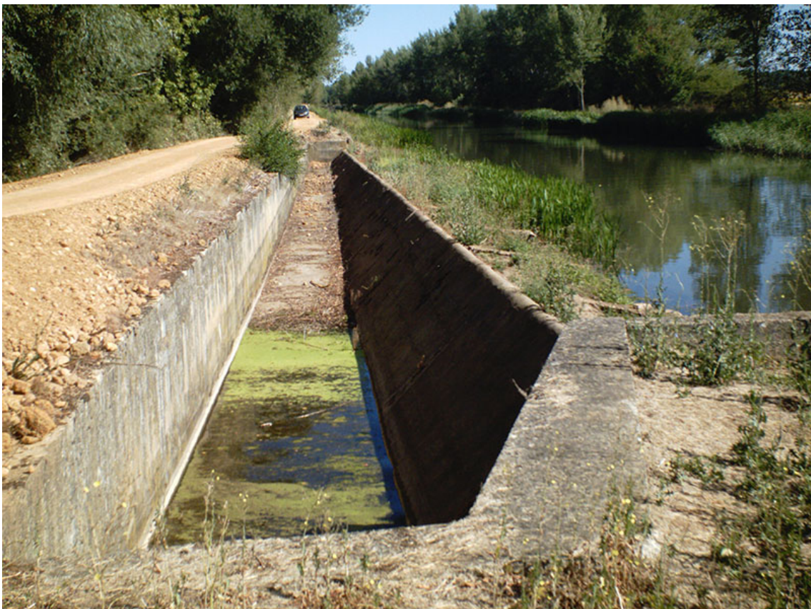
Link 15. Aliviadero de la esclusa 13. Fte.: El autor.
