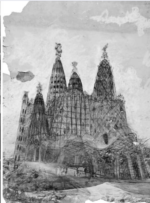
Reconstrucción del modelo funicular de la iglesia de la colonia Güell (expuesto en el Museo de la Sagrada Familia) y dibujo del exterior de la misma realizado por Gaudí sobre una fotografía del modelo original entre 1908 y 1914
