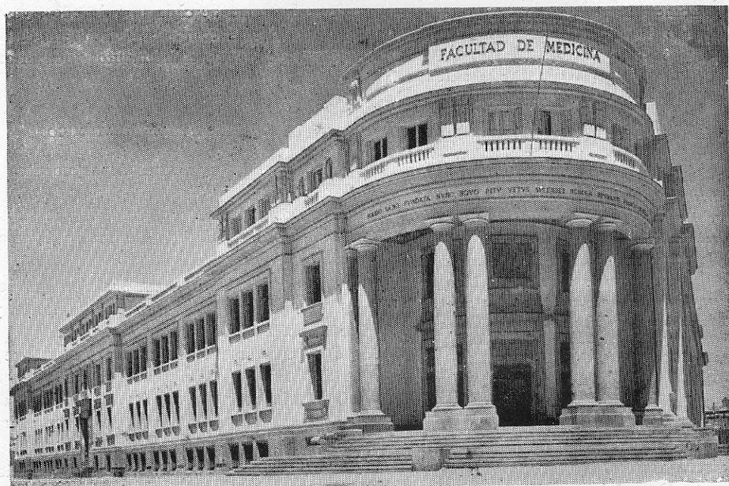
Fig. 5. — Edificio Facultad de Medicina.
