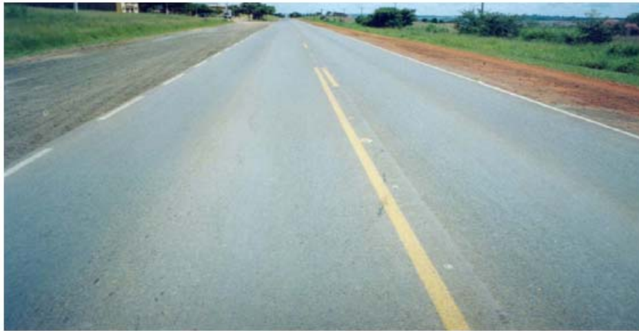
Foto 18. Tramo de prueba mezcla con residuos de cuero (carril de la izq.).
