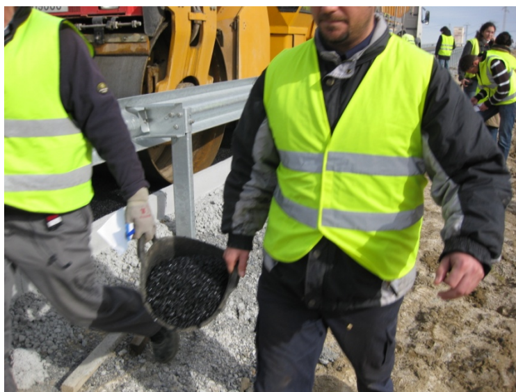
Foto 34. Recogida de muestras a la salida de la extendidora.
