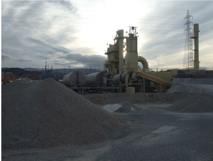
Foto 31. Vista General de la planta y los acopios de áridos.
