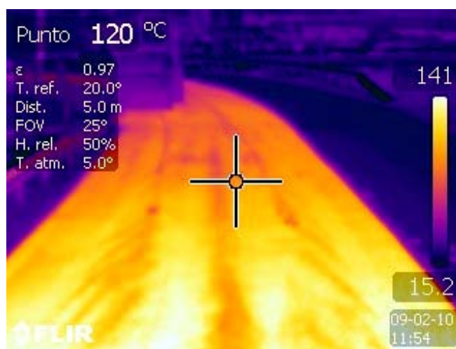
Foto 33. Temperatura de compactación de las mezclas.
