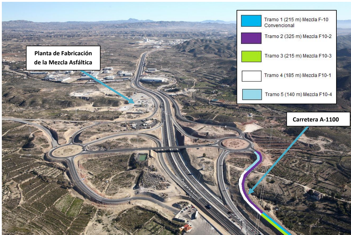
Foto 30. Vista general del tramo de prueba.
