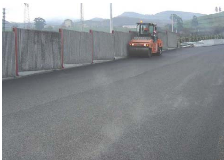
Foto 19. Puesta en obra de mezcla con escorias de acero (Tramo Nocedal- Balparda). Fuente: Acyma.
