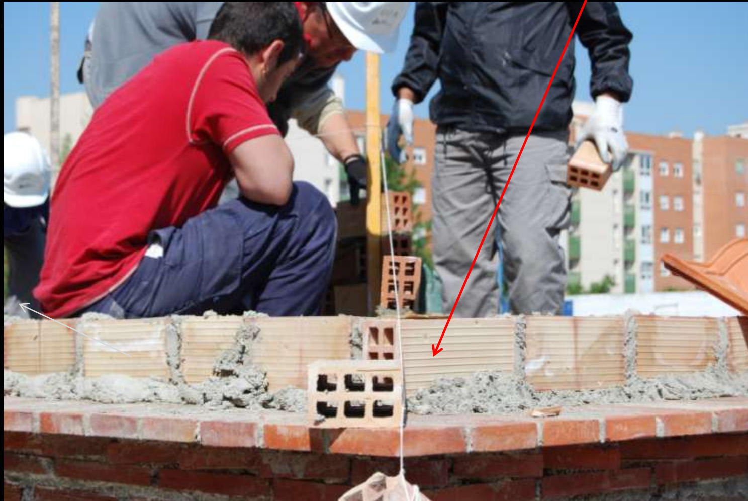
REPLANTEO Y EJECUCIÓN DE TABIQUES ALIGERADOS
