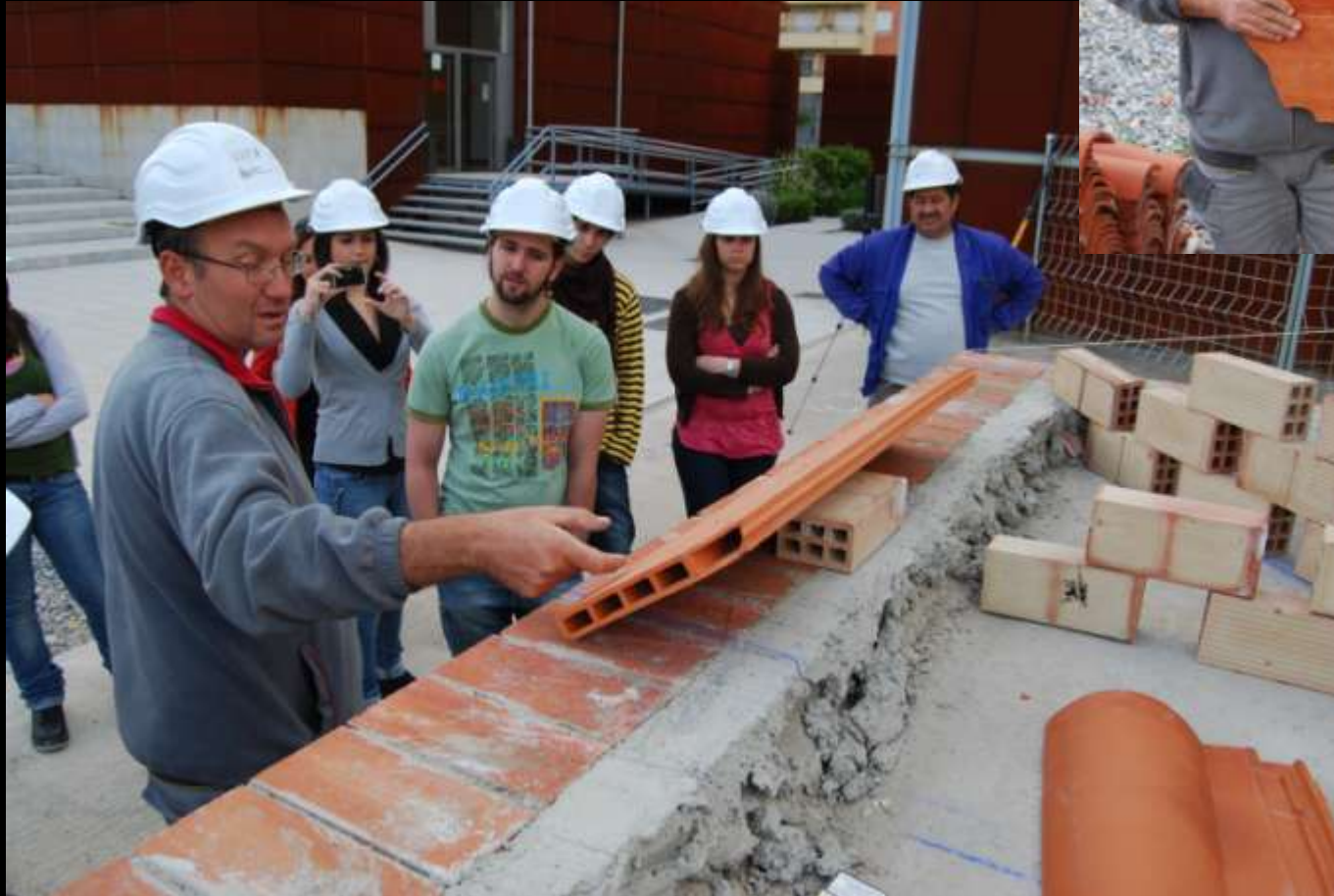
FORMACION DE FALDONES CON RASILLAS MACHIHEMBRADAS
