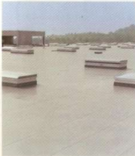
La unión entre láminas puede hacerse por aire caliente (ilustración) o soldadura química.
