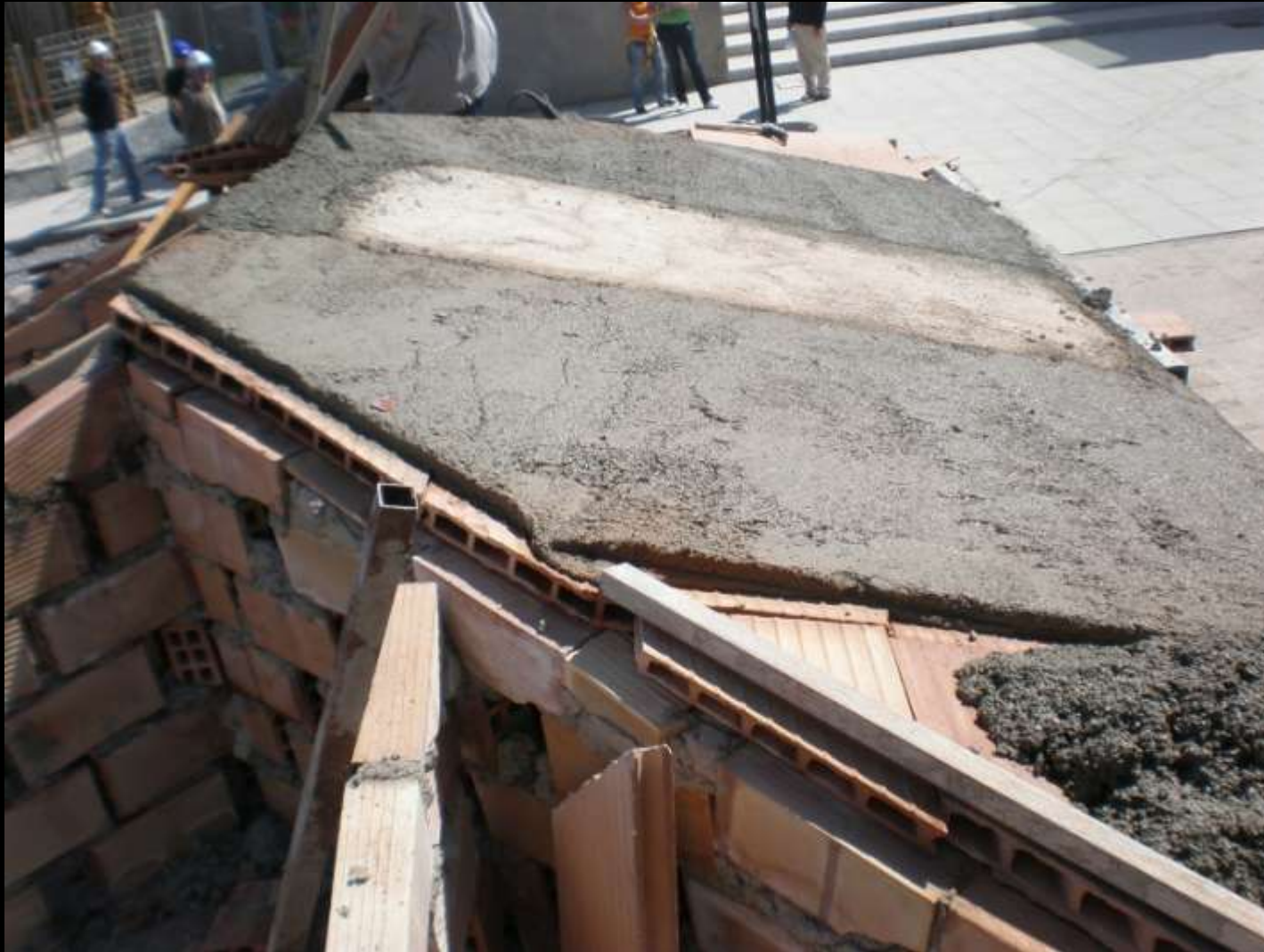
CAPA DE COMPRESIÓN CON MORTERO DE CEMENTO
