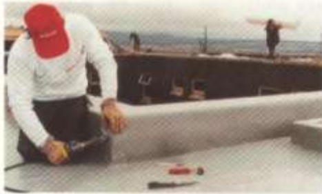
La unión entre láminas puede hacerse por aire caliente (ilustración) o soldadura química.
