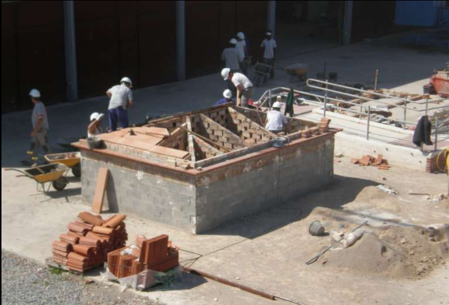
EJECUCION DE TABIQUES ALIGERADOS Y FORMACIÓN DE PENDIENTES
