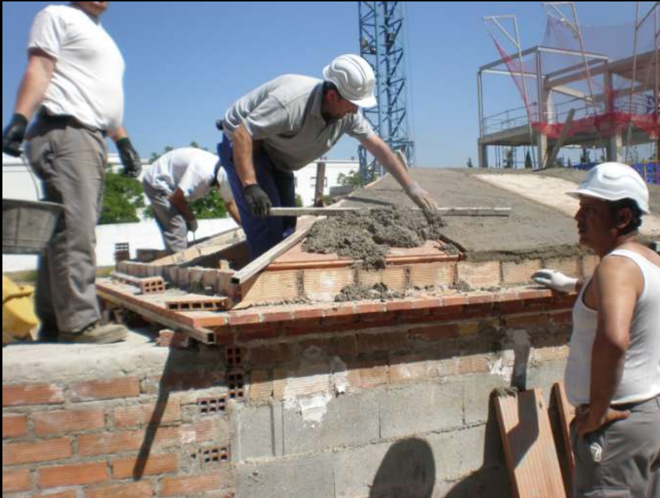
CAPA DE COMPRESIÓN CON MORTERO DE CEMENTO
