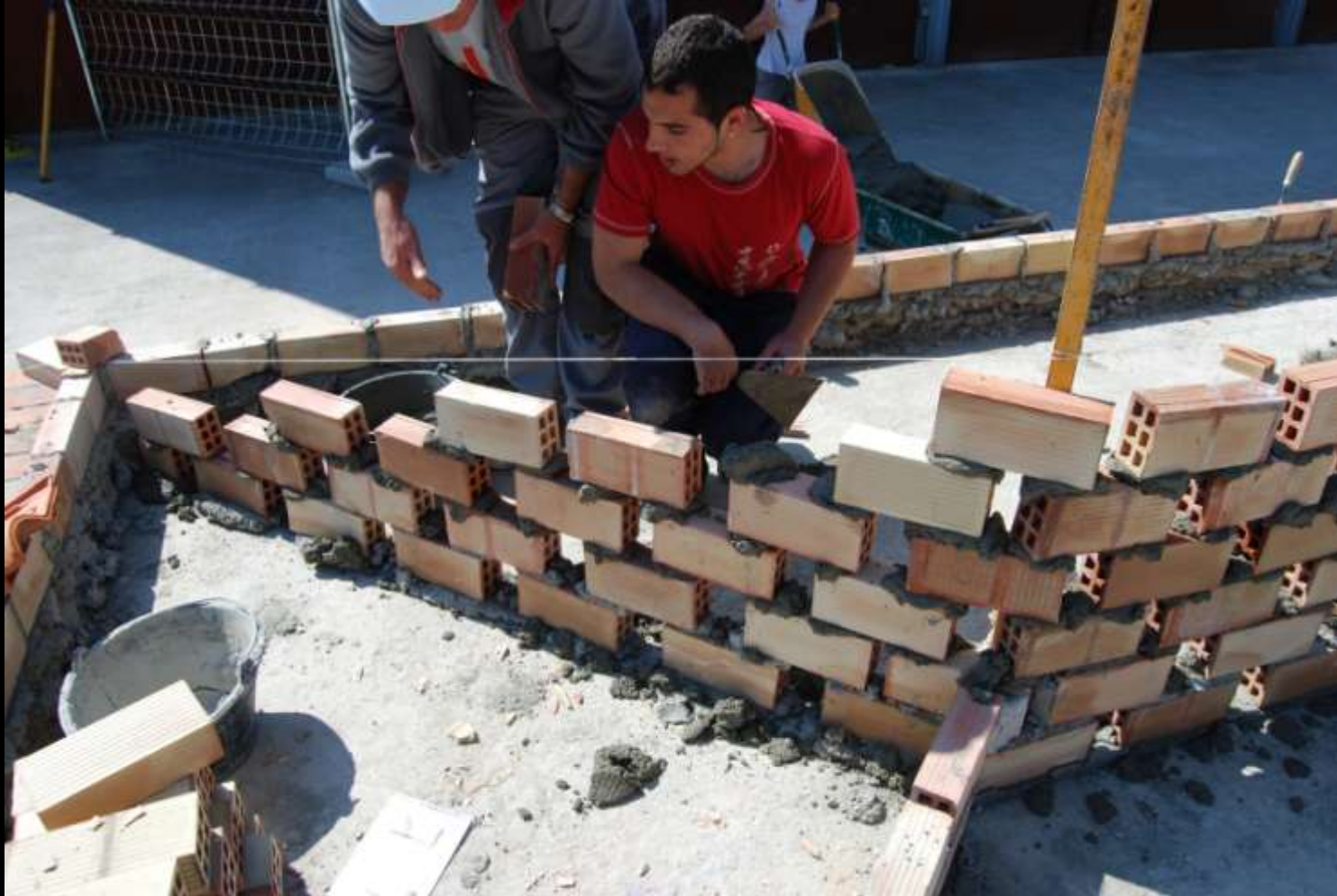
REPLANTEO Y EJECUCIÓN DE TABIQUES ALIGERADOS
