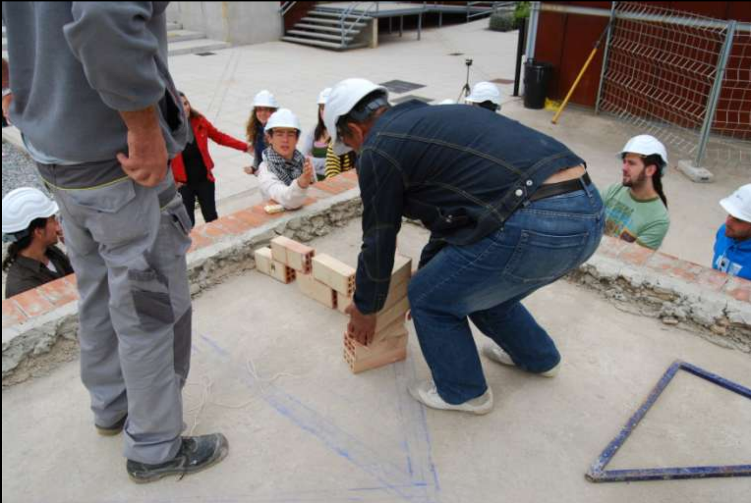
TRAZADO DE LIMAS EN FORJADO Y EJECUCIÓN DEL ALERO
