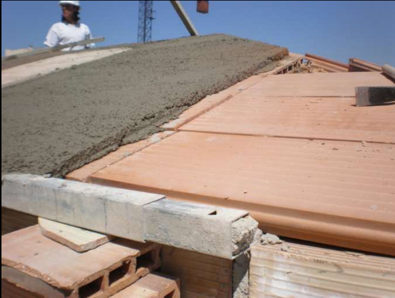
CAPA DE COMPRESIÓN CON MORTERO DE CEMENTO
