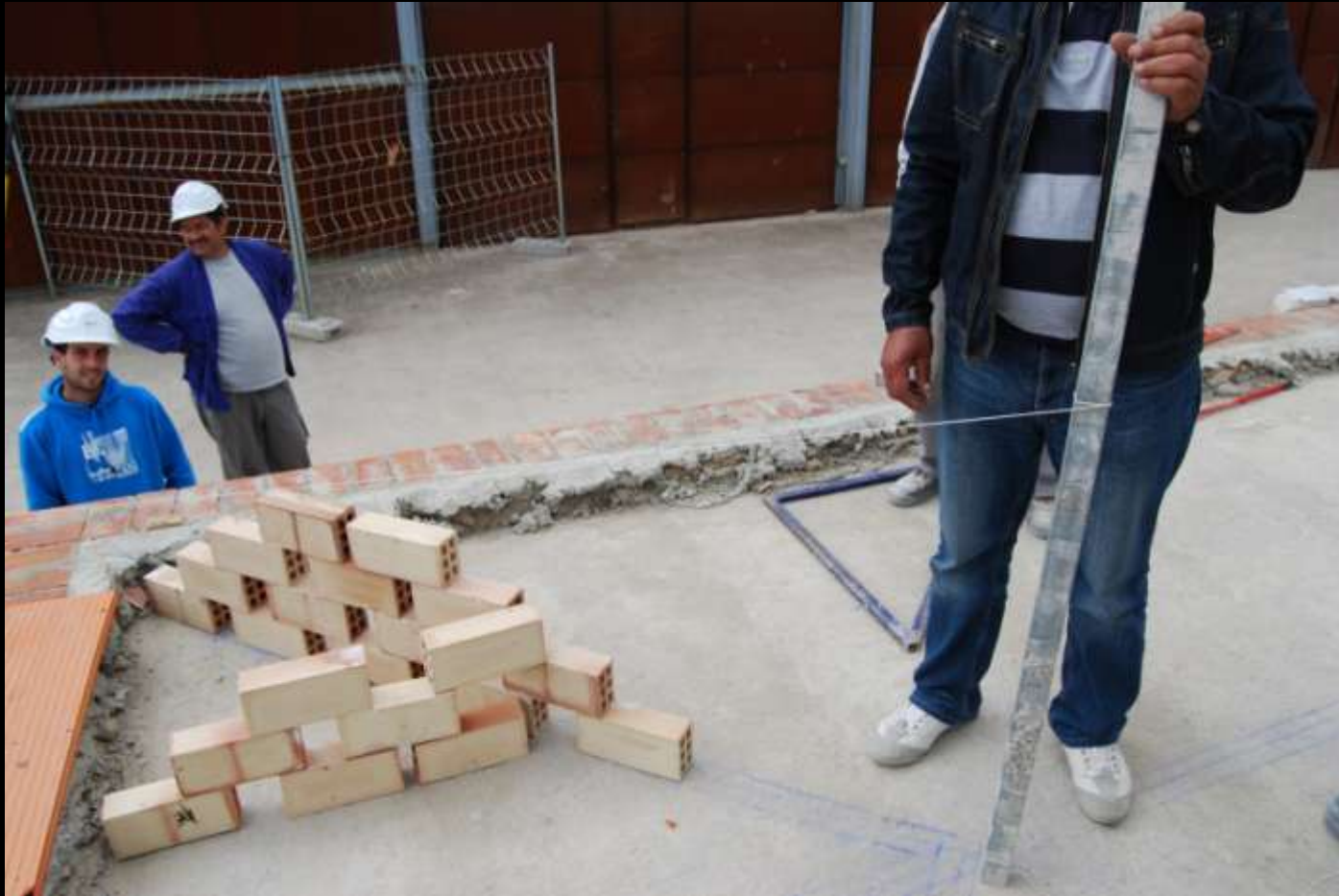
REPLANTEO DE PENDIENTES EN LIMATESA CON REGLA Y CUERDA
