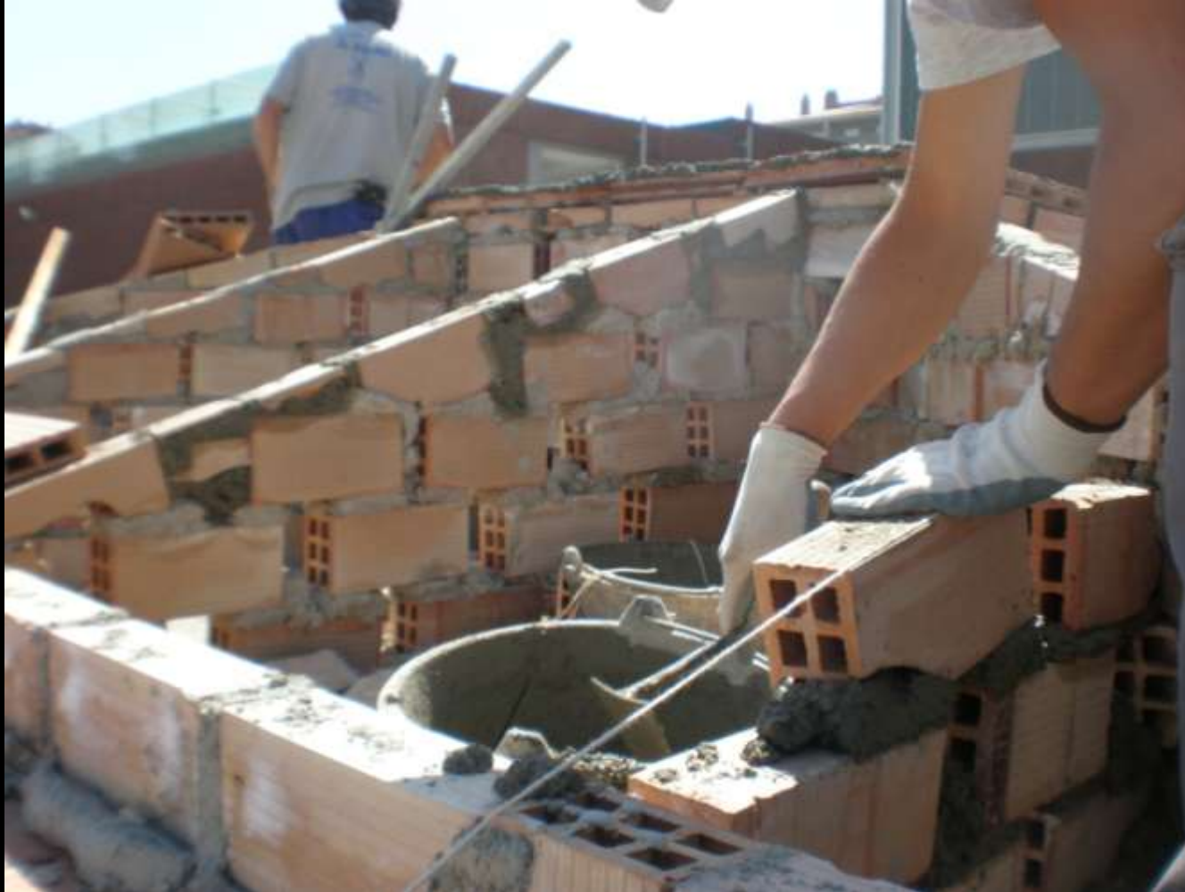
REPLANTEO Y EJECUCIÓN DE TABIQUES ALIGERADOS
