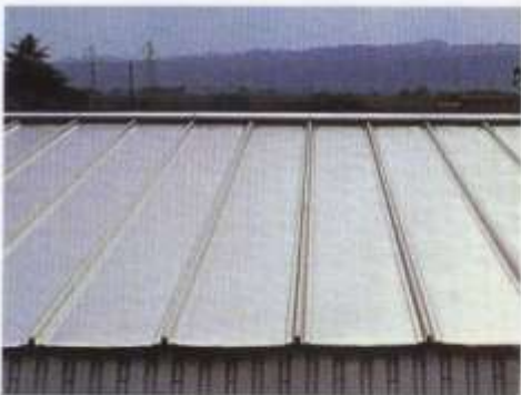
Cubierta en aluminio prelacado; longitud de bandeja 14,60 m; pendiente 3%.
