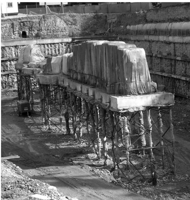
Figura 7. Fase final para la conservación del muro en su posición original. Se pueden apreciar los micropilotes, bulones y perfiles laminados en L.
