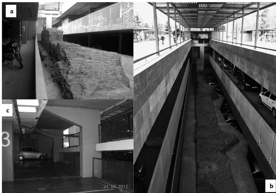
Figura 9. a) Vista del muro desde el nivel -1; b) Vista actual del dique a través de un hueco realizado en el último forjado del parking; c) Pilares apantallados con ménsula de canto variable en el nivel -3 que sustenta la losa sobre la que descansa el muro.
