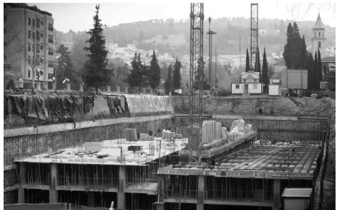
Figura 8. Muro inmerso en el proceso constructivo del parking (Fotografía cedida por SITE S.A.)
