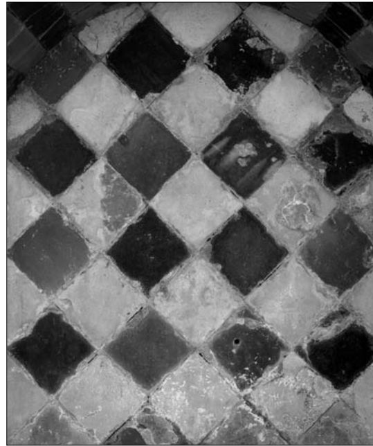
Fig. 9. Detalle hornacina en una de las pilas de baytal-sajum . Baño de Comares. Alhambra de Granada. (Foto: Vicente del Amo).
