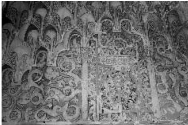
Figura 4. Fragmento de yeserías realizado mediante procedimiento de talla.
