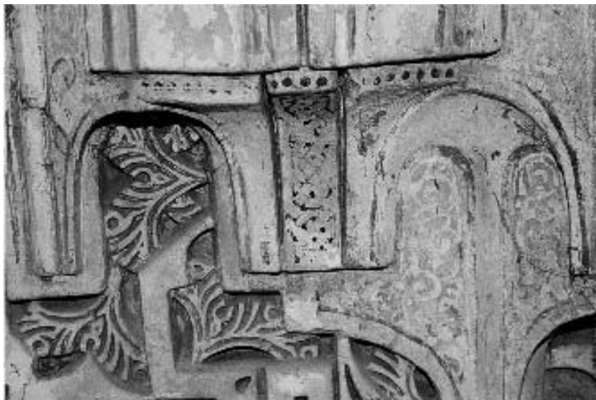
Figura 7. Detalle de los restos de decoración pintada original en los mocárabes
