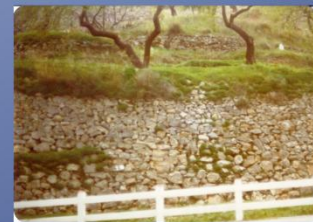
Fig 2. Zonas de muestreo: muros de contención, con huecos donde se colocan las trampas.
