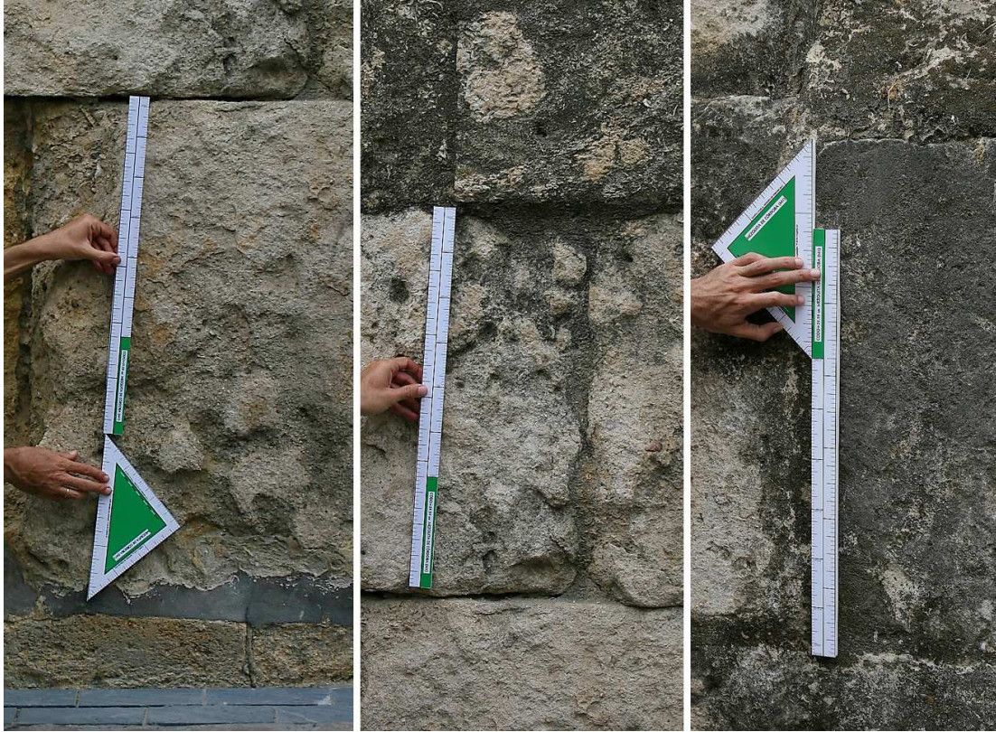
Ilustración 189. Sillares de la fachada sur
