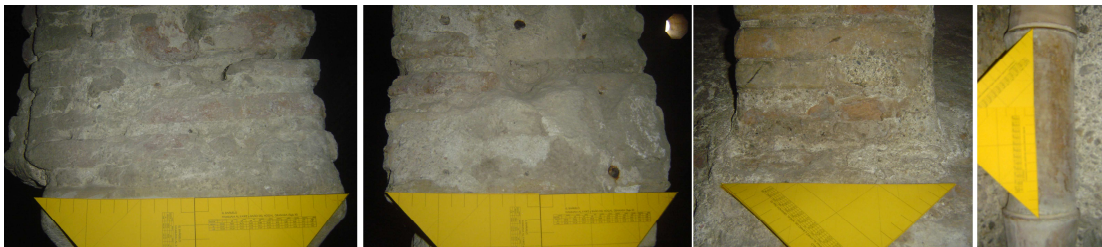
Ilustración 214. Espesor de arquerías y atañor
