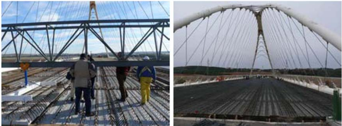
Figs. 10a y 10b: Vista durante las operaciones de colocación de prelosas en el tablero y con el tablero ferrallado
