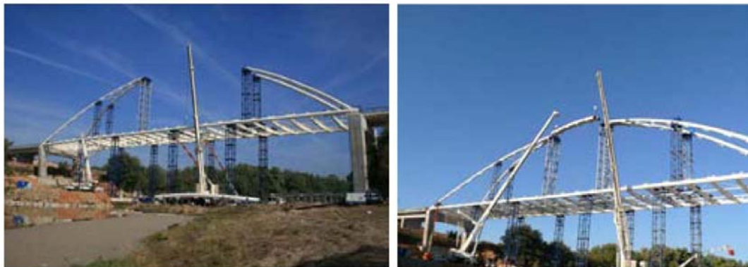
Figs. 9a y 9b: Vista durante las operaciones de izado de los arcos, y fase de cierre en clave de los arcos
