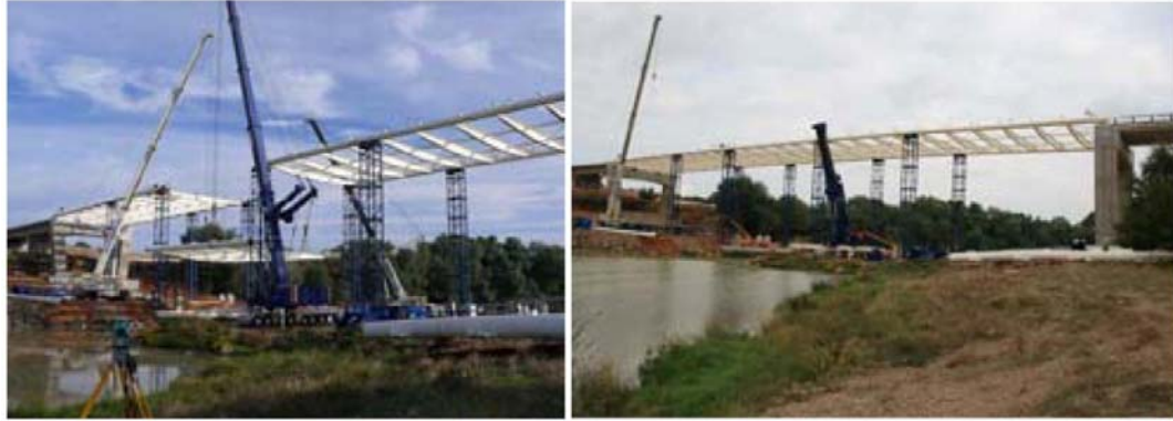
Figs. 8a y 8b: Izado de un tramo de tablero y vista del tablero metálico del puente concluido y apeado
