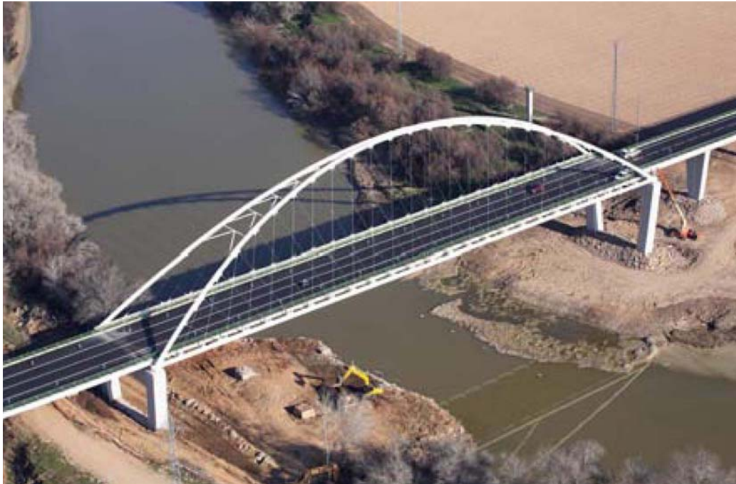
Fig.1: Vista aérea del Puente Arco sobre el Río Guadalquivir
