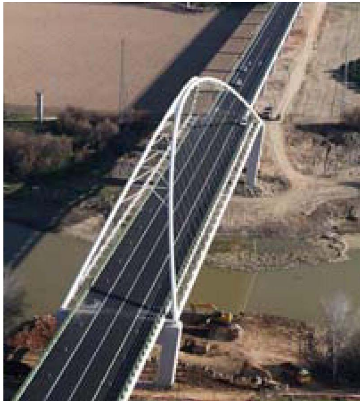
Fig. 4: Vista aérea frontal del Puente Arco sobre el Río Guadalquivir
