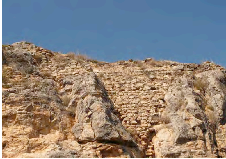
Muros de mampostería que servían de base al tapial calicastro (L 3 y L 4)
