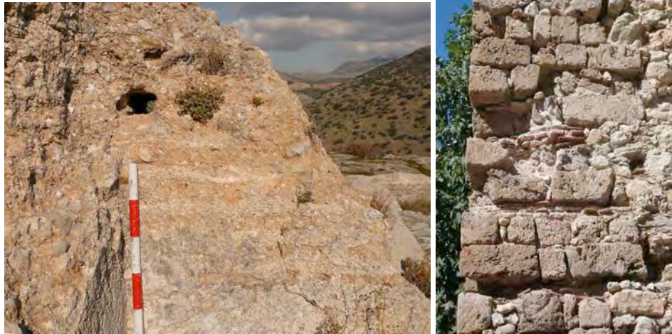
Detalles constructivos del tapial calicastro (T 1) y de los sillares de esquina de la torre de mampostería (T 4)
