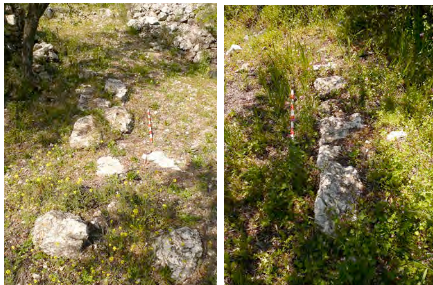
Otros dos muros de mampostería de diferentes estructuras
