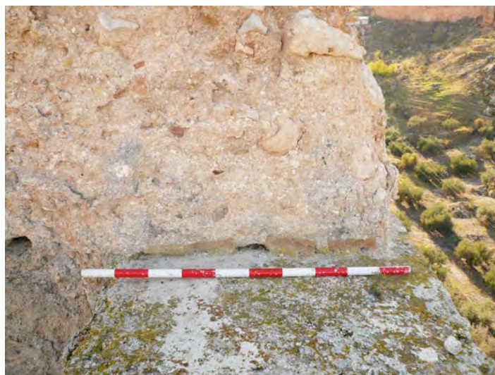
Contacto entre la E 8 y la torre T 1, separada por una hilada de ladrillos
