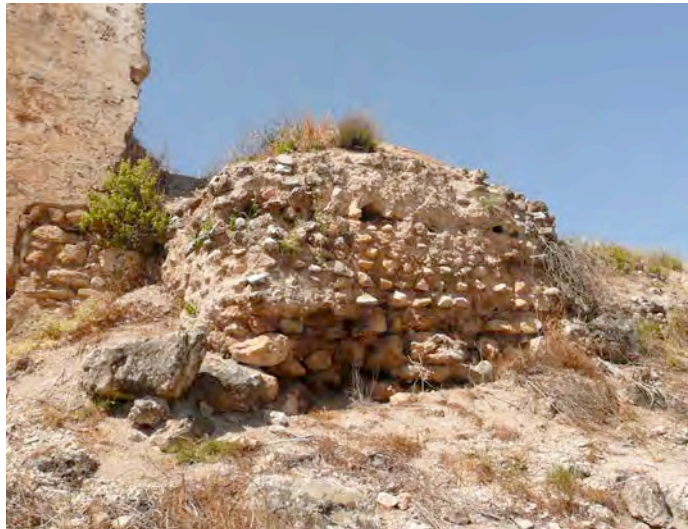
Torre de tapial de calicanto, denominada torre B
