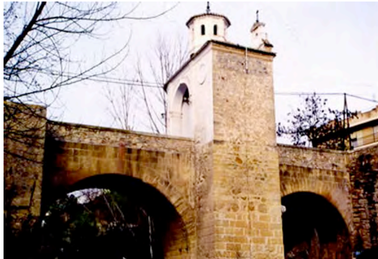
El puente de Pinos Puente con su aparejo de sillares a soga y tizón
