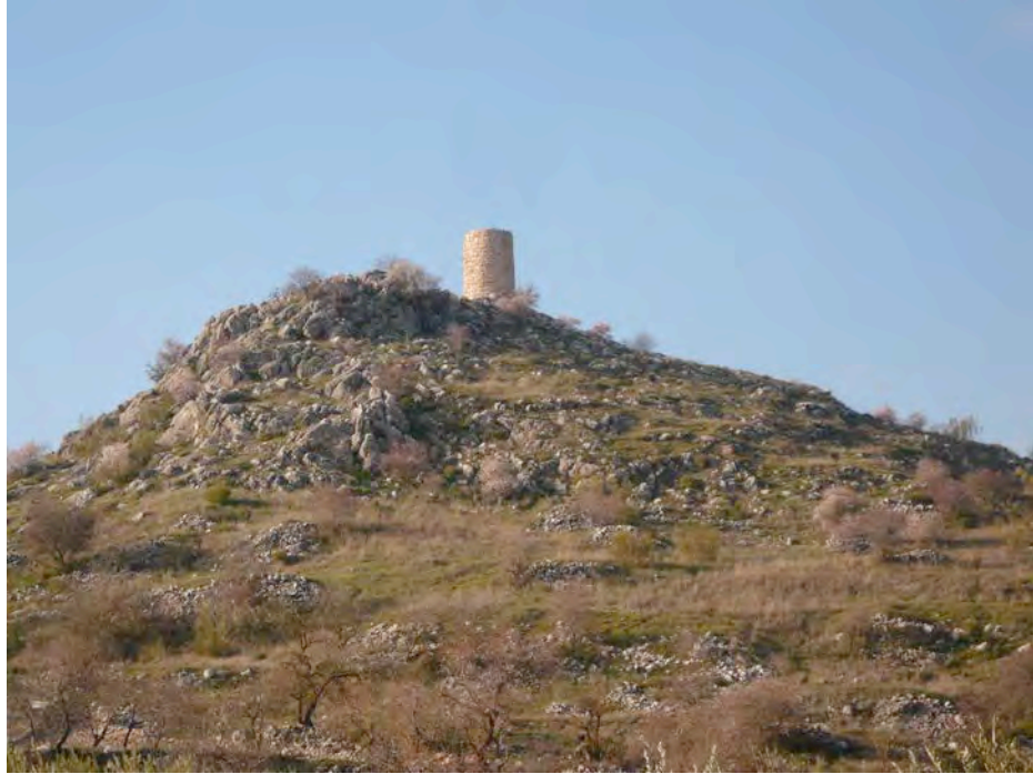
Ubicación de la torre en lo alto de un cerro
