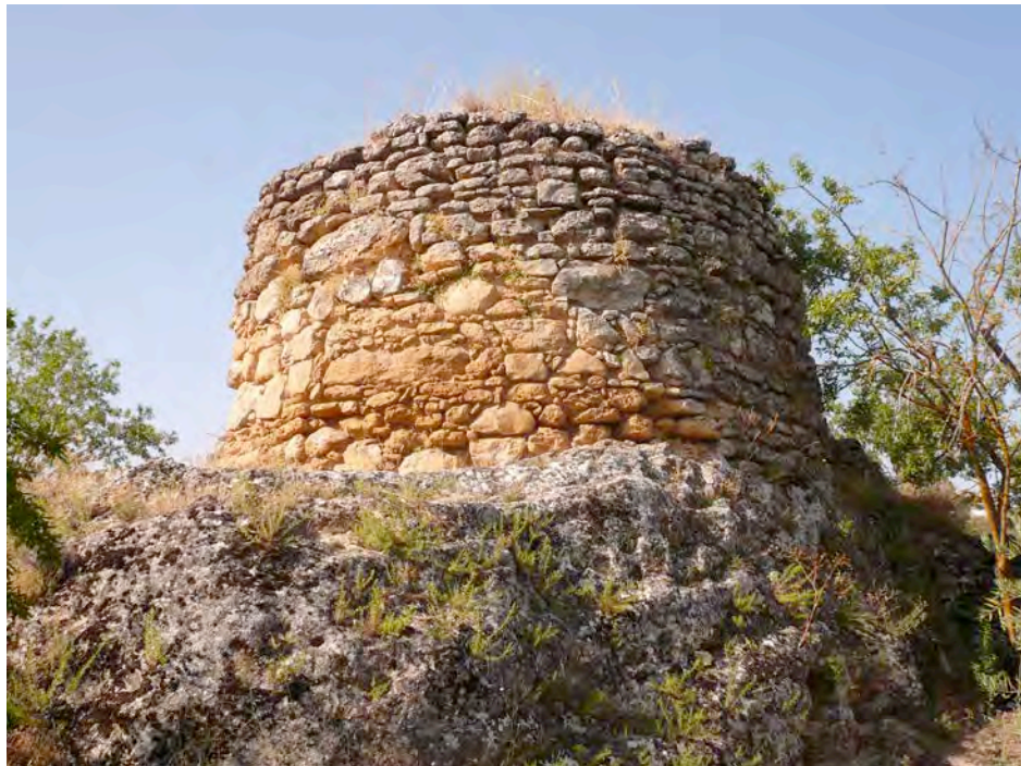
Panorámica del lado noreste de la torre de los Anillos
