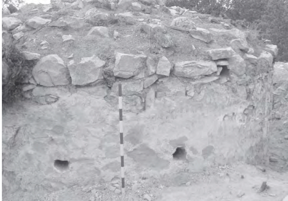
Detalle del enlucido y de los mechinales (Fuente: PEDREGOSA, 2007: 218)
