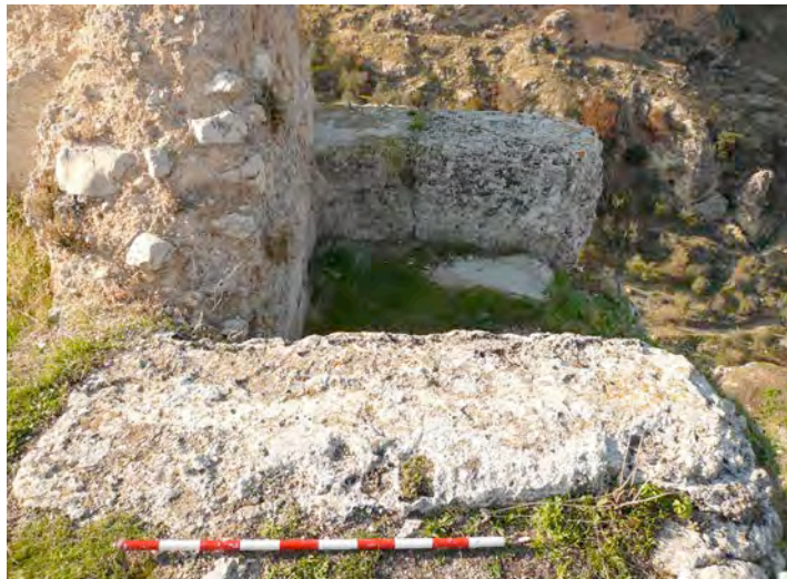
Tapial hormigonado de la E 8, a la que se apoya la torre de tapial calicastro T 1
