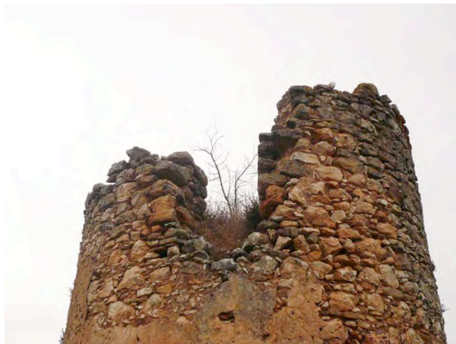
Puerta de acceso a la torre situada al sureste
