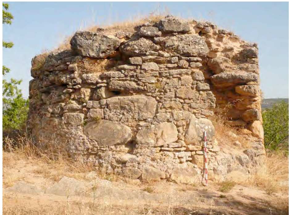
Vista meridional de la torre de los Anillos
