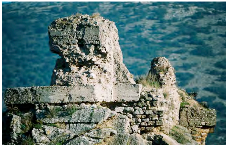
Detalle de la torre principal (T1) del castillo de Colomera
