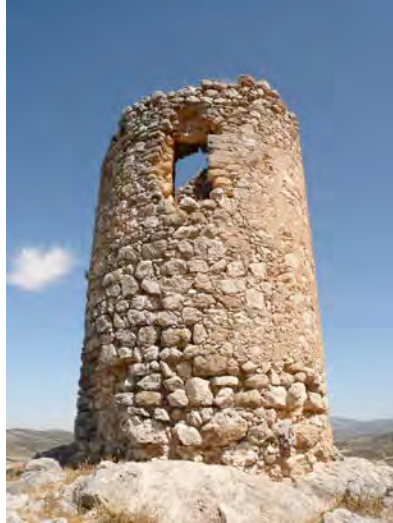
Panorámica del lado sureste de la torre
