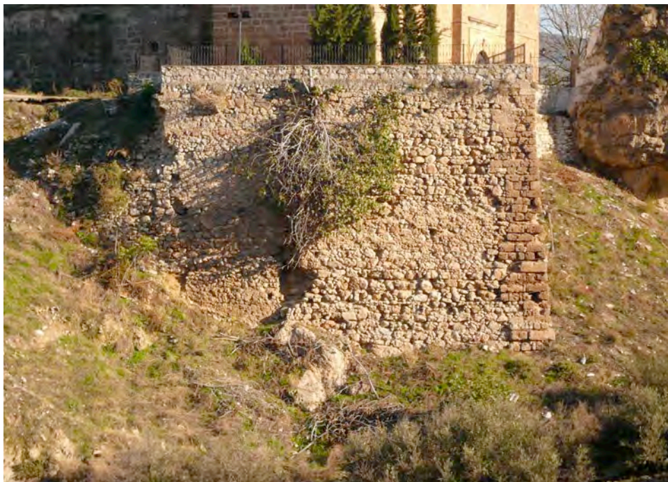
Paramento oeste de la torre de mampostería ordinaria separada por ripios (T 4) bajo el basamento de la iglesia
