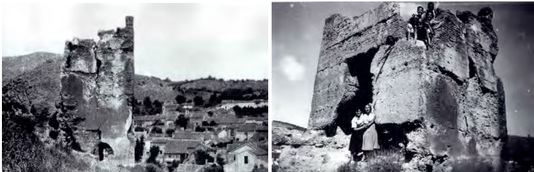
Foto antigua del castillo de Illora, torre H (Fuente: Valenzuela y Valenzuela, 2009)
