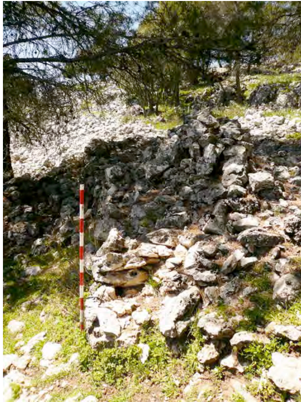
Muralla de mampostería
