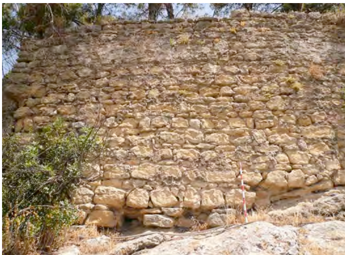
Tramo del recinto de la villa (L 2) construido con mampostería enripiada
