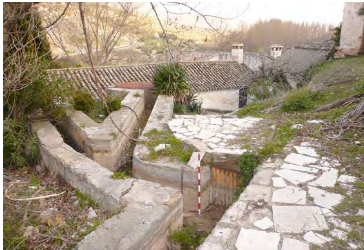
Separación de la acequia y entrada de agua a los cubos del molino del Puente
