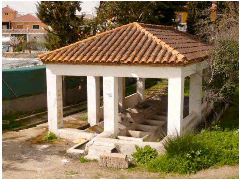
Lavadero en proximidad de donde surge el manantial
