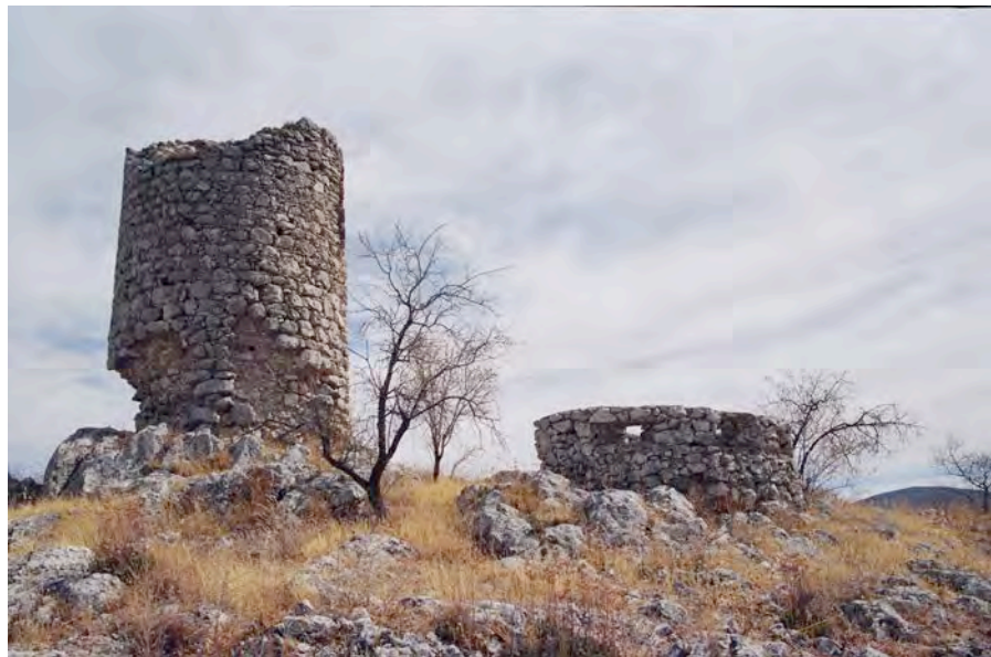
Torre y nido de ametralladora de la Guerra Civil. Se puede apreciar la lagunas de los mampuestos que se han substraídos y la gran similitud con los que se han empleado por construir el nido
