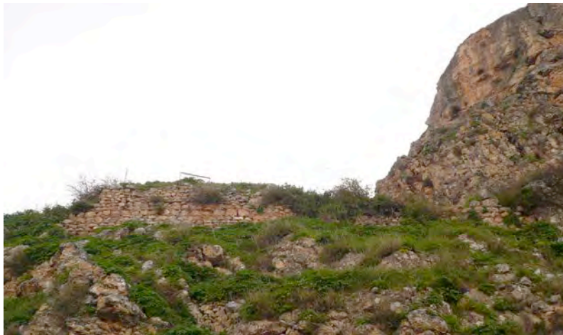
Muro de mampostería del recinto exterior (L 15)
