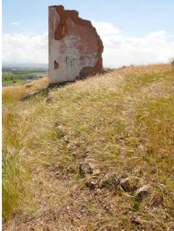
Estructura de mampostería con al fondo la estructura moderna/contemporánea, que la utiliza de cimentación
