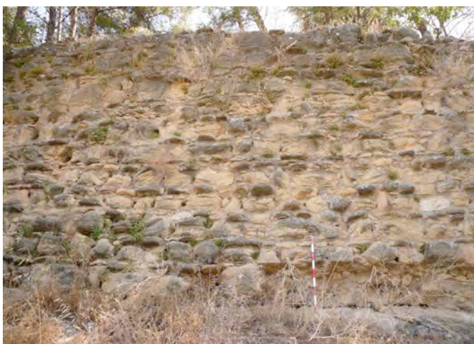
Tramo del recinto de la villa (L 8) construido con mampostería enripiada
