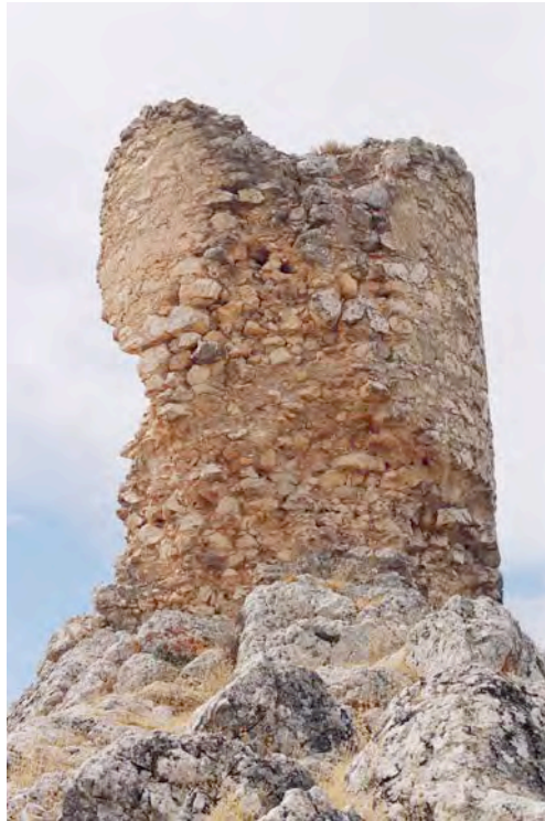
Torre de Mingoandrés antes de su restauración
