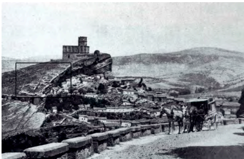
Foto de principio del siglo X, se aprecian las estructuras excavadas en la roca
