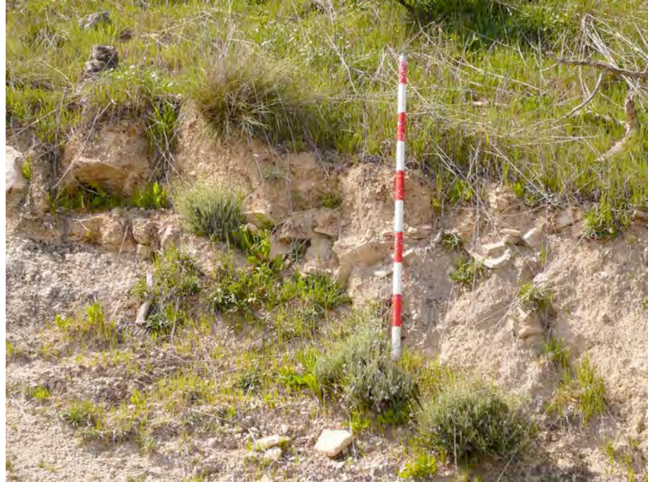
Derrumbe de tejas en un corte de un camino rural
