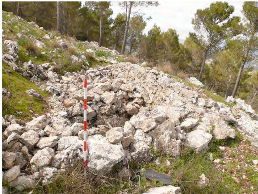
Restos de estructura derrumbadas
