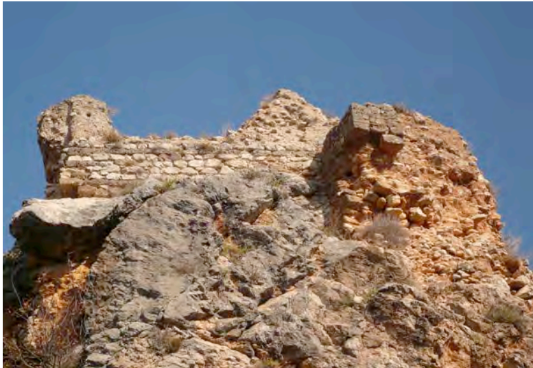
La torre T 2 realizada con sillares trabajados
