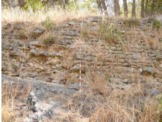
Tramo del recinto de la villa (L 8) construido con mampostería en hiladas
