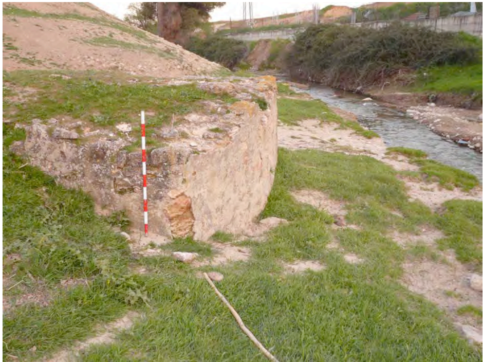
Estructura en el cauce del río, posible basamento para el arco de un puente
