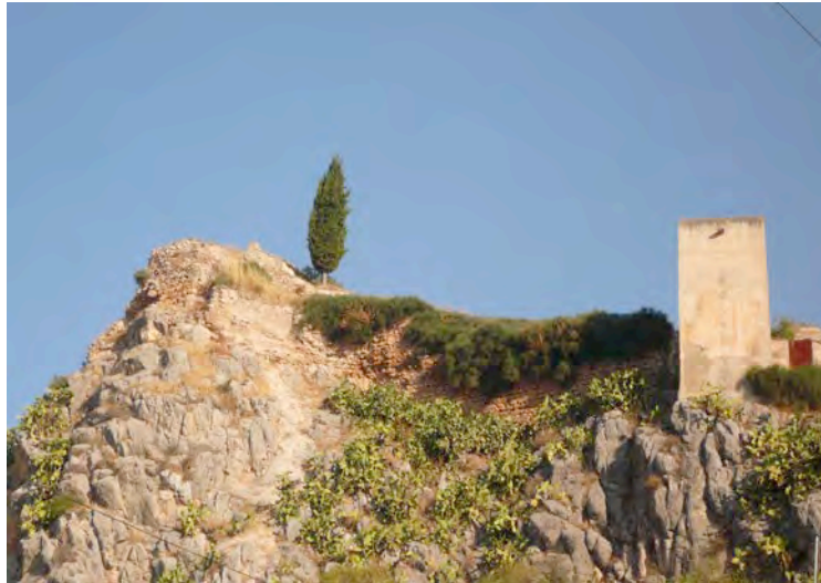
Vista general de las torre P (derecha) y D (izquierda) y del lienzo PD
