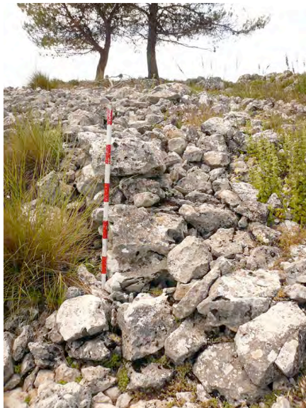
Otra imagen de la muralla de mampostería derrumbada
