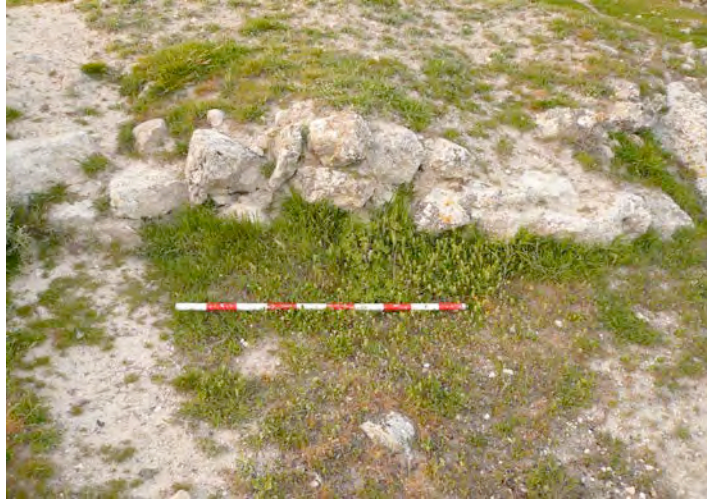
Estructura de mampostería
