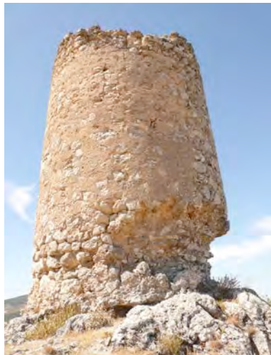
Vista del lado oriental, donde se ha conservado el enlucido original
