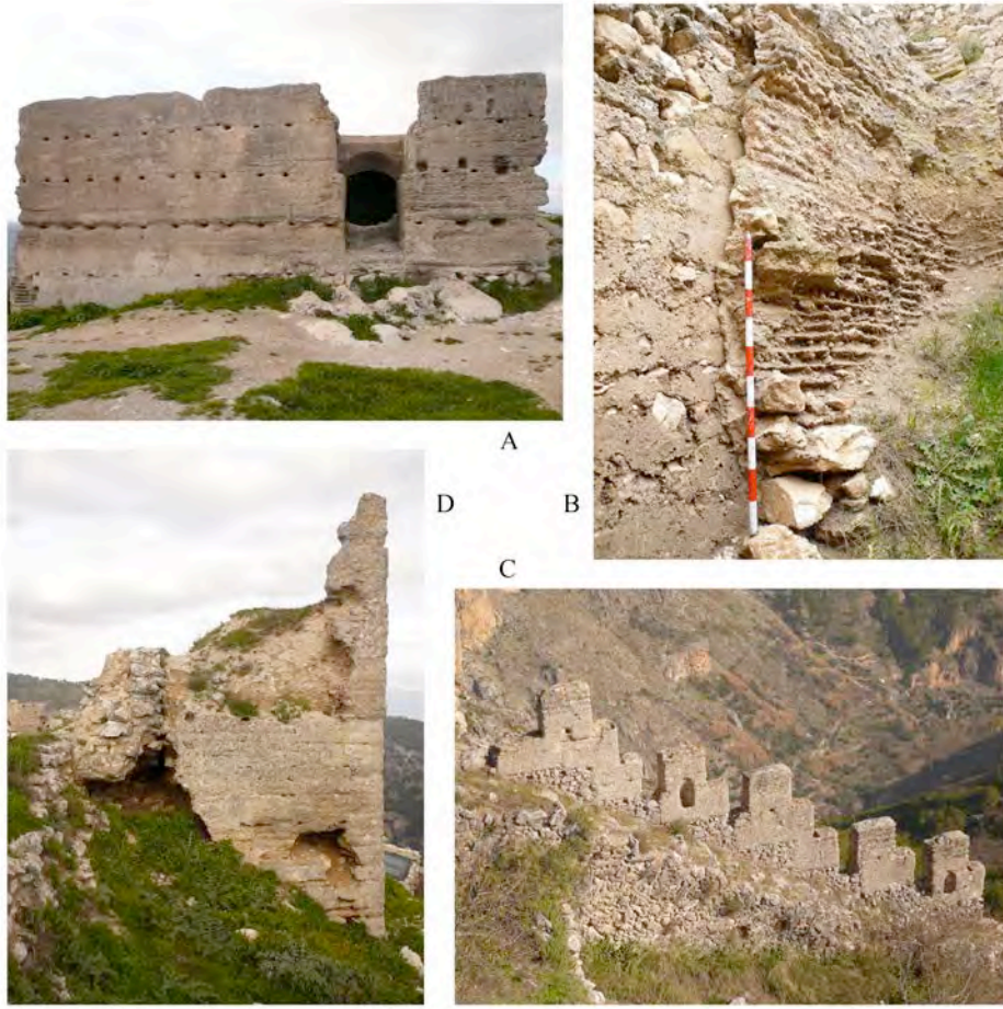
Varias estructuras de tapial
