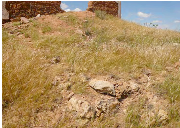
Estructura de mampostería bajo la estructura moderna/contemporánea
