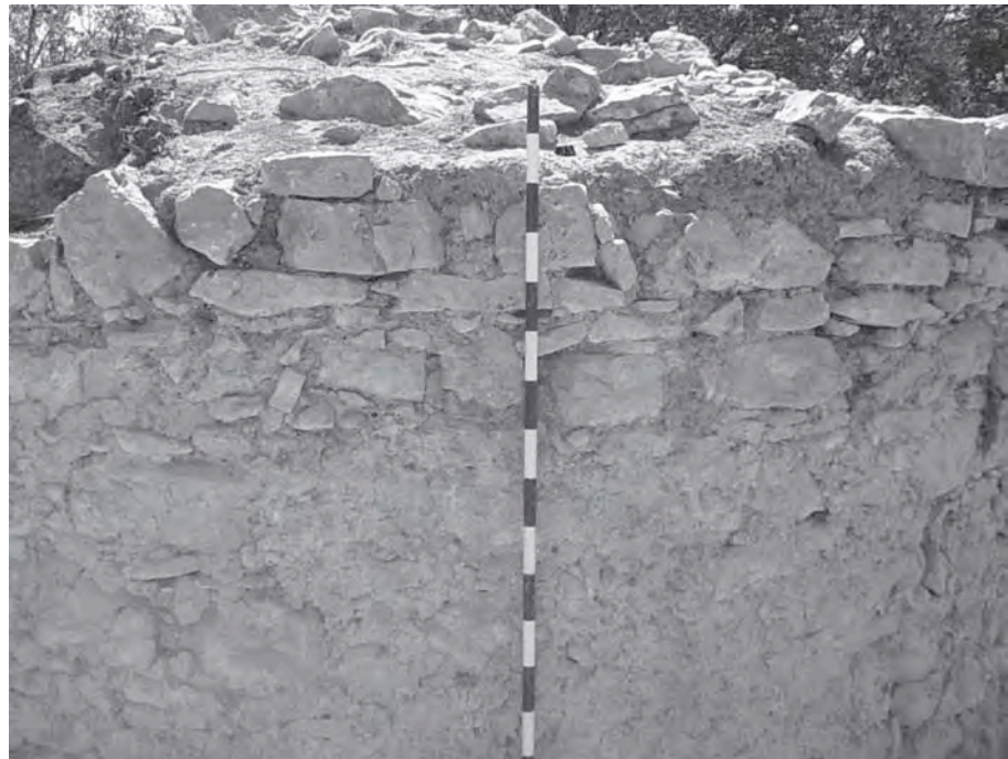
Detalle de la técnica constructiva donde se aprecian la verdugada con lascas y ripios (Fuente: PEDREGOSA, 2007: 217)
