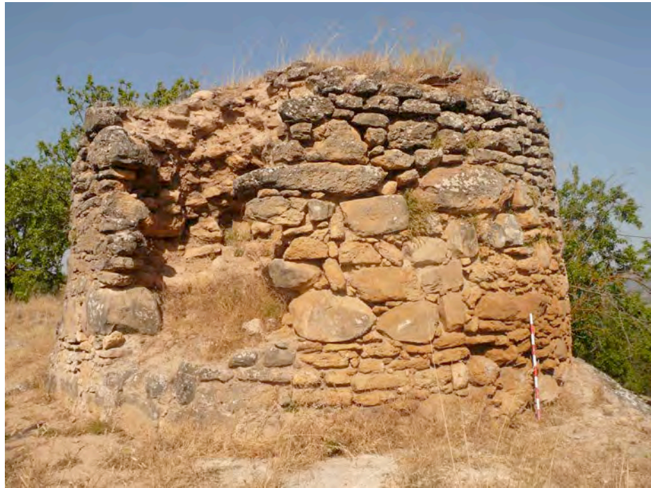
Vista oriental de la torre de los Anillos
