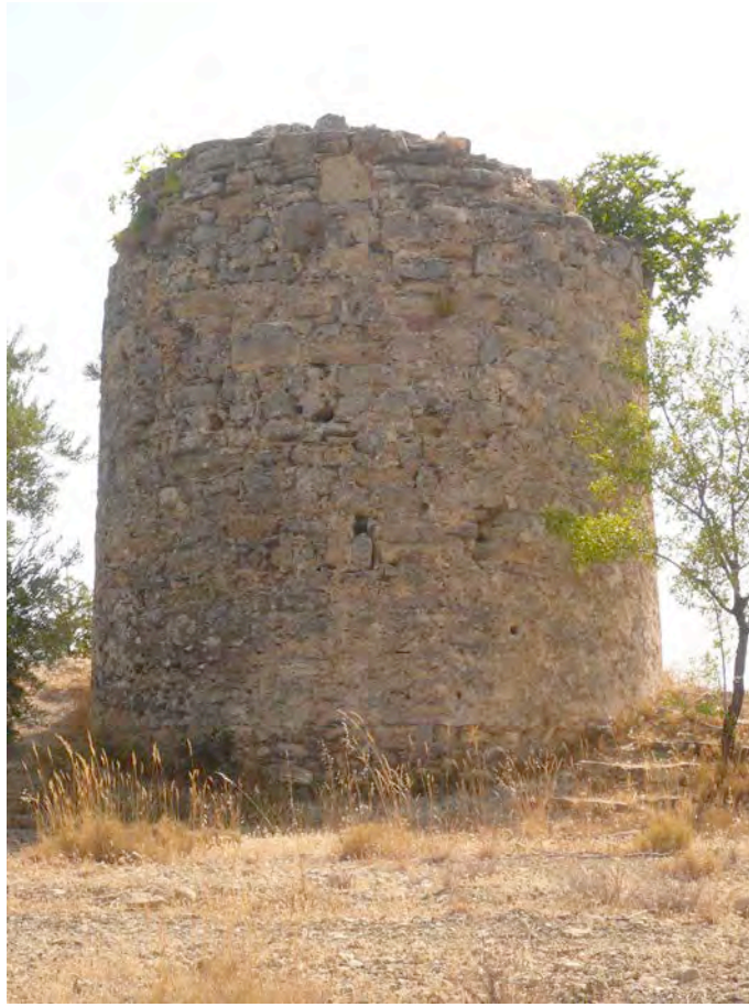
Vista noroeste de la torre
