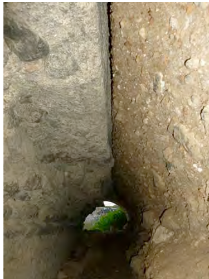
Dos fases distintas de tapial en el pasadizo de ronda bajo la torre H
