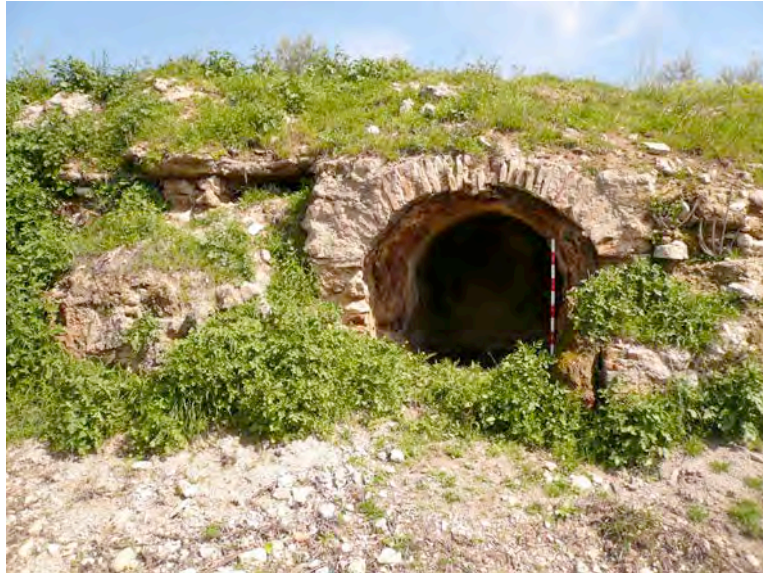
Aljibe y estructuras asociadas al mismo
