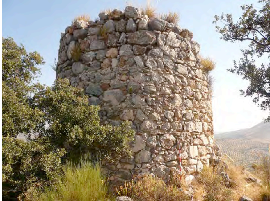
Torre de la Mesa en su parte suroeste
