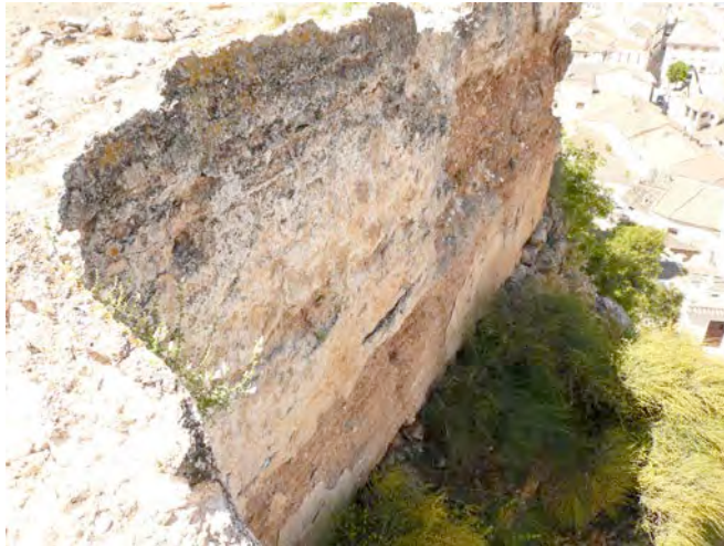
Detalle del tapial calicastrado en el lienzo 3
