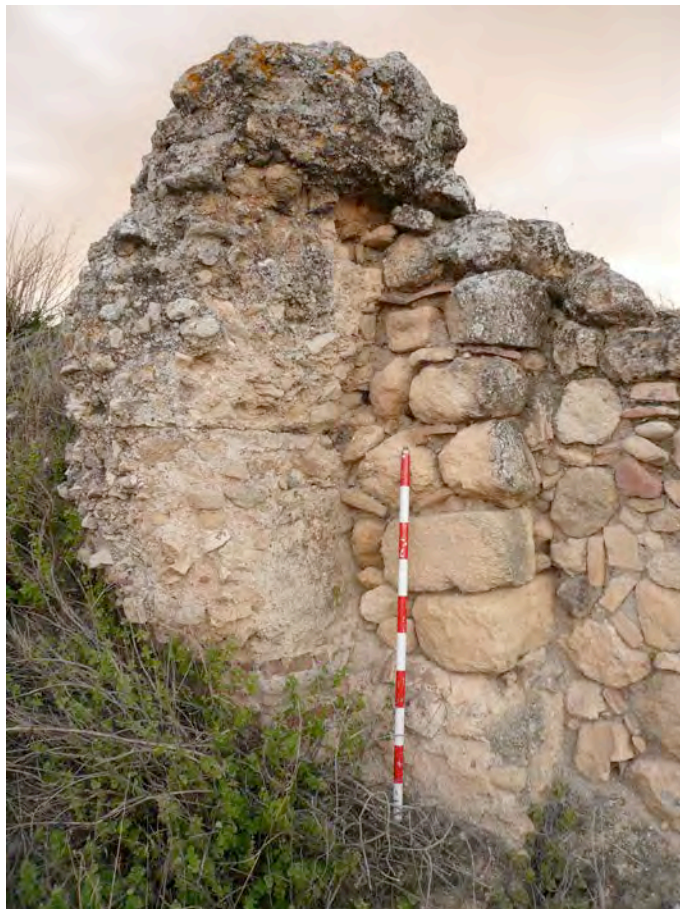
Punto de contacto entre dos estructuras, pertenecientes a dos fases distintas y construidas con técnicas diferentes
