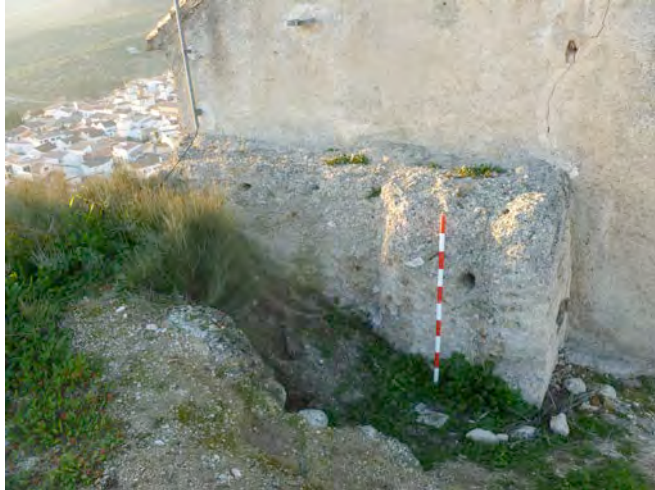
Detalle del tapial calicastrado en la denominada torre D
