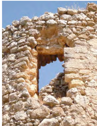
Detalle del vano de acceso, se aprecian los sillares y la gorroneira
