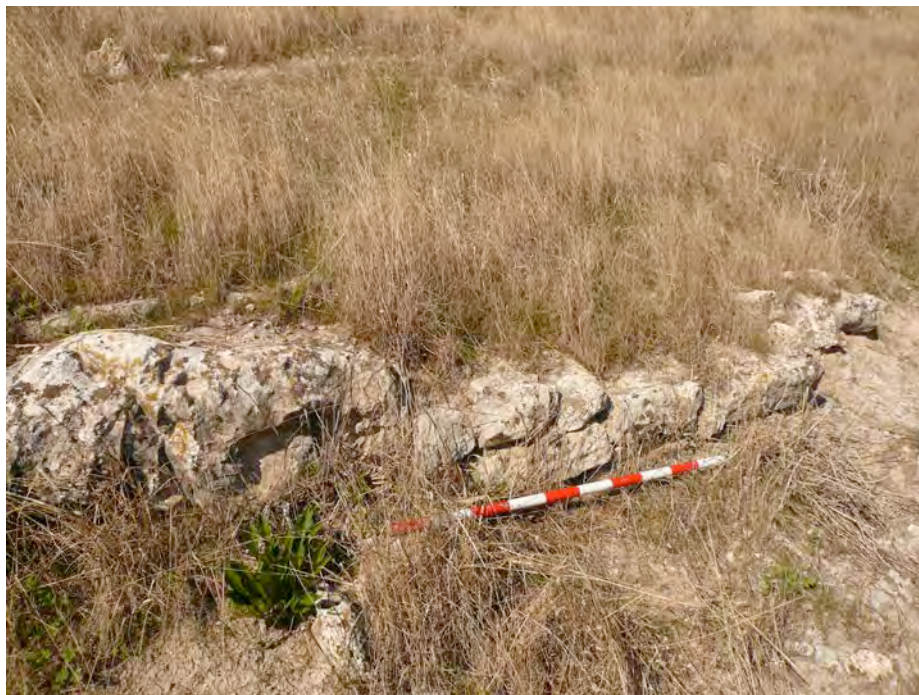
Estructura de mampostería en la parte inferior del asentamiento
