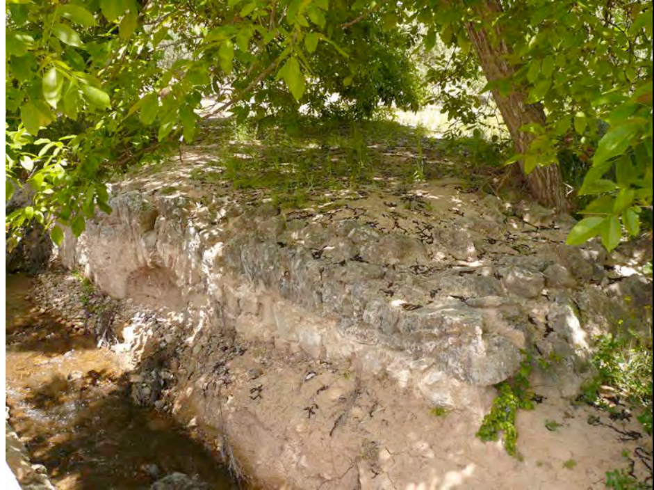
Puente sobre el arroyo Cañada, perteneciente a un camino secundario de la vía que conectaba Zujaira con Íllora
