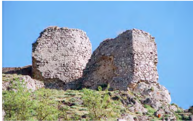
torre semicircular L y torre poligonal M en la zona noroccidental de la alcazaba
