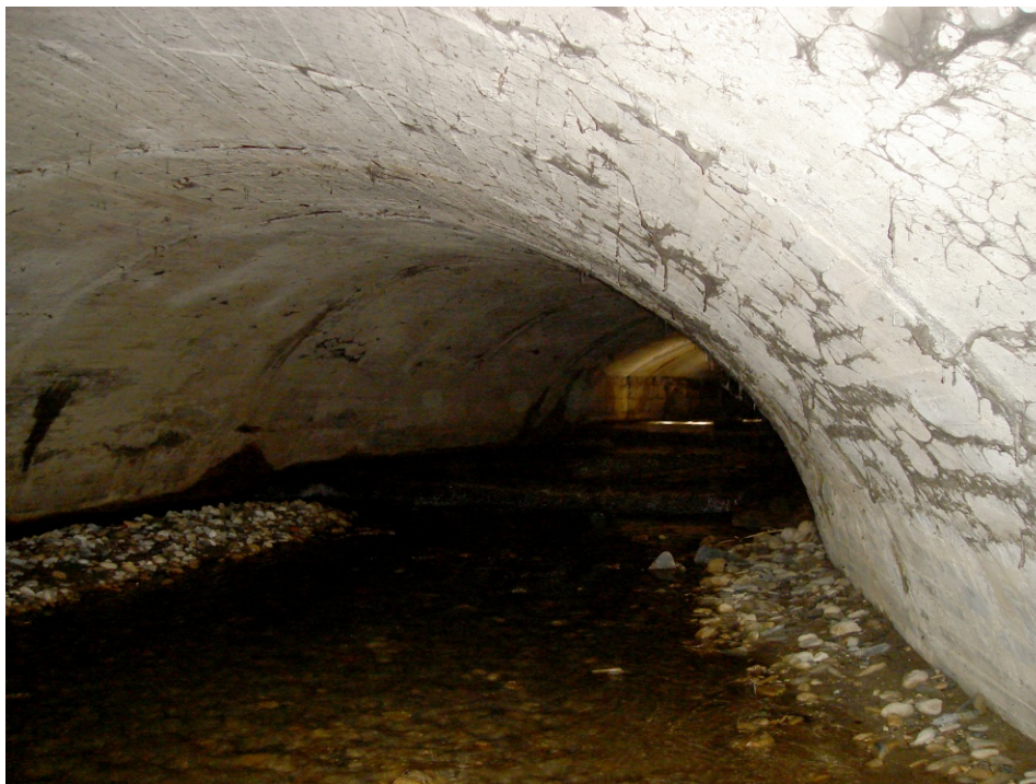
Fig. 87. Curva del embovedado en Puerta Real (tomada en sentido opuesto al descenso de las aguas), Junio de 2011.
