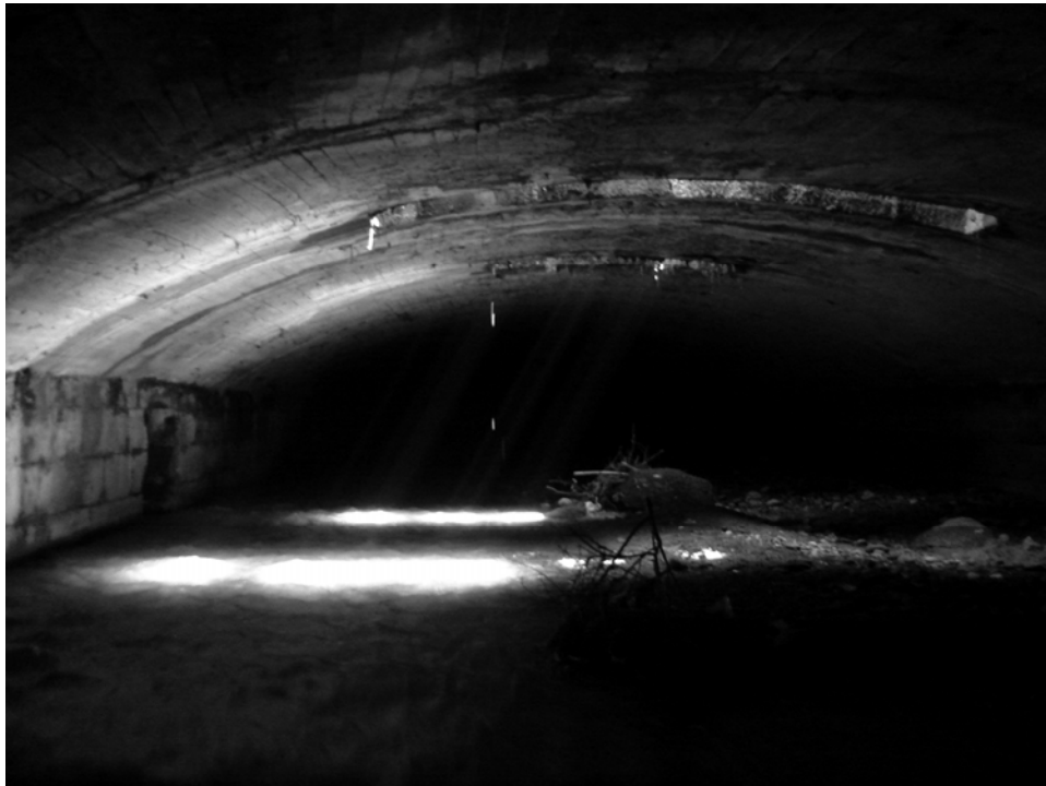
Fig. 88. Interior del embovedado en Puerta Real. Se observan los dos registros ejecutados en 1951. Actualmente es el único punto de entrada de luz natural en todo el curso cubierto del río. Junio de 2011.
