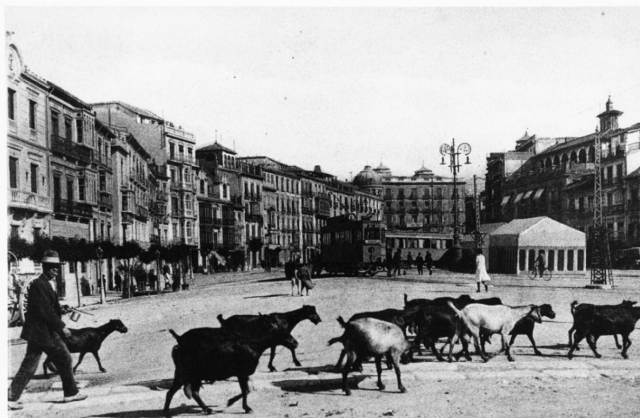
Fig. 65. Vista de la explanada del Embovedado donde se aprecia la “joroba”, en 1930 (AHMG).
