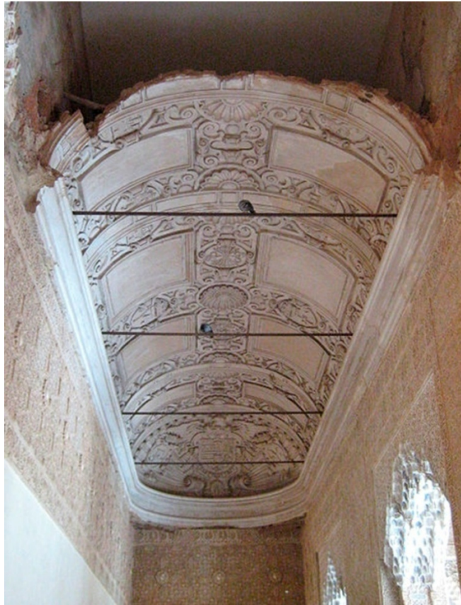
Fig. 39. Estado actual de la sala de los mocárabes, con la bóveda de yeso que sustituyó a la techumbre original.
