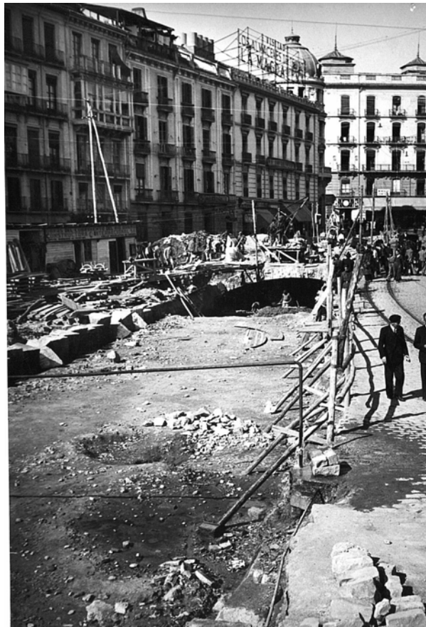
Fig. 67. Reforma del embovedado, 1940 (AHMG).
