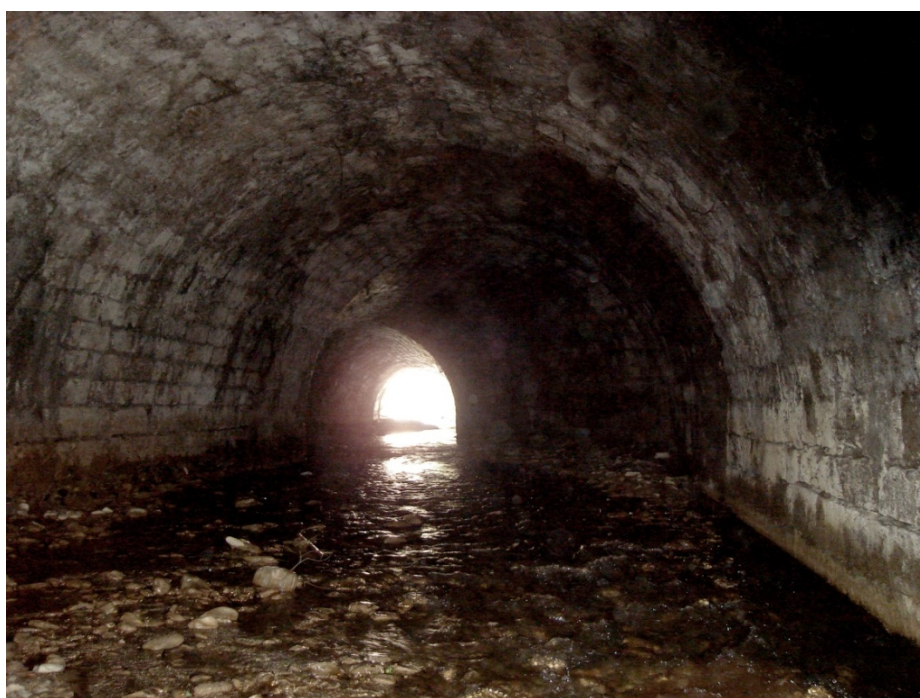
Fig. 52. Embovedado bajo Plaza Nueva (vista aguas arriba), Junio de 2011.
