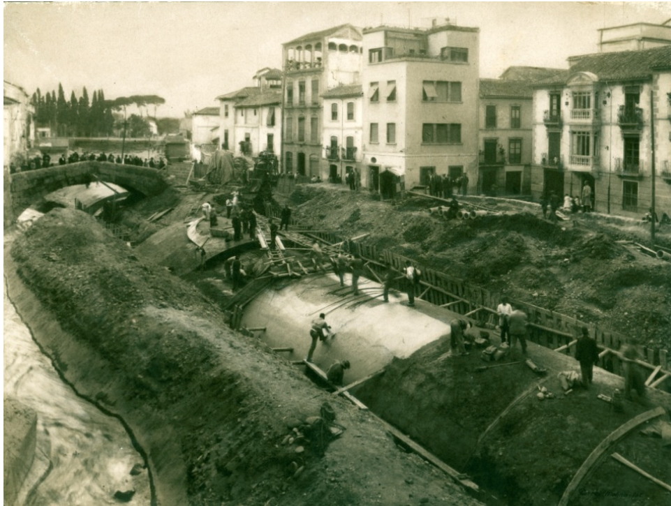
Fig. 64. Obras del último tramo de embovedado, en 1937 (AHMG).
