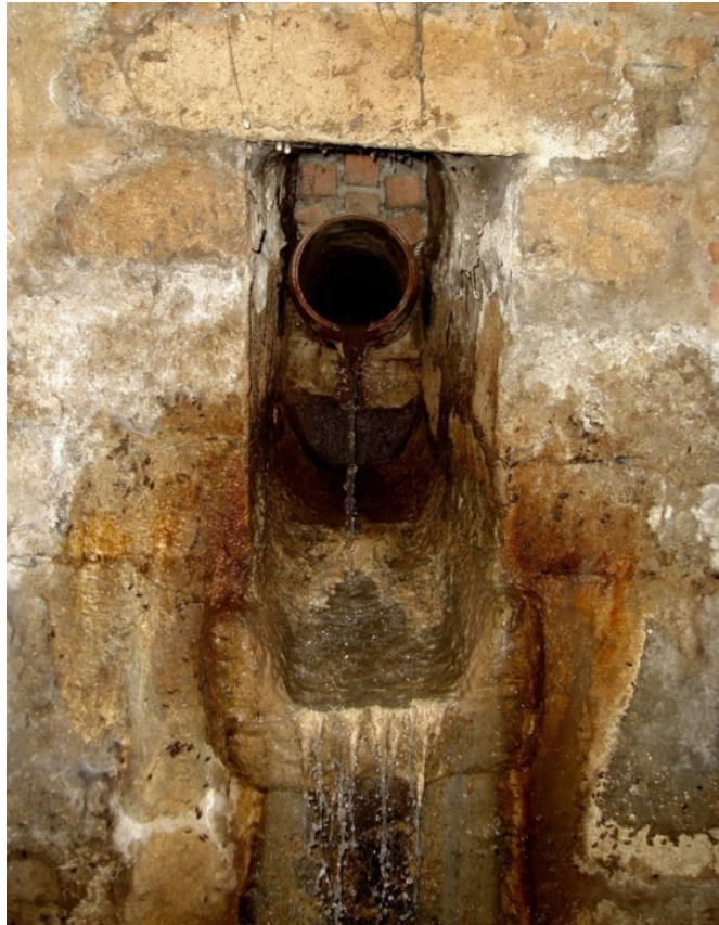
Fig. 81. Acometida de alcantarilla al interior del embovedado, Junio 2011.
