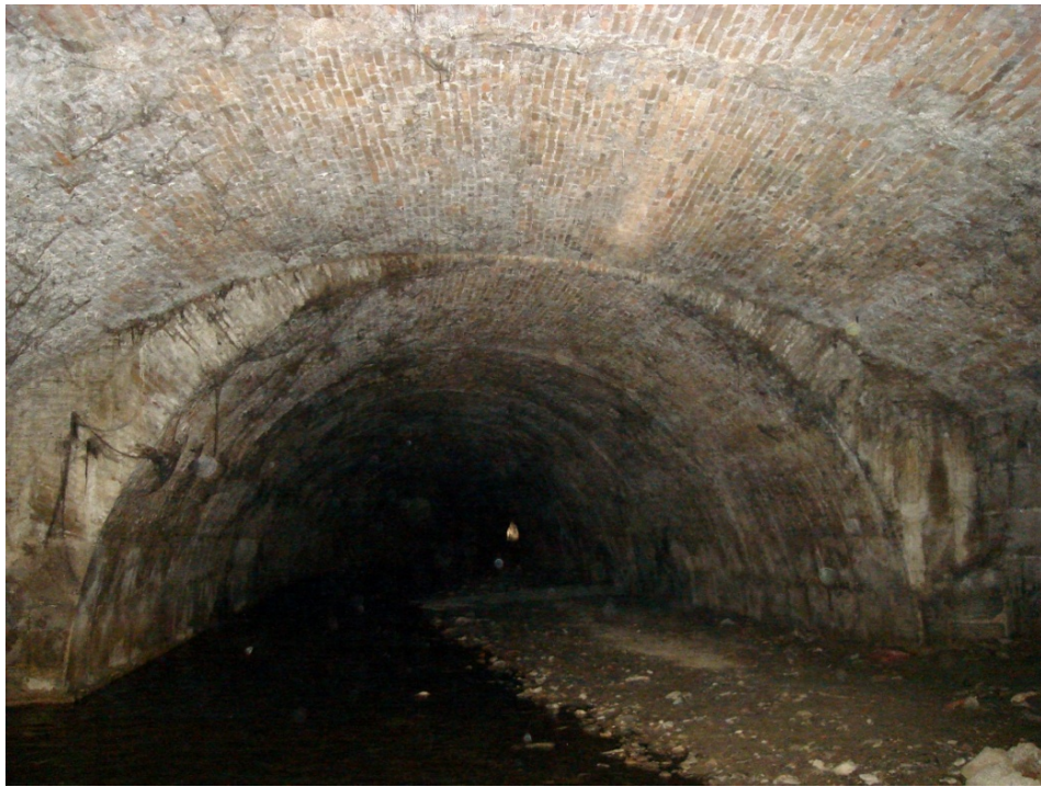
Fig. 62. Enlace de las bóvedas de San Francisco y Plaza Nueva (visto aguas arriba. Al fondo, principio del embovedado), Junio de 2011.
