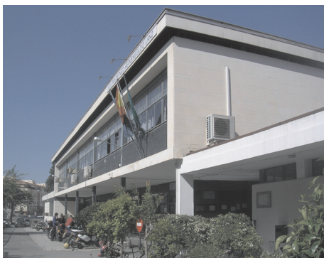
10. IMAGEN DE LA ESCUELA DE MAESTRÍA INDUSTRIAL. ARQUITECTO, PFEIFER DE FORMICA-CORSI, 1962-1968.
