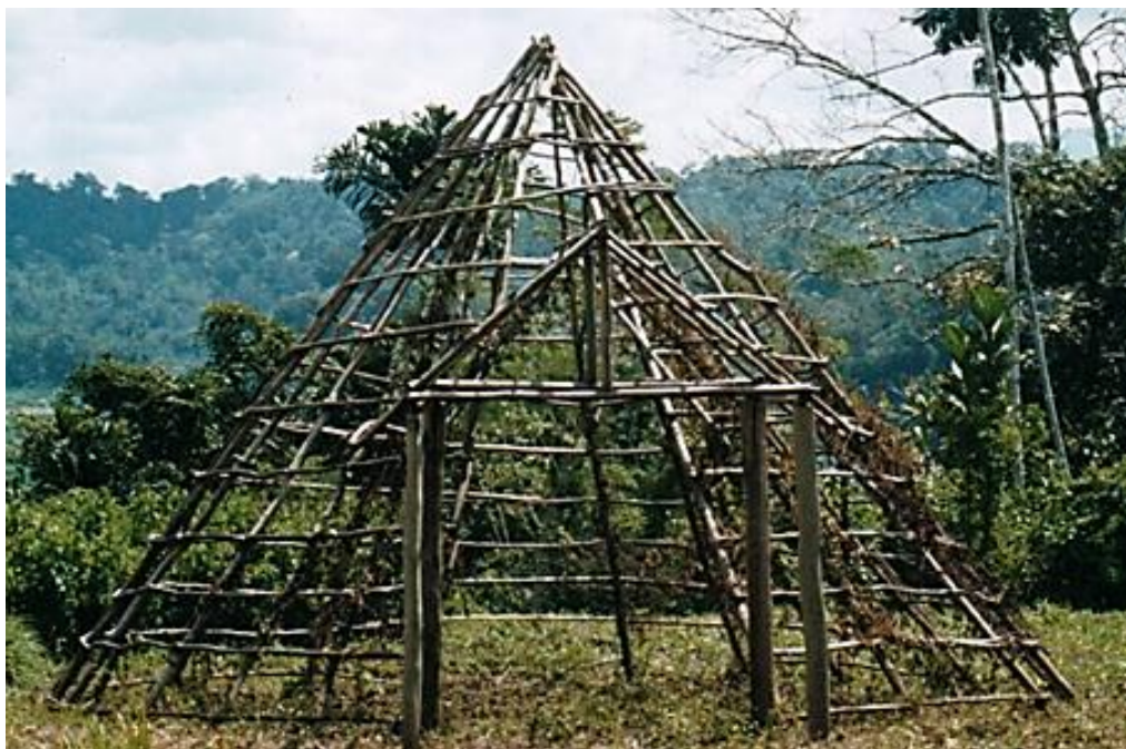
Figura 4.7. Estructura del Ú-SuLé sin la colocación de la superficie del tejido del techo, Shiroles-Talamanca, 2005.
