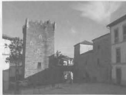
20.2. La torre y el palacio de Salas, estado actual, foto del autor, 2004.
