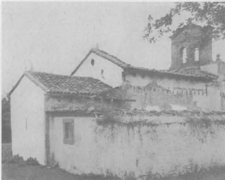
8.2. Iglesia de San Salvador de Fuentes tras su incendio, 1936. RNAn3_1941-AS_SSalvadorFuentes_ft01.jpg. "Asturias: Destrucciones habidas en sus monumentos durante el dominio marxista. Trabajos de protección y restauración efectuados o en proyecto". Revista Nacional de arquitectura (RNA), nº 3, Madrid, 1941.
