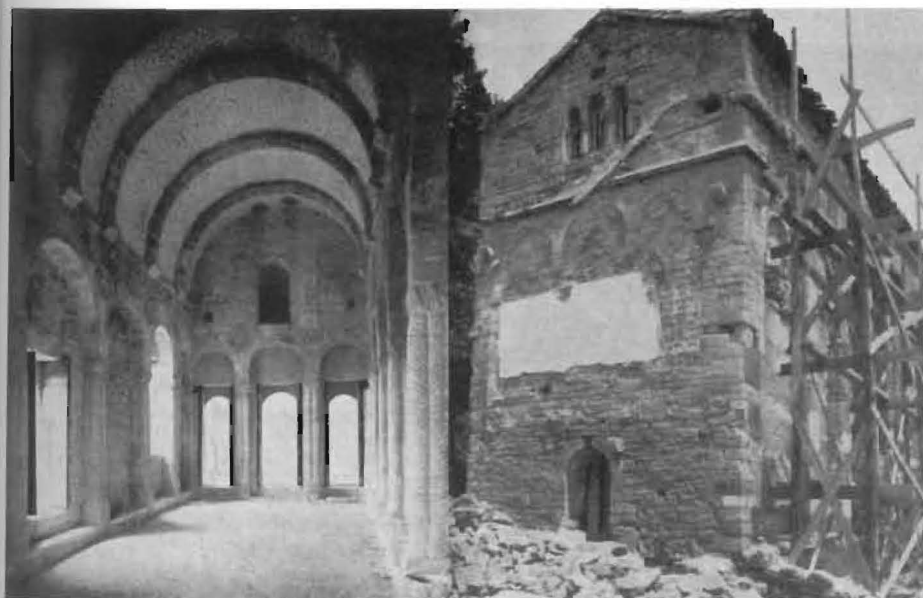
Santa María del Naranco durante el proceso de liberaciones (arriba) y proyecto de restauración de la fachada oriental. Luis Menéndez-Pidal, 1949. Archivo General de la Administración, Alcalá de Henares (Madrid). Expedientes de obra.
