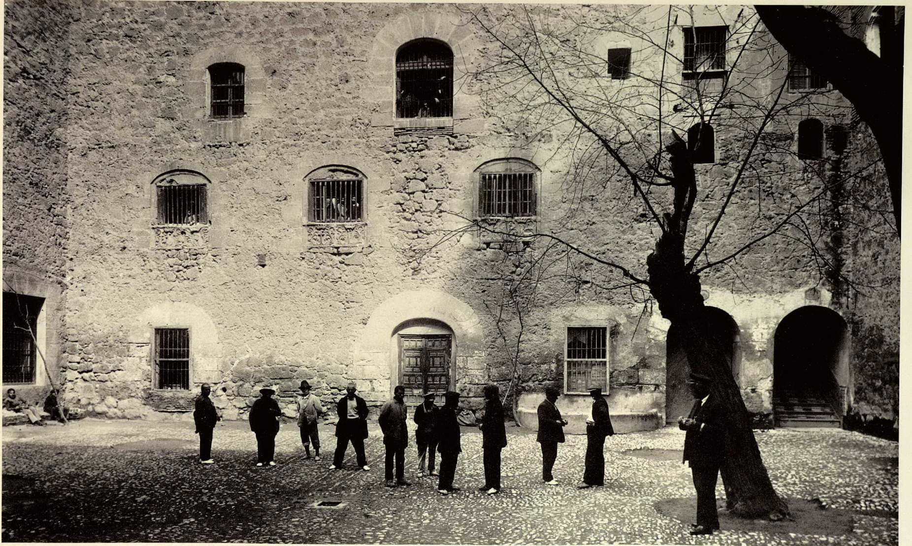
PATIO DE LOS LOCOS
