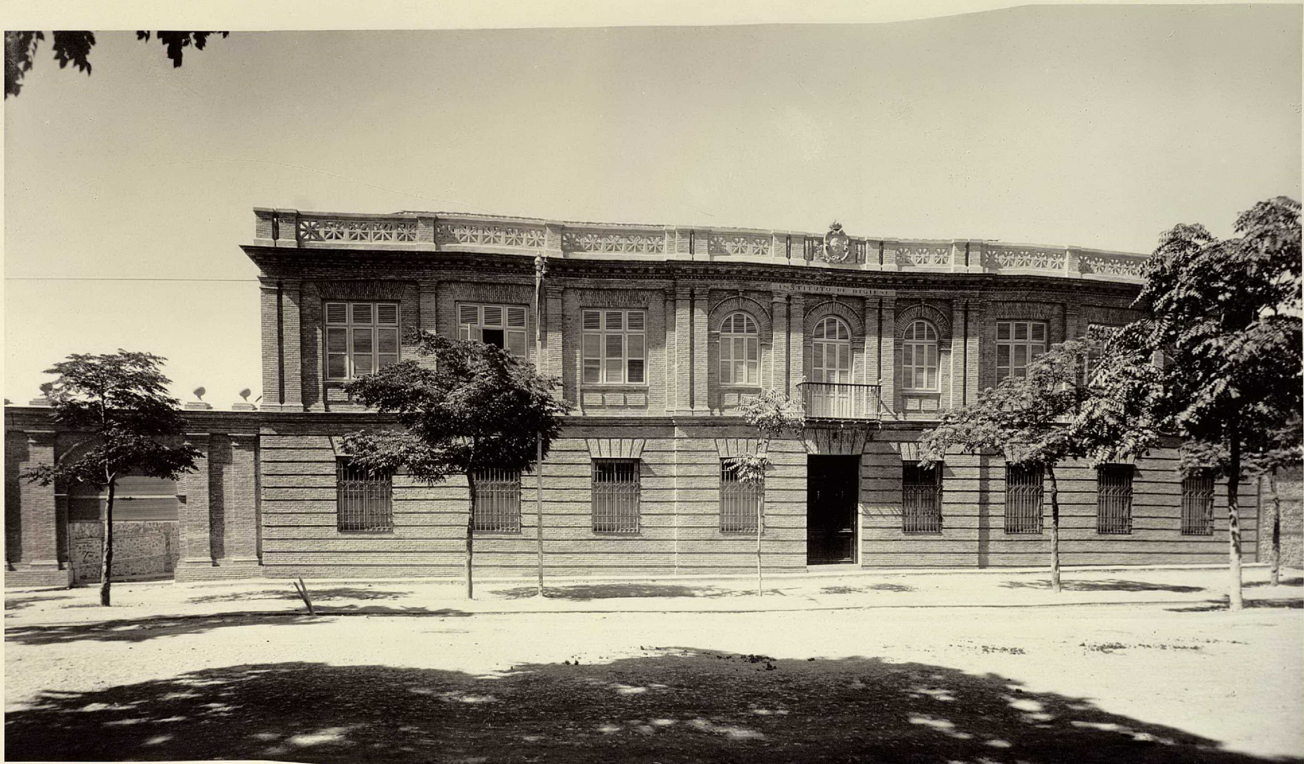
INSTITUTO PROVINCIAL DE HIGIENE - FACHADA PRINCIPAL
