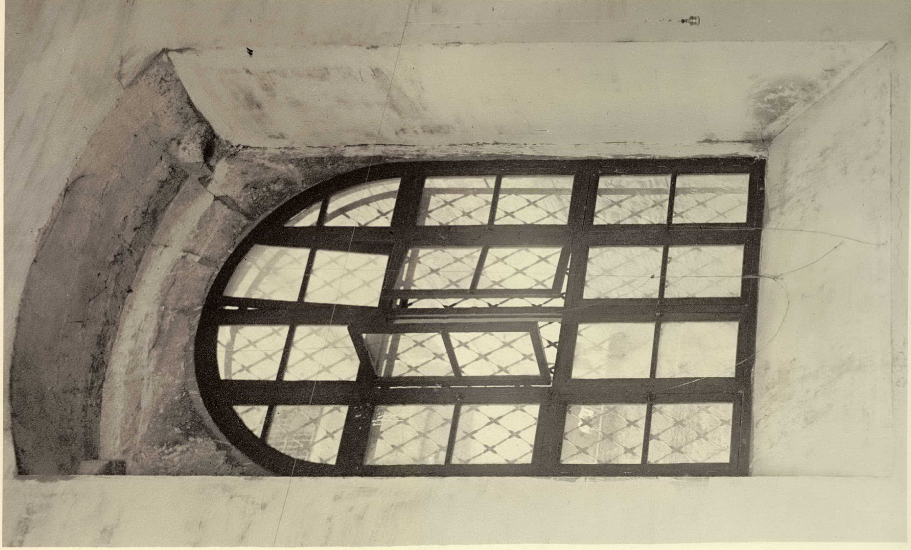
REJA DE NUEVA CONSTRUCCION EN LA SALA DE LA ESCUELA
