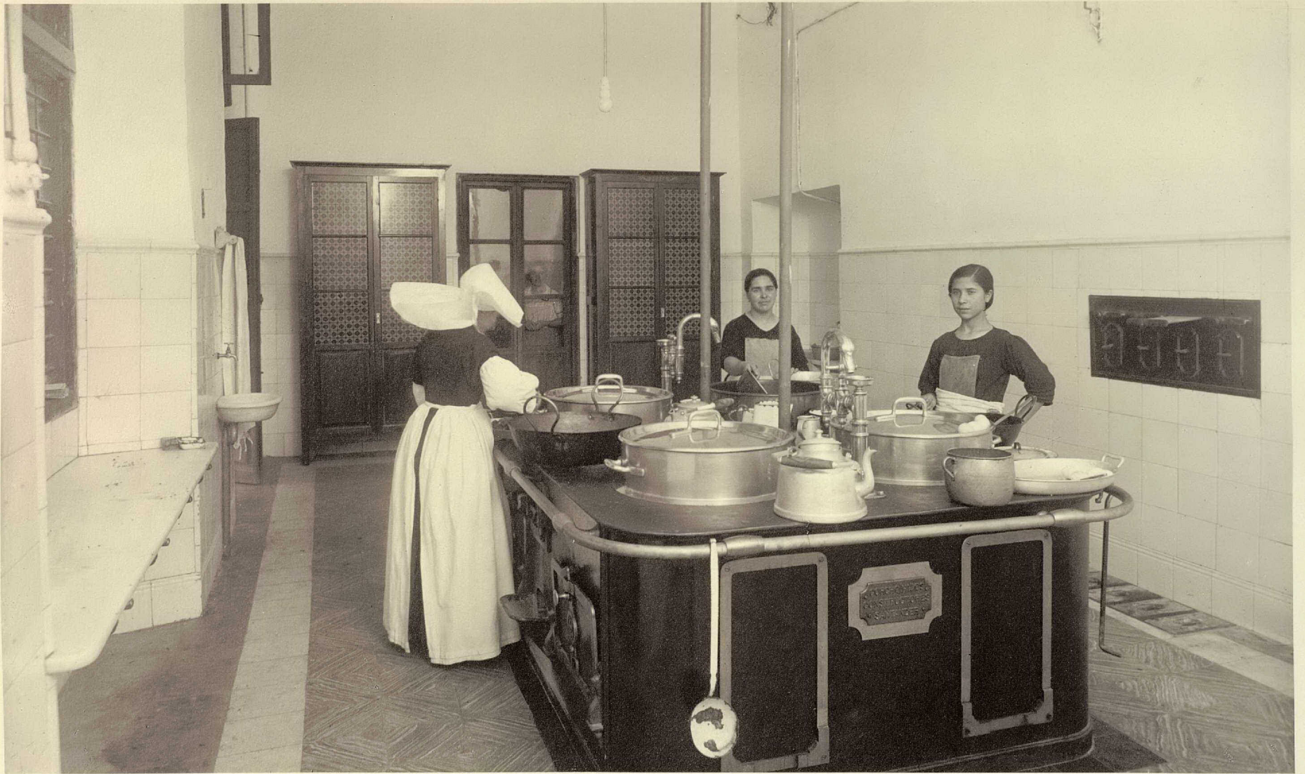
COCINA GENERAL DEL ESTABLECIMIENTO
