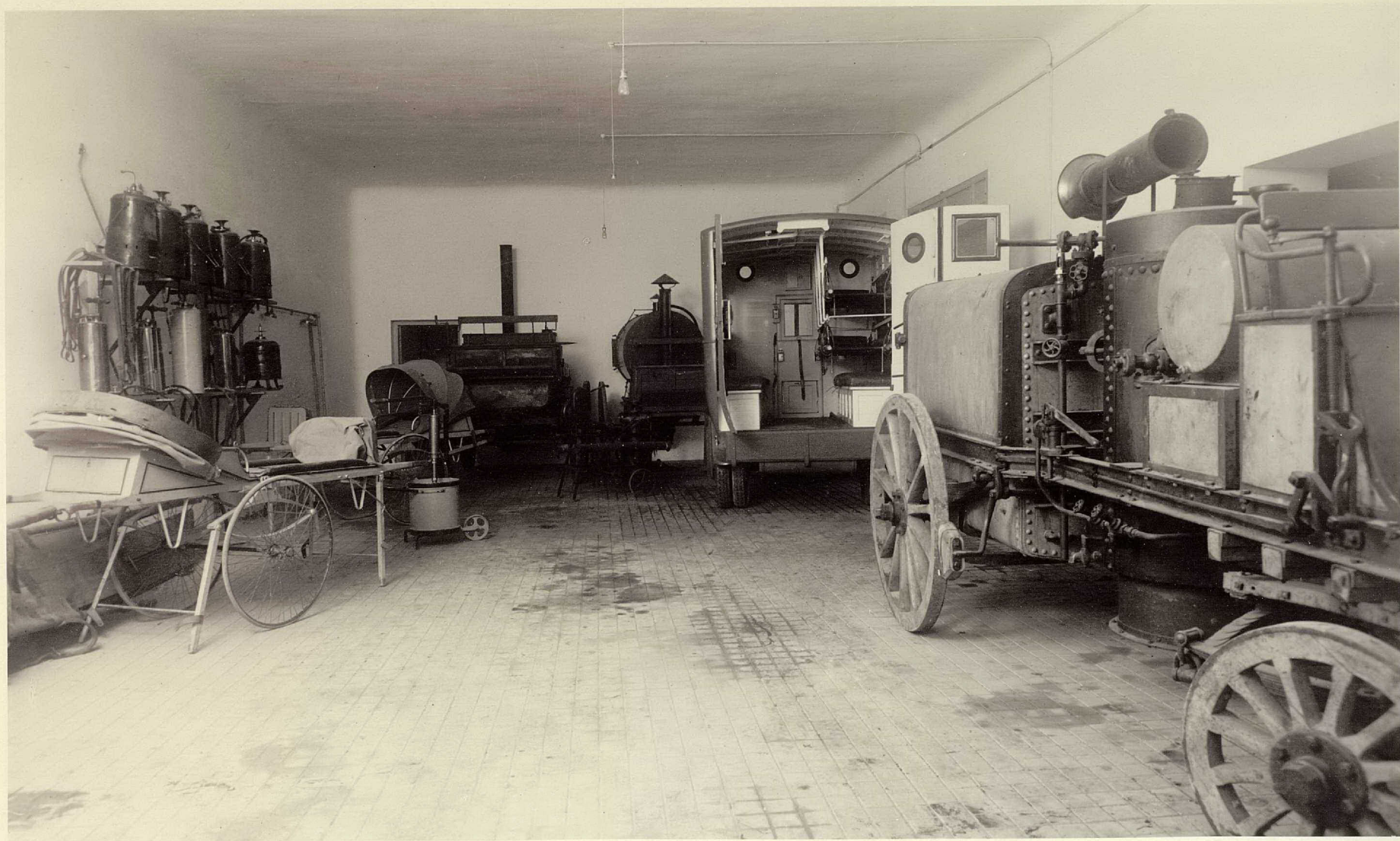
PARQUE DE DESINFECCION
