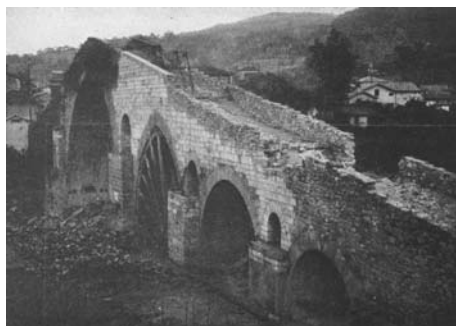
El puente de Cangas de Onis durante los trabajos de restauración, véase la discriminación entre fábricas añadidas y originales. Foto Luis Menéndez-Pidal, 1942
