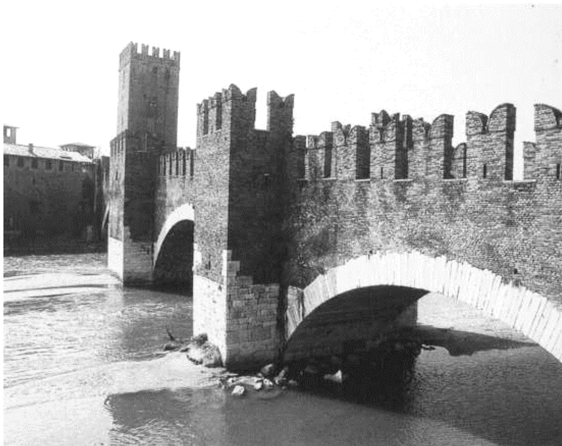
Puente de Pietra , Castelvecchio, tras la reconstrucción de Gazzola
