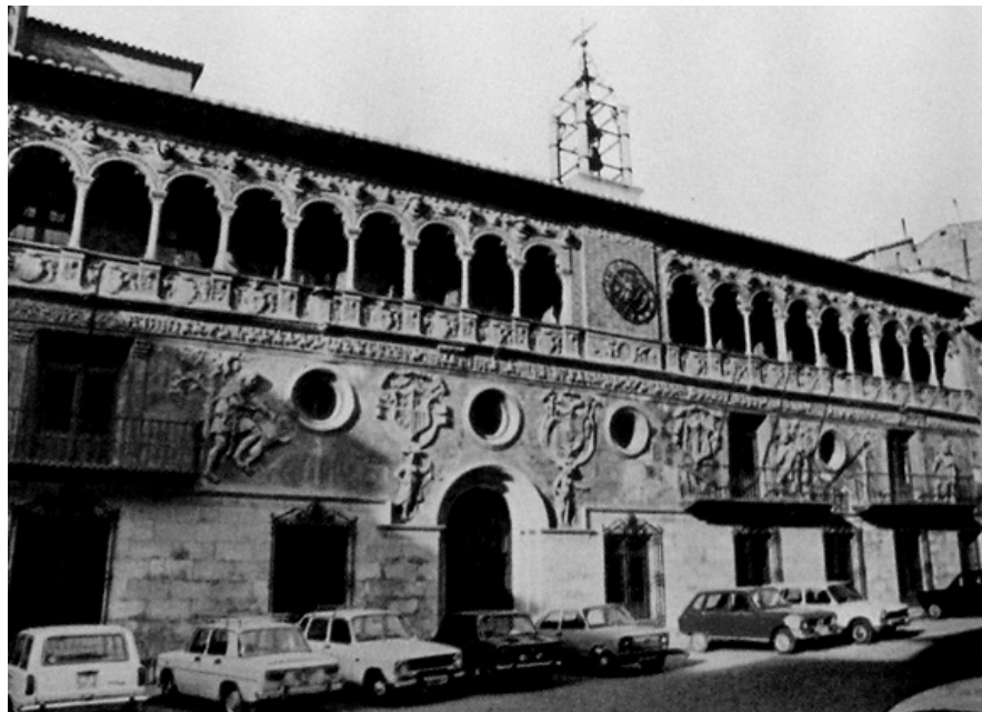
Recomposición del cuerpo superior del Ayuntamiento de Tarazona. Estado previo (arriba) y estado reformado (dcha). Fernando Chueca Goitia
