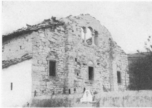
Iglesia de San Pedro de Nora tras el incendio de sus cubiertas, 1936
