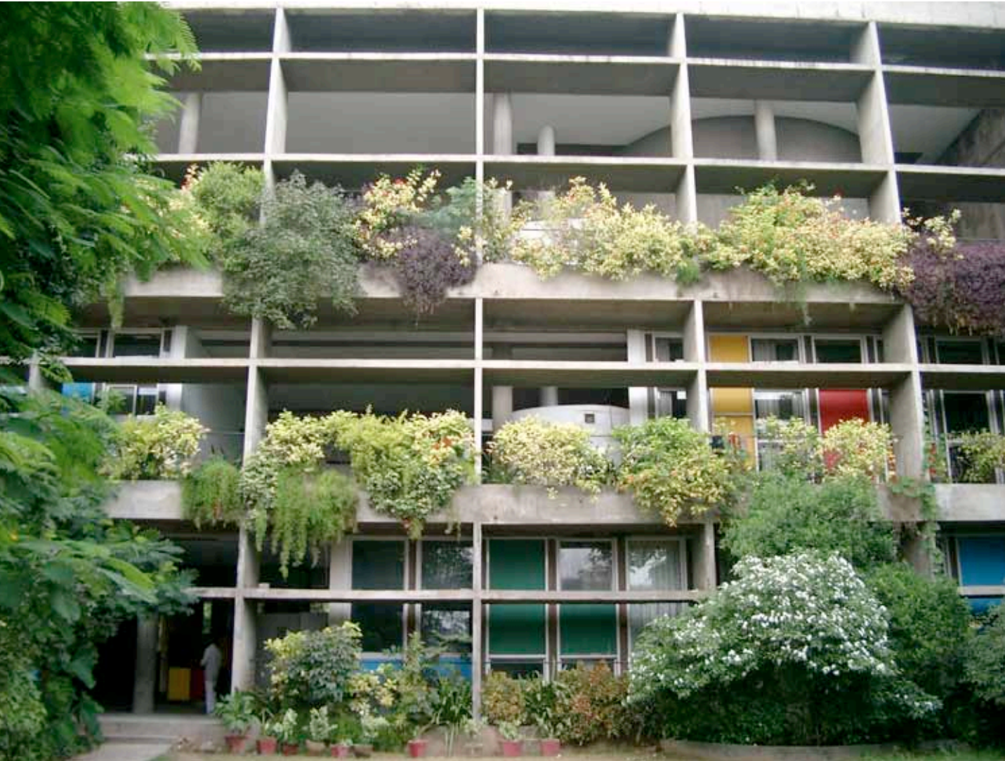
Imagen actual de la fachada del edificio de la Asociación de Hilanderas de Ammedabad, India, 1952-54. Le Corbusier.
